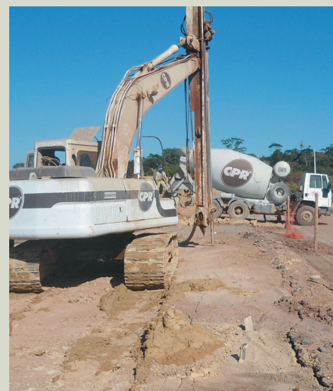
Figura 8 - Melhoramento do solo com CPR Grouting, em uma rodovia no interior de Pernambuco.
