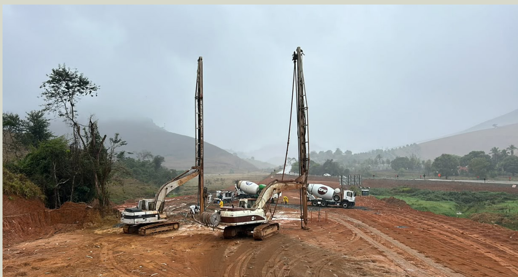
Figura 9 – Execução do melhoramento de solos moles por meio do CPR Grouting. Vista geral da frente de trabalho, destacando os equipamentos de perfuração e formação dos bulbos empregados no tratamento do maciço. A intervenção busca melhorar as propriedades geotécnicas do solo, aumentando sua resistência e rigidez, reduzindo sua compressibilidade e proporcionando melhores condições de estabilidade e controle dos recalques na construção da BR 356.
