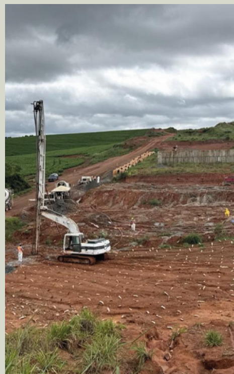
Fig. 3 - Melhoramento do solo na BR 356, em Ervália, MG.
