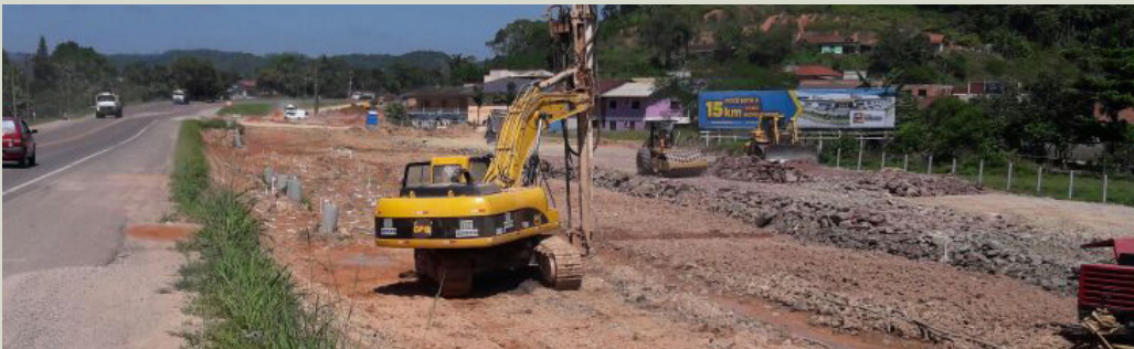
Fig. 9 - Duplicação rodoviária com melhoramento do solo com CPR Grouting.
