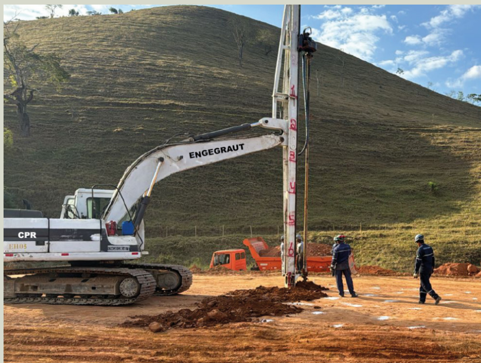
Figura 2 – Melhoramento de solos moles com CPR Grouting. Execução de tratamento geotécnico em depósito de solo mole. Enquanto o pré-carregamento promove o adensamento por meio da aplicação de sobrecargas externas, o CPR Grouting atua diretamente no interior do maciço, mediante expansão controlada de cavidades, induzindo alterações no estado de tensões, dissipação de poropressões e aumento da resistência e rigidez do solo.
