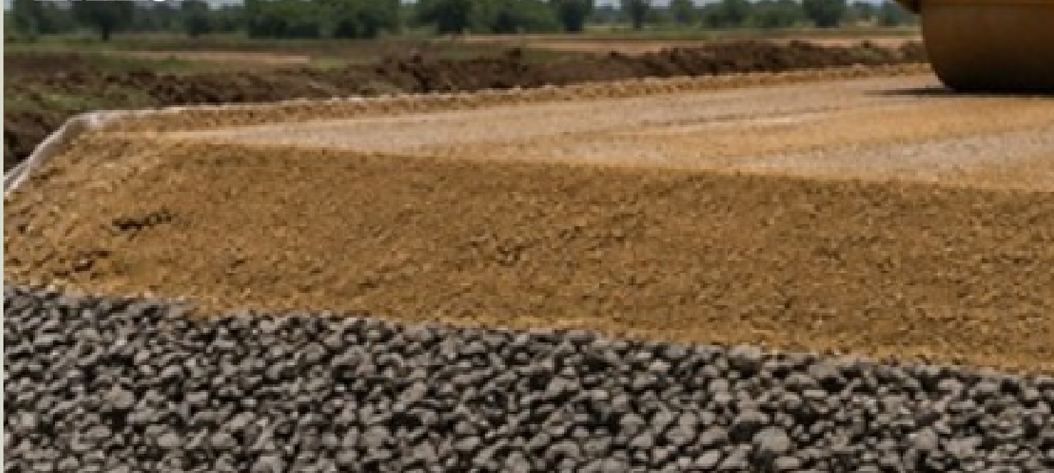
Figura 1 – Execução de aterro sobre solo mole, com utilização de pré-carregamento. A compactação das camadas do aterro integra o processo construtivo, enquanto o carregamento imposto ao terreno promove o aumento das tensões totais e a geração de excessos de poropressão na fundação. Com a dissipação gradual dessas poropressões, ocorre o adensamento do solo mole, acompanhado de recalques e aumento progressivo da resistência ao cisalhamento. Esta técnica não consegue adensar camadas de solo mole profundas.
