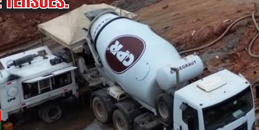
Fig. 1 - Figura 1 – Execução do CPR Grouting em depósito de solo mole, com aplicação controlada de grout para formação sequencial de bulbos em profundidade. O processo promove a expansão de cavidades, modificando o estado de tensões do maciço, aumentando as tensões efetivas e favorecendo o adensamento e o ganho de resistência do solo.
