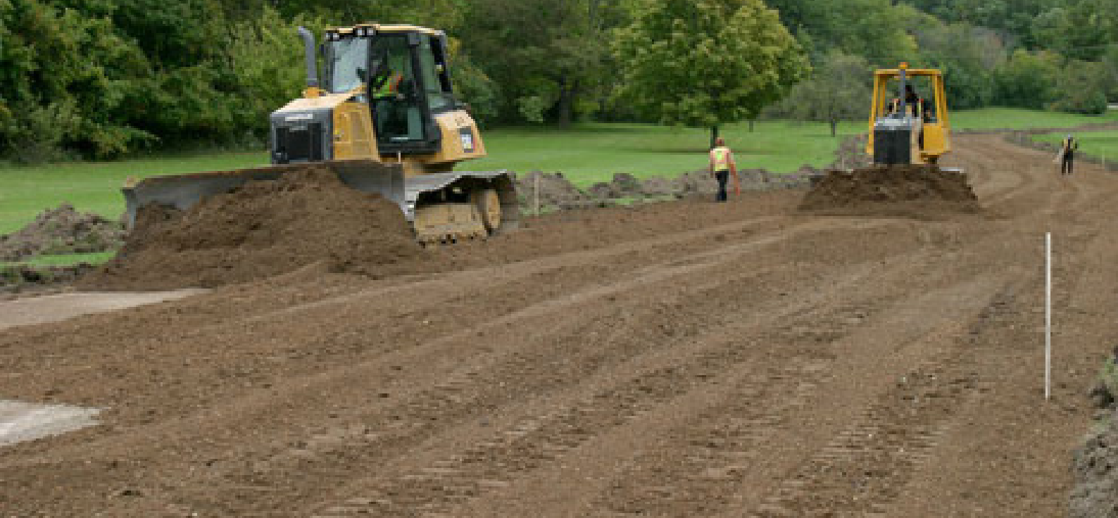
Fig. 4 - Formação de um aterro estradal.
