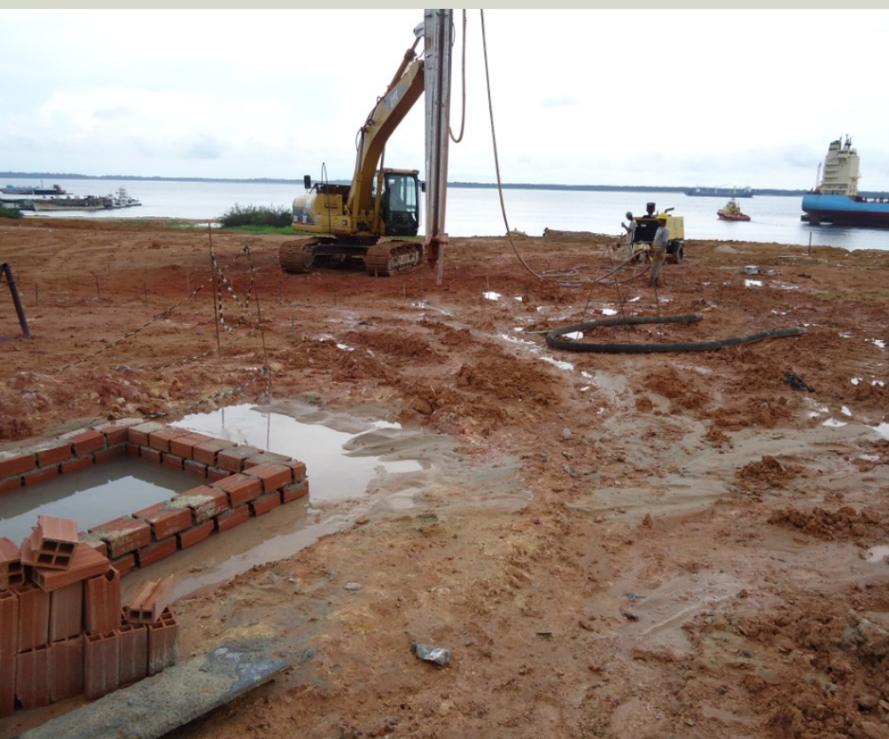
Fig. 2 - Obras de melhoria de solo em ambiente portuário ilustram um dos maiores desafios da engenharia geotécnica moderna: transformar depósitos sedimentares altamente compressíveis em plataformas aptas a receber estruturas de grande porte, reduzindo recalques e aumentando a confiabilidade das obras costeiras.
