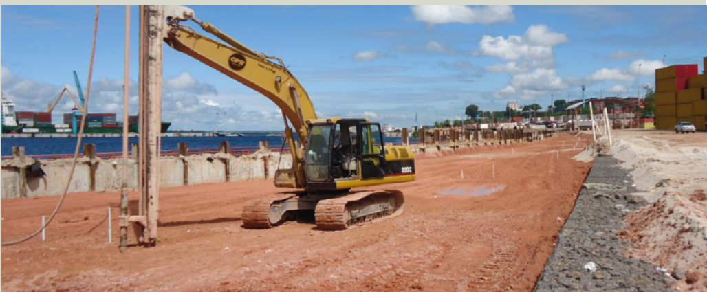
Fig. 3 - Execução do melhoramento de solo mole em área portuária, junto ao cais operacional, utilizando equipamento de CPR (Consolidação Profunda Radial). A intervenção foi realizada em ambiente com elevada restrição operacional e presença de infraestrutura existente, demonstrando a viabilidade da técnica para aumentar a rigidez do maciço, reduzir recalques futuros e preparar a fundação para novos pátios e estruturas logísticas, sem necessidade de longos períodos de pré-carregamento. O controle geométrico e a execução sequencial das verticais permitem compatibilizar produtividade, segurança e desempenho geotécnico em obras portuárias sobre depósitos sedimentares compressíveis.
