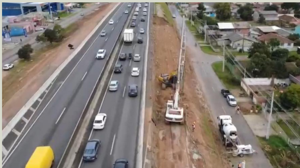
Fig. 2 - Vista aérea de uma ampliação rodoviária executada sobre solo mole, ilustrando a interação entre a pista existente e a nova plataforma em execução. Nesta condição, o comportamento do maciço é fortemente influenciado pela trajetória de tensões induzida pelas etapas construtivas, tornando essencial o controle das deformações e da estabilidade global.
