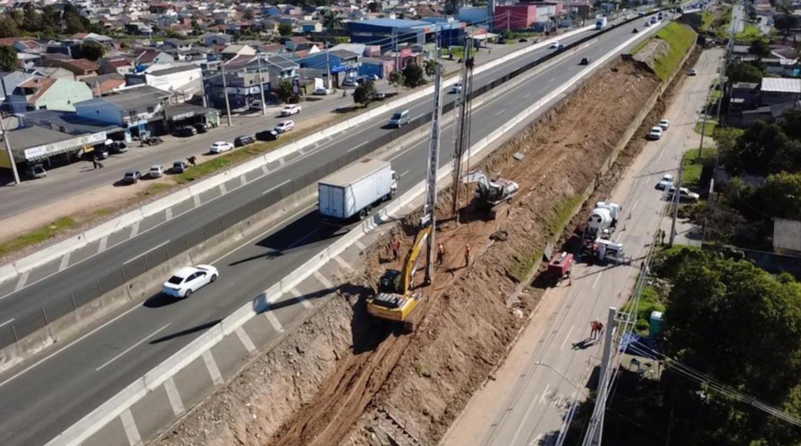
Fig. 4 - Aplicação do CPR Grouting em obra de ampliação rodoviária sobre solo mole. O processo modifica o estado de tensões do maciço, favorecendo a redistribuição tridimensional das tensões, o aumento da rigidez e o controle dos deslocamentos induzidos pelo aterro.
