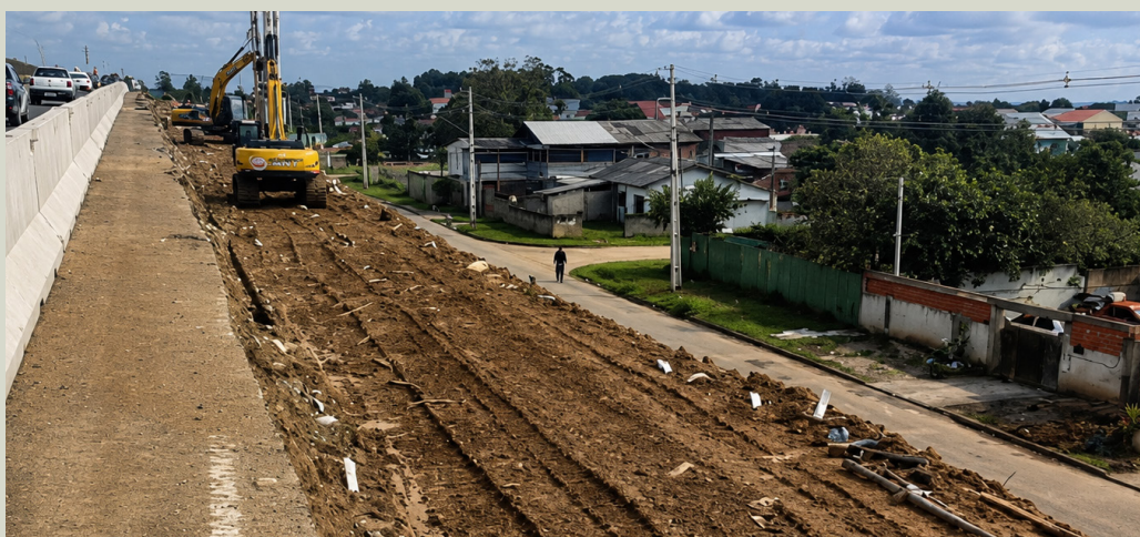
Fig. 6 - CPR Grouting em andamento em uma rodovia federal. A melhoria do comportamento geotécnico do maciço permite maior controle do processo de recalque e dos deslocamentos laterais, favorecendo a estabilidade da plataforma durante a execução das sucessivas etapas do alteamento.
