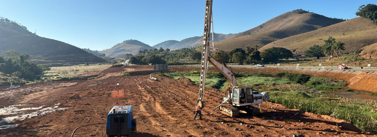
Fig 19 - Melhoria do solo de fundação para receber 11m de aterro, necessário a construção de rodovia federal, BR - 265, em Passos de Minas, MG.
