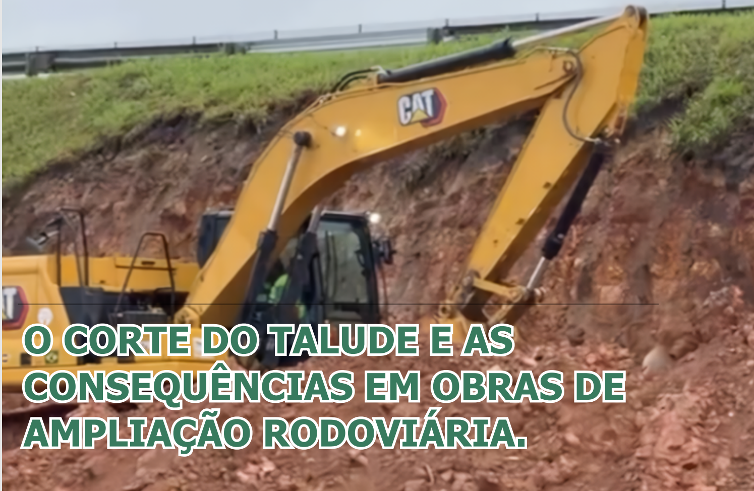
Figura 1 - Cortar é rápido. Estabilizar é indispensável, pois o talude define o desempenho da duplicação rodoviária. A remoção abrupta do confinamento lateral altera o estado de tensões, reduz a resistência disponível e desencadeia deformação quando há presença de solo mole.
