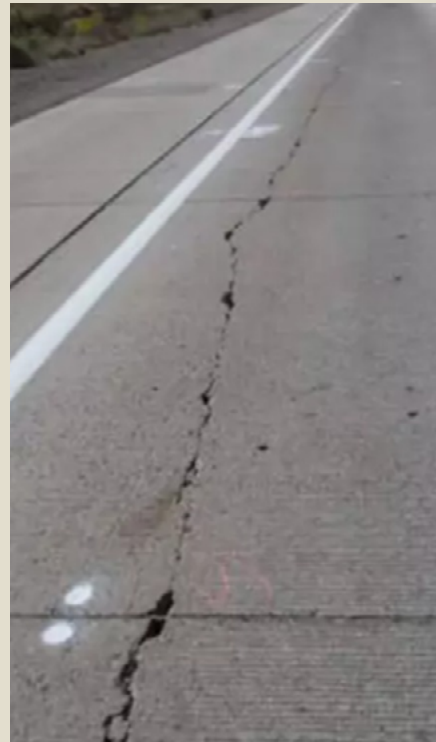
Figura 3 - Trinca longitudinal no pavimento ampliado.
