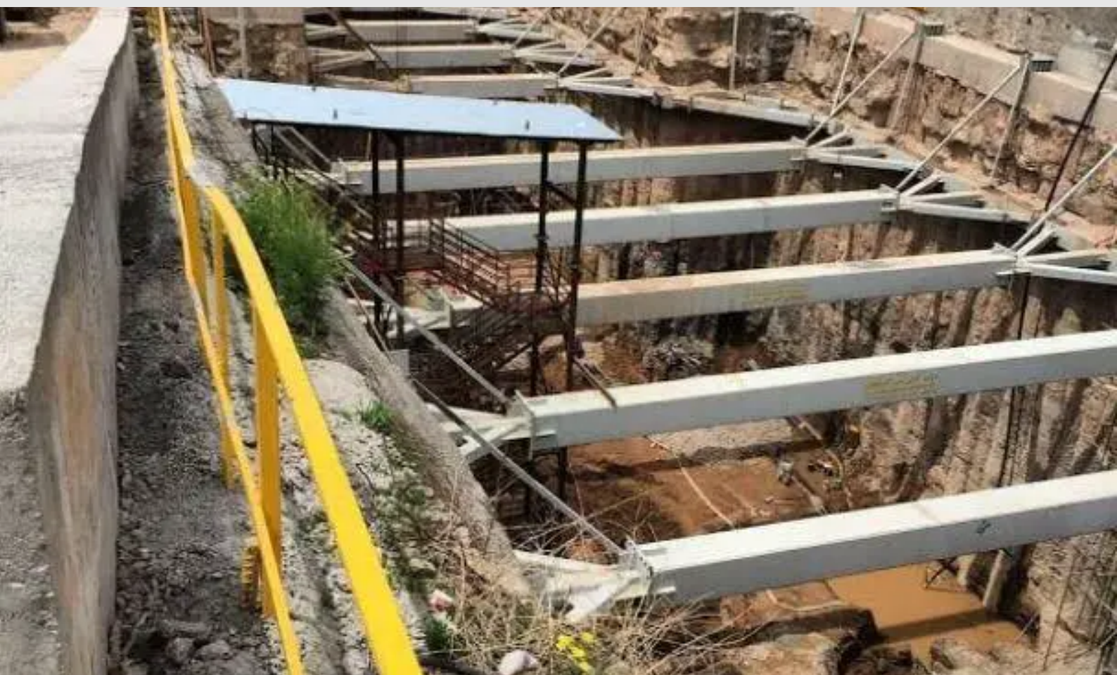
Figura 2 - Escavações rompem o equilíbrio do maciço. O processo deformativo é apenas a manifestação viável desse equilíbrio. No solo mole, a redistribuição das tensões e a dissipação da poropressão controlam o padrão deformativo muito antes da mobilização da resistência última.
