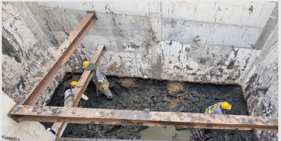
Figura 6 - Após duas a três semanas do melhoramento do solo, observa-se a plena estabilização do fundo da escavação, mesmo com solo extremamente mole e orgânico, com NA aflorando. A ausência de água livre evidencia a significativa redução da poropressão, resultante do processo de consolidação induzido. O ganho de resistência ao cisalhamento permite a escavação segura, sem ocorrência de instabilidades ou bombeamento. Este comportamento comprova a eficácia do geoenrijecimento do maciço. Soluções como o CPR Grouting promovem condições reais de trabalho em solos anteriormente impraticáveis.
