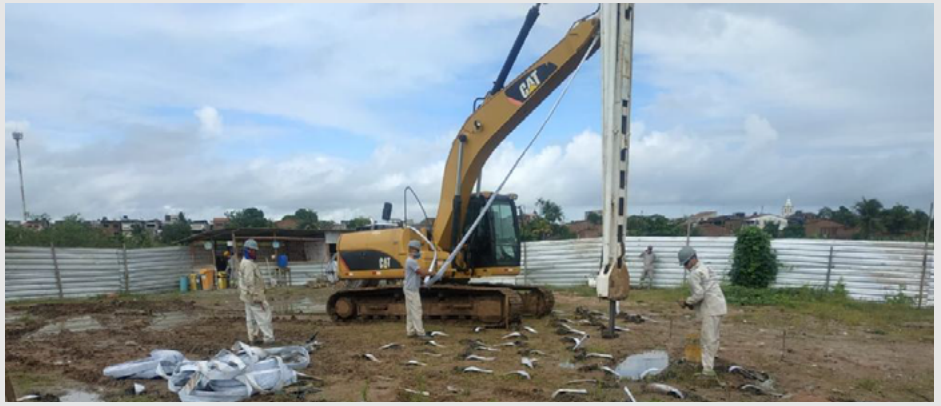
Figura 5 - Estação de Tratamento de Esgoto (ETE) em Recife, em área com presença de solo extremamente mole e turfoso, com baixa resistência, elevada compressibilidade e NA aflorando. A intervenção prevê melhoramento do solo em profundidade de até 18 metros, visando aumentar a rigidez do maciço e garantir a estabilidade da escavação que vai a 12m, além da estrutura futura. A atuação neste tipo de solo exige soluções que promovam ganho efetivo da resistência, controle do recalques e do NA. O processo executivo já evidencia a necessidade de controle técnico rigoroso, desde a execução até o monitoramento. O melhoramento do solo é condição essencial para a segurança e viabilidade da obra.
