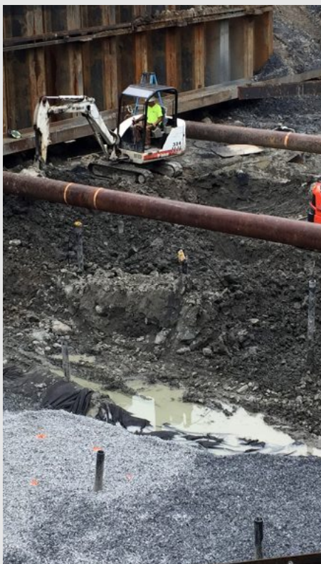
A aplicação do geoenrijecimento, com CPR Grouting, promove o aumento da rigidez e da resistência do solo, reduzindo deformações e garantindo maior controle do comportamento do maciço durante a etapa construtiva. Mais do que conter o solo, trata-se de controlar o seu estado de tensões, assegurando estabilidade, segurança e previsibilidade em escavações complexas
