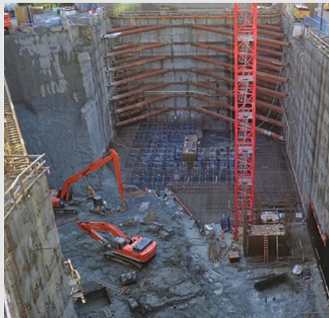
Figura 5 - Escavações profundas em solos moles impõem alterações significativas no regime de poropressões, podendo induzir instabilidade global e recalques excessivos em estruturas adjacentes. O controle da dissipação das poropressões é determinante para a segurança e o desempenho dessas escavações. A redução controlada da poropressão contribui diretamente para o aumento da tensão efetiva e, consequentemente, da resistência ao cisalhamento do solo. Soluções que promovem o geoenrijecimento prévio do maciço, associadas ao monitoramento geotécnico, permitem limitar deslocamentos e evitar mecanismos progressivos de ruptura. Nesse contexto, o melhoramento do solo se consolida como elemento essencial para garantir estabilidade, controle de recalques e segurança em áreas urbanas sensíveis.
