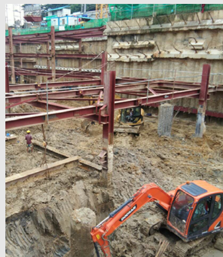
Figura 2 - O problema não é apenas escavar. É garantir que o solo permaneça estável durante todo o processo.
