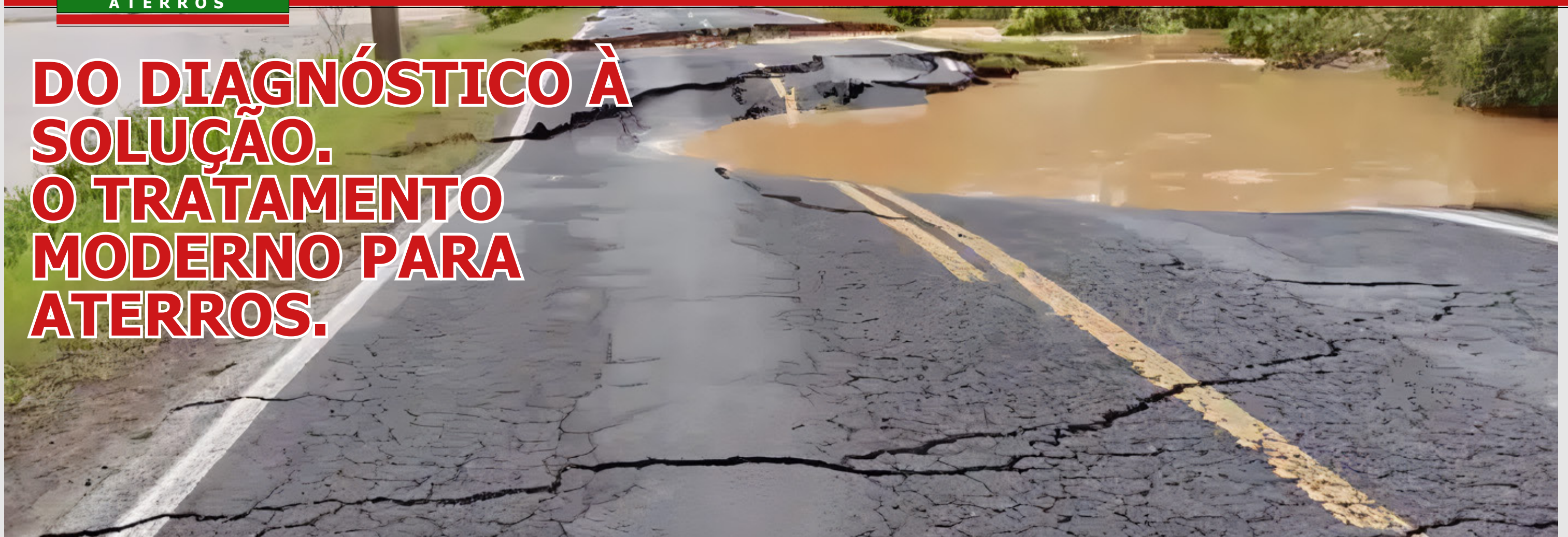
Figura 1 - Rompimento estrutural de pavimento rodoviário, por colapso do subleito, associado a alagamento/inundação. Observa-se fissuração generalizada em malha no asfalto, perda de suporte do subleito, rutura transversal com degrau estrutural, significando recalque diferencial brusco, invasão de água sobre a pista, com elevação do nível freático e/ou extravasamento lateral e desagregação das bordas, induzindo erosão interna (piping) e carreamento de finos. O diagnóstico geotécnico possível é a falha por saturação de solo mole ou arenoso mal drenado, com perda de resistência ao cisalhamento, levando ao colapso do pavimento. Pode envolver erosão regressiva, falha de bueiros/drenagem ou ruptura hidráulica do aterro. Em síntese, não é apenas dano superficial do pavimento, é a falha do maciço de fundação, exigindo intervenção geotécnica profunda (melhoramento do solo, drenagem e recomposição do aterro).
