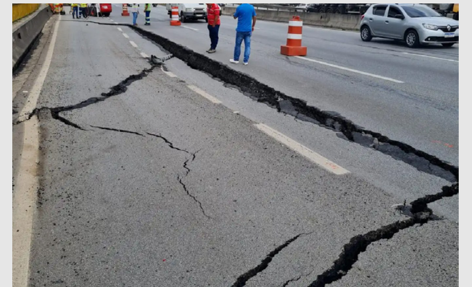
Figura 2 - Rutura geotécnica por falha do subleito. As fraturas abertas e o deslocamento vertical observados na pista caracterizam rutura estrutural do pavimento, associada a recalque localizado do subleito, e não um simples defeito superficial do revestimento asfáltico. O padrão transversal da trinca, com abertura significativa e degrau vertical, indica perda súbita de capacidade suporte do solo de fundação, típica de regiões com solos moles saturados, erosão interna por deficiência de drenagem ou aterros executados sem melhoramento adequado. O colapso do pavimento, ocorre por flexão e cisalhamento da estrutura, após perda do confinamento inferior. Intervenções limitadas ao recalqueamento são ineficazes. A solução tecnicamente correta exige readequação profunda do maciço, com melhoria do solo, recomposição da drenagem e reconstituição estrutural da pista.
