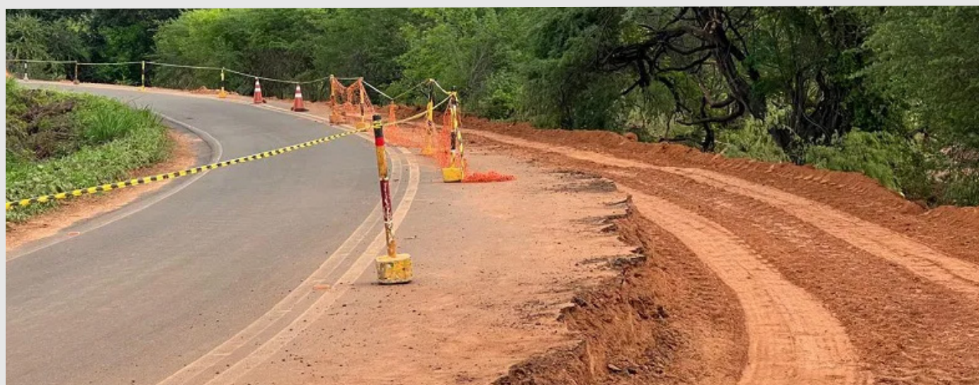
Figura 7 - Observa-se início de instabilidade no bordo externo da pista, com escavação recente e perda de confinamento lateral do maciço. O talude de corte, em solo aparentemente argiloso e parcialmente saturado, apresenta geometria desfavorável, com inclinação elevada e ausência de estrutura de contenção. A proximidade imediata da pista com o pé do talude instabilizado, associada à falta de drenagem superficial visível, indica risco real de ruptura progressiva, principalmente sob ação de chuvas. A sinalização de emergência reforça a condição de risco operacional, com possibilidade de recalque na borda da pista e perda de segurança viária. O mecanismo provável é a ruptura por cisalhamento rotacional superficial, induzida por desconfinamento, umidade e baixa resistência ao cisalhamento do solo.
