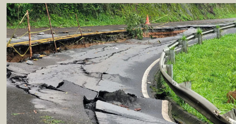
Figura 4 - ruptura progressiva do aterro rodoviário, associada à instabilidade do solo de fundação, observando-se trincas longitudinais e transversais no pavimento, indicando perda de suporte e deformações excessivas. Degráu e abatimento diferencial da pista, típico de recalque não uniforme. Ruptura do bordo externo do aterro, sugerindo cisalhamento do solo mole subjacente. Indícios de ação da água (infiltração e possível elevação de poropressão), reduzindo a resistência ao cisalhamento. O guarda-corpo acompanha a deformação, confirmando que não se trata apenas de falha superficial do revestimento, mas de falha global do maciço.
