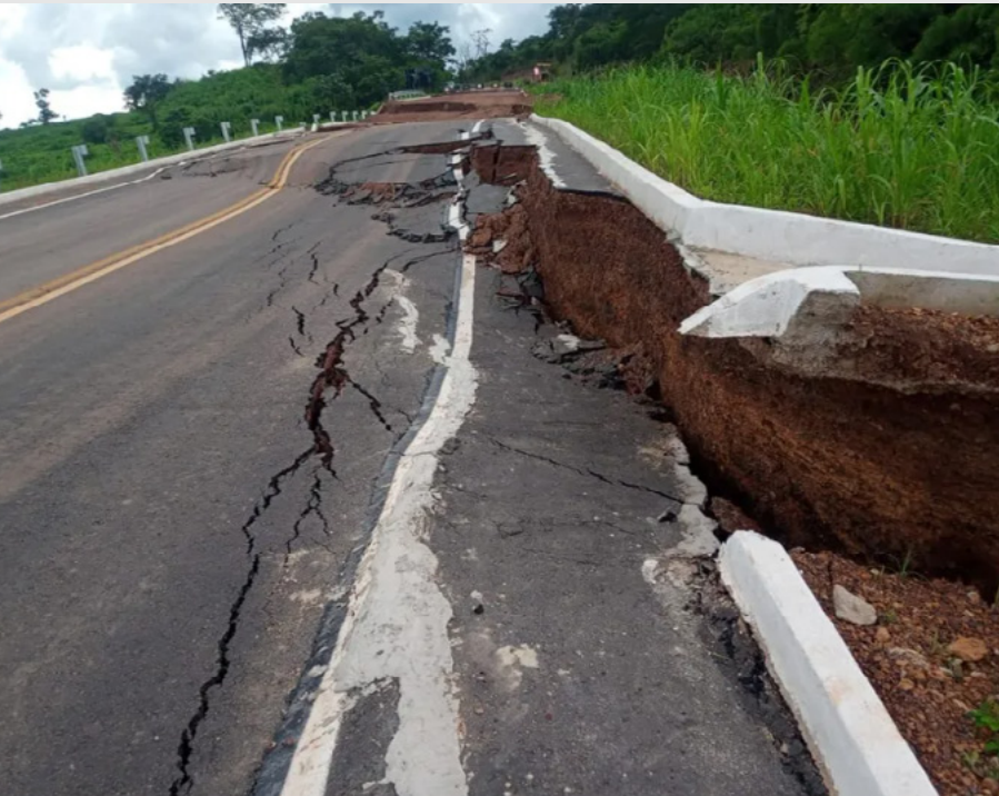
Figura 3 - Observa-se ruptura estrutural grave no bordo da pista, com fissuração longitudinal profunda, afundamento diferencial do pavimento e erosão intensa do talude lateral. O colapso do meio-fio e da contenção indica perda total de suporte do subleito, provavelmente causado por saturação do solo por falha de drenagem (infiltração contínua), erosão regressiva do talude, solo de baixa resistência ao cisalhamento (solo mole) e ausência ou ineficiência de proteção hidráulica lateral. O padrão das trincas e o rebaixamento da pista, caracterizam um mecanismo clássico de instabilização por recalque, associado à ruptura rotacional incipiente do talude, com evolução progressiva do dano. Ou seja, há risco crítico de colapso progressivo da pista, onde a interdição imediata é tecnicamente recomendável, exigindo estabilização do talude, drenagem profunda e melhoramento do solo de fundação.
