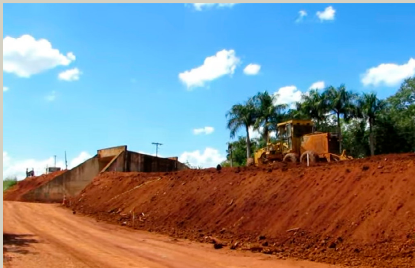
Figura 3 - Aterro e talude em formação, com solo avermelhado (provavelmente solo residual laterítico), apoiado sobre um terreno natural sem evidências visíveis de preparo prévio adequado da fundação. Observa-se a ausência de preparo do subleito, não observando-se escavação do solo superficial, regularização, nem qualquer tratamento prévio do terreno natural, indicando que o aterro pode estar sendo lançado diretamente sobre solo de baixa rigidez, muitas vezes orgânico, coluvionar ou altamente deformável. Observa-se contato direto aterro-solo natural, sendo este contato direto um dos principais gatilhos para recalques totais elevados e diferenciais ao longo do eixo, com perda de desempenho do pavimento no curto e médio prazo. Observa-se um talude íngreme e solo ainda “solto”. O aspecto do talude indica solo recém-lançado, ainda sem ganho de resistência, o que aumenta o risco de instabilidade superficial, favorecendo erosão regressiva e surgimento de trincas de tração no coroamento. Ausência de sistemas de drenagem visíveis, não observando-se longitudinais, drenos de pé de talude ou colchão drenante, o que é crítico em solos finos e tropicais, altamente sensíveis à variação de umidade. A implicação é que sem a readequação do solo de fundação, este tipo de solução tende a apresentar recalques excessivos e não uniformes, necessidade precoce de manutenção, risco de instabilidade global do aterro, especialmente em períodos chuvosos, e perda de capacidade estrutural do pavimento. Dependendo da investigação geotécnica seria recomendável promover o melhoramento do solo de fundação com geoenrijecimento.
