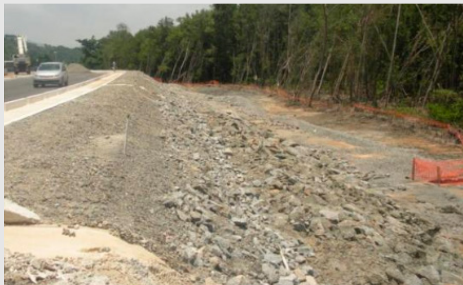
Figura 6 - Perigosa solução provisória, dependente da capacidade suporte do solo de fundação. Sem melhoramento do solo de fundação, o sistema permanece vulnerável a recalques excessivos, instabilidade do talude e perda de desempenho estrutural, ao longo do tempo. É, portanto, um aterro rodoviário lateral, implantado junto a uma área com solo natural muito pouco resistente, com vegetação preservada e uso de enrocamento/pedraplenagem na base, para “simular” estabilidade inicial. Na realidade, observa-se um talude construído com material grosseiro (rachão/brita graduada), atuando como camada de “reforço” e drenagem. Há ausência de estrutura de contenção rígida, indicando que a estabilidade depende essencialmente do peso próprio e do atrito interno do material. Evidentemente, já há presença de recalque diferencial e uma estabilidade global em andamento, já que há presença de solo mole subjacente. Aonde há a tela de tapume, é uma região crítica de transição, onde podem ocorrer trincas, deformações e perda de confinamento lateral. A inclinação (levantamento) da vegetação é, tecnicamente, um forte indício do início do movimento de massa, por ruptura progressiva, com indícios de empuxo Lateral induzido pelo aterro lançado, transmitido ao solo mole subjacente. Há sinais de cisalhamento incipiente na interface solo natural x faixa de influência do aterro, além de deformação lateral lenta (creep) antecedendo a ruptura global, com perda do confinamento lateral do maciço natural, fazendo a vegetação tombar no sentido do deslocamento. Em resumo, caracteriza-se uma fase pré-ruptura, ainda antes da formação de uma superfície de deslizamento bem definida, exatamente o estágio mais perigoso, porque a ruptura pode evoluir de forma súbita a partir deste ponto.
