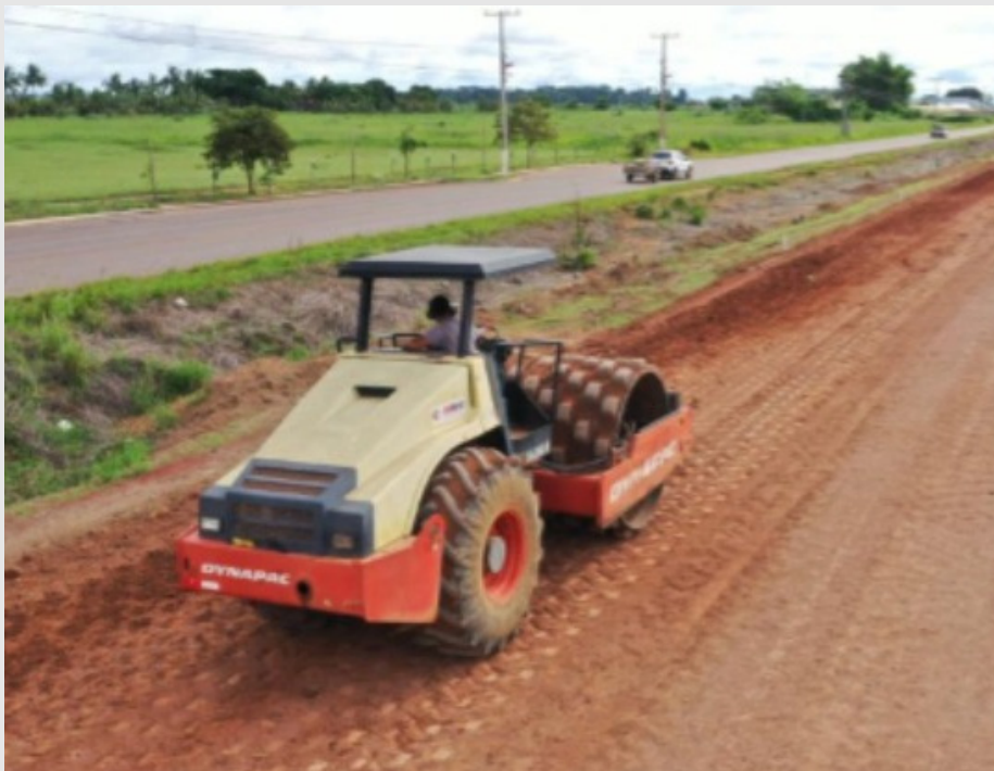
Figura 5 - Execução de aterro de sobrecarga com compactação superficial por rolo pé-de-carneiro. Sobre solos compressíveis ou moles, a solução apresenta limitações importantes, como carregamento não controlado sobre solo mole, onde o aterro aumenta rapidamente as tensões verticais, podendo levar o solo mole a estados próximos ou acima da ruptura, sem ganho proporcional de resistência. Promove Recalques excessivos e de longa duração, já que a consolidação ocorre lentamente, gerando recalques totais elevados e, principalmente, recalques diferenciais, que comprometem o desempenho do pavimento. Promove risco de instabilidade global, pois o aumento da carga pode induzir rupturas por cisalhamento, escorregamentos laterais e deformações progressivas do aterro. Gera compactação apenas superficial, pois a ação do rolo é limitada às camadas superiores do aterro, não melhorando o solo mole subjacente, que permanece fraco e altamente deformável. Causa dependência de tempo e grandes volumes de material, já que a sobrecarga exige longos períodos de espera para dissipação de poropressões e grandes volumes de solo, impactando custo, prazo e logística. Em resumo, o aterro de sobrecarga atua como uma solução passiva, baseada apenas no peso adicional, com baixo controle geotécnico. Em solos moles, tende a gerar recalques elevados, instabilidade e incertezas de desempenho, tornando-se tecnicamente inferior a métodos de melhoramento ativo do solo, que aumentam resistência e rigidez do maciço tratado. O resultado são rodovias com altos e baixos, tornando-as perigosas.
