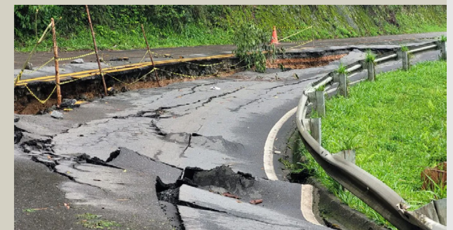
Figura 4 - ruptura progressiva do aterro rodoviário, associada à instabilidade do solo de fundação, observando-se trincas longitudinais e transversais no pavimento, indicando perda de suporte e deformações excessivas. Degráu e abatimento diferencial da pista, típico de recalque não uniforme. Ruptura do bordo externo do aterro, sugerindo cisalhamento do solo mole subjacente. Índícios de ação da água (infiltração e possível elevação de poropressão), reduzindo a resistência ao cisalhamento. O guarda-corpo acompanha a deformação, confirmando que não se trata apenas de falha superficial do revestimento, mas de falha global do maciço.
