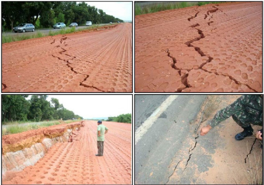
Figura 3 – Elevação inconsequente de aterros sobre solos moles, anexo a uma rodovia federal, para sua duplicação. O resultado foram ruturas que tornaram o solo (mole) de fundação ainda menos resistente e mais complexo, além do afetamento da pista federal existente.
