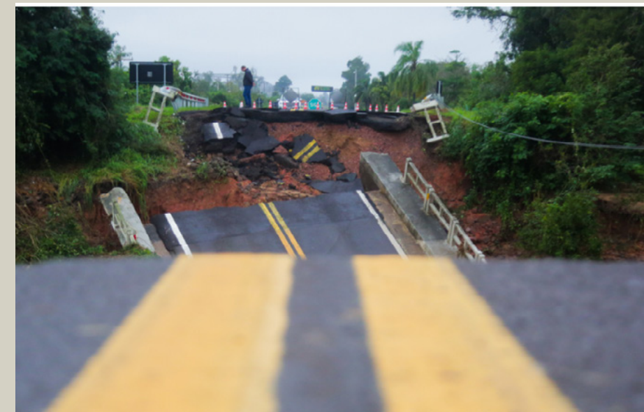
Figura 2 - Colapso total da plataforma da rodovia, em um trecho de transição sobre obra de arte, resultado típico de erosão interna (piping) e da lavagem do material de fundação. A saturação intensa do aterro, combinada com drenagem insuficiente, provoca a retirada progressiva do solo sob o pavimento, reduzindo a resistência ao cisalhamento até a ruptura súbita. O padrão do dano, com pavimento fraturado, guarda-corpos deslocados e exposição de solo argiloso mole, confirma a perda completa da condição suporte vertical e lateral, com instabilização hidráulica do maciço e abatimento imediato da pista. Esta ocorrência ilustra a vulnerabilidade de aterros não tratados, sobretudo quando não há melhoramento do solo, barreiras hidráulicas ou redundância de drenagem, reforçando a necessidade de soluções geotécnicas preventivas e monitoramento contínuo em regiões sujeitas a chuvas intensas.
