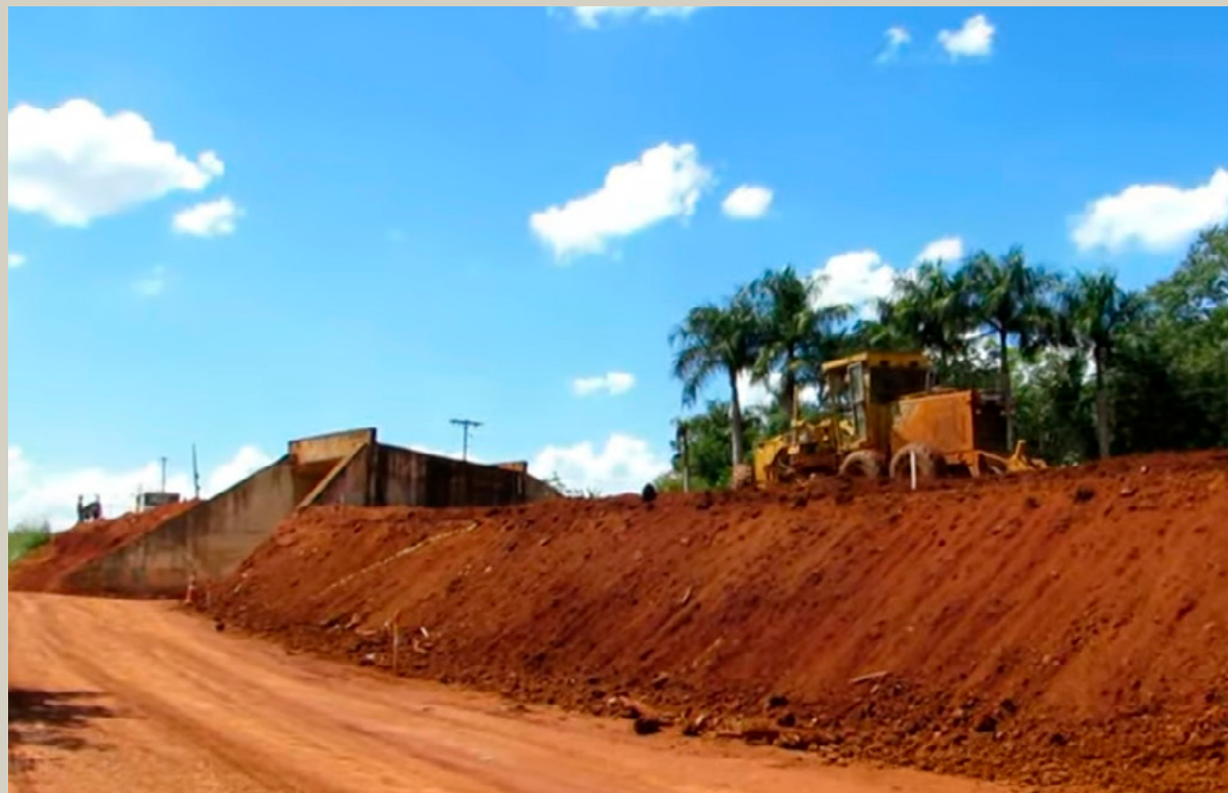
Figura 3 - Aterro e talude em formação, com solo avermelhado (provavelmente solo residual laterítico), apoiado sobre um terreno natural sem evidências visíveis de preparo prévio adequado da fundação. Observa-se a ausência de preparo do subleito, não observando-se escavação do solo superficial, regularização, nem qualquer tratamento prévio do terreno natural, indicando que o aterro pode estar sendo lançado diretamente sobre solo de baixa rigidez, muitas vezes orgânico, coluvionar ou altamente deformável. Observa-se contato direto aterro-solo natural, sendo este contato direto um dos principais gatilhos para recalques totais elevados e diferenciais ao longo do eixo, com perda de desempenho do pavimento no curto e médio prazo. Observa-se um talude íngreme e solo ainda “solto”. O aspecto do talude indica solo recém-lançado, ainda sem ganho de resistência, o que aumenta o risco de instabilidade superficial, favorecendo erosão regressiva e surgimento de trincas de tração no coroamento. Ausência de sistemas de drenagem visíveis, não observando-se longitudinais, drenos de pé de talude ou colchão drenante, o que é crítico em solos finos e tropicais, altamente sensíveis à variação de umidade. A implicação é que sem a readequação do solo de fundação, este tipo de solução tende a apresentar recalques excessivos e não uniformes, necessidade precoce de manutenção, risco de instabilidade global do aterro, especialmente em períodos chuvosos, e perda de capacidade estrutural do pavimento. Dependendo da investigação geotécnica seria recomendável promover o melhoramento do solo de fundação com geonrijecimento.
