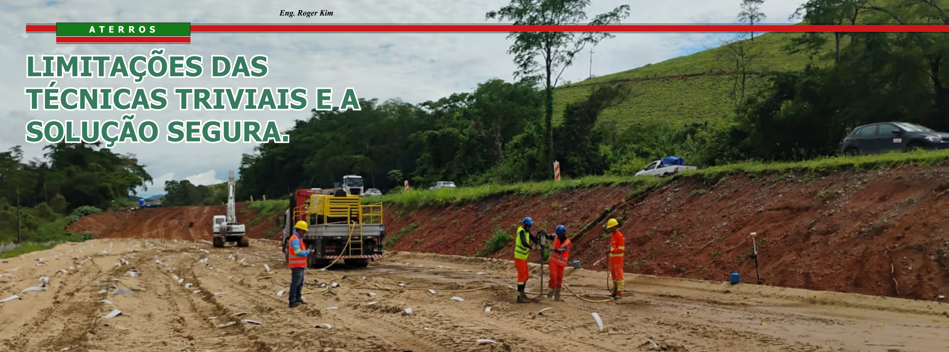
Figura 1 - Fundo de trecho, com drenagem natural, e deposição de profundas camadas de solo mole ao longo da BR-265, perto de Passos em Minas Gerais. Necessidade de melhoramento do solo para receber altos aterros.
