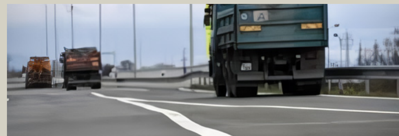
Figura 6 - Pavimento rodoviário com deformação longitudinal, evidenciada pelo deslocamento e ondulação da faixa de sinalização no sentido do tráfego pesado (caminhões). Do ponto de vista geotécnico e estrutural, o quadro é típico de recalque diferencial progressivo, concentrado na trilha de roda. Baixa capacidade de suporte do subleito, frequentemente associada a solos moles ou solos mal compactados. Deformação permanente (rutting) do conjunto pavimento-fundação, e não apenas da camada asfáltica. Efeito cumulativo de cargas repetidas, especialmente de veículos pesados, acelerando a plastificação do solo subjacente. Portanto, o problema não é superficial. A simples restauração do revestimento asfáltico tende a falhar, pois a origem está na fundação do pavimento. O caso indica a necessidade de reavaliação geotécnica do subleito, eventual melhoramento de solo e só, então, a recomposição estrutural do pavimento. Esse tipo de manifestação é clássico em rodovias implantadas sobre solos compressíveis sem tratamento adequado.
