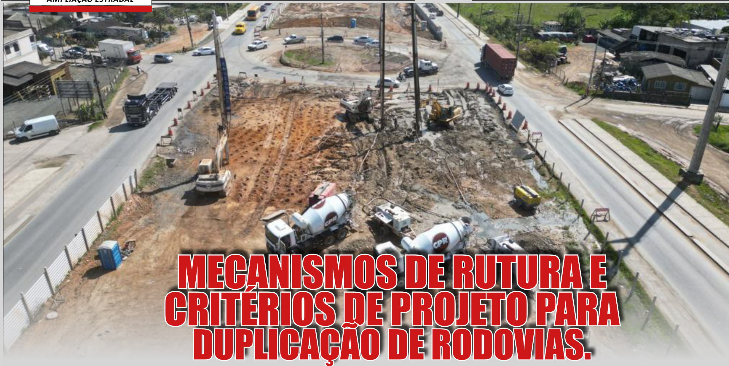
Figura 1 - Duplicação da BR-470, altura de Navegantes, SC, com serviços de melhoramento do solo em profundas camadas de argilas moles com até 35m.
