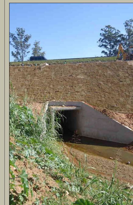
Fig 5 – Vista lateral do aterro elevado, após o melhoramento do solo, formando-se a rodovia marginal à Ahanguera, passando sobre uma galeria sobre um córrego. Notar a altura do aterro com 12m.
