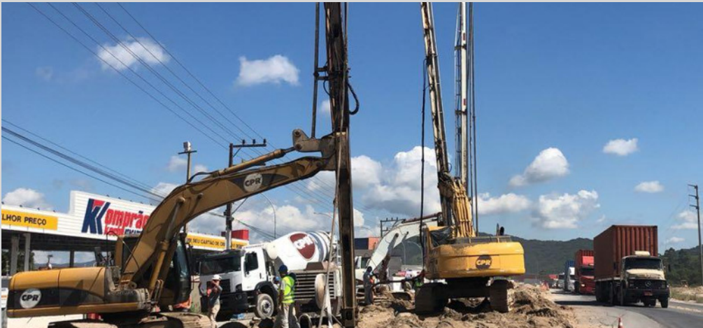
Figura 4 - Duplicação rodoviária na lateral da BR - 470, na região de Navegantes, SC, com melhoramento de solo.
