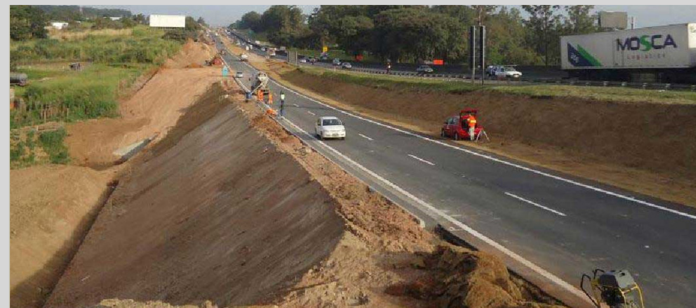
Fig 4 – Marginal executada, como ampliação da anhanguera, tendo aterro de 12m de altura sobre profundas camadas de solos moles. Ausência total de trincas e fissuras.
