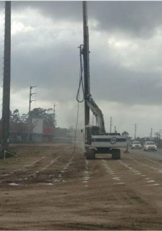
Figura 5 - Ampliação rodoviária na BR - 470, Km 36, próximo a Gaspar, SC.
