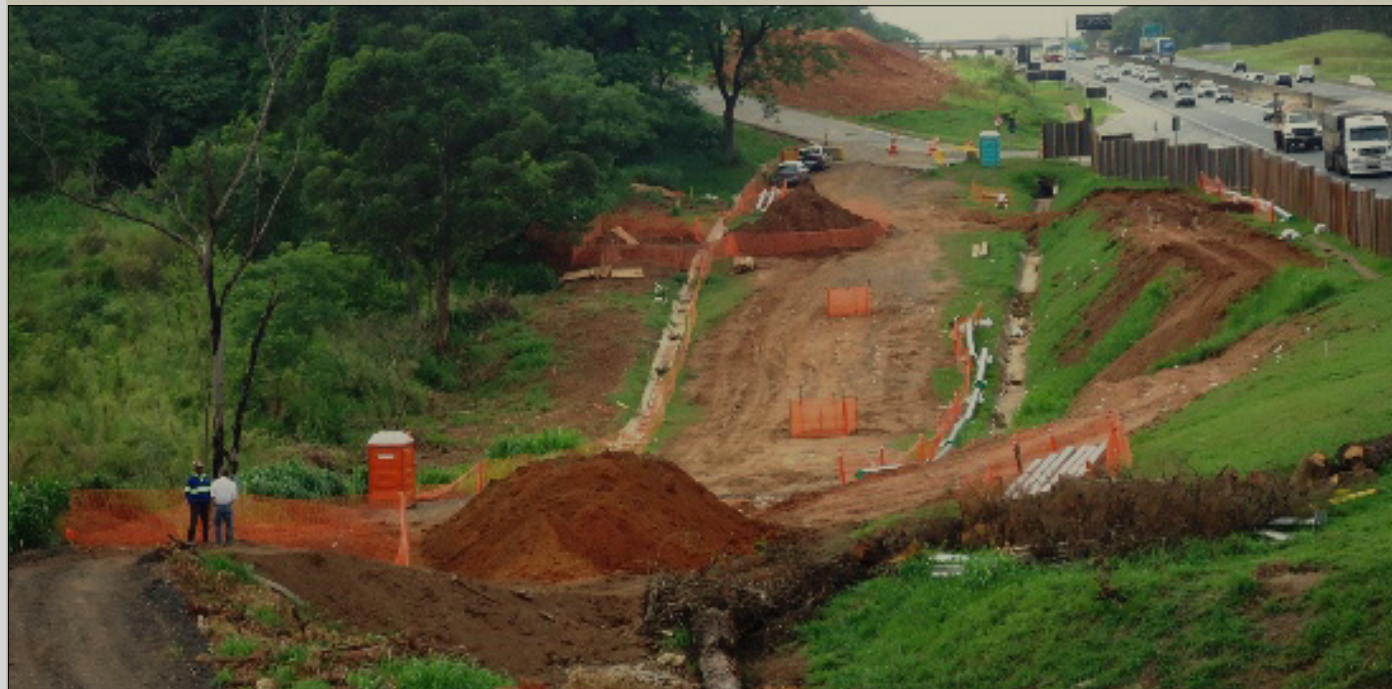
Fig 21 – Melhoramento do solo de fundação, necessário a construção de Marginal à Anhanguera, SP, objetivando receber aterros de até 12m de altura. Presença de solos moles.
