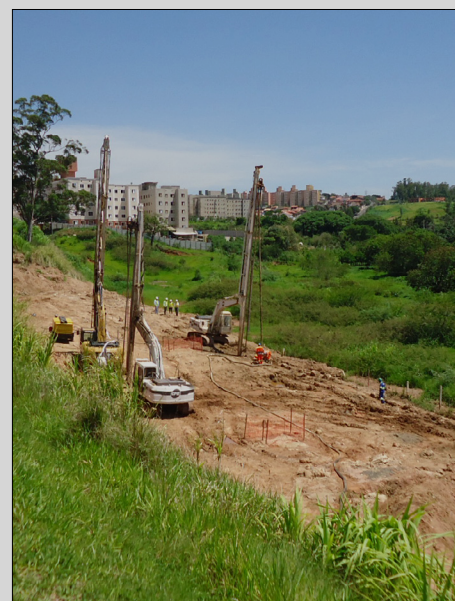
Figura 7 - Melhoramento do solo para construção de marginal à Anhanguera (SP-330), com elevação de 12m de aterro anexo a rodovia.
