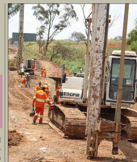
Fig 18 – Execução do melhoramento do solo em uma marginal da Ananguera, em São Paulo, perto de Campinas. Profundas camadas de solo mole tiveram seus parâmetros geotécnicos alterados para receber aterros elevados, de modo a atingir o greide da rodovia principal.
