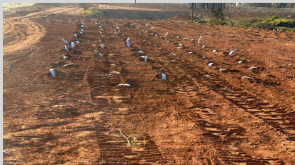
Figura 2 - Cravação de geodrenos necessário ao melhoramento do solo com geoenrijecimento.
