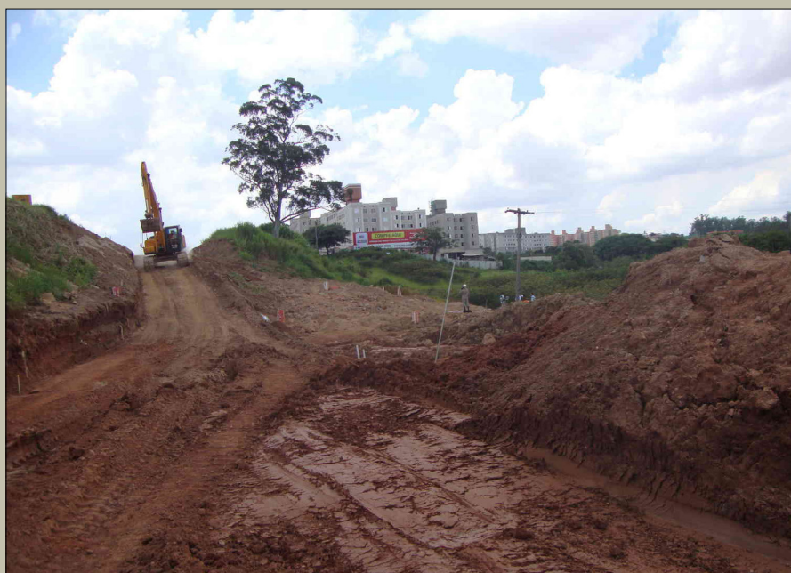
Fig 2 – Abertura do trajeto de uma das futuras marginais, para o início do melhoramento do solo mole, de modo a receber elevados aterros, com até 12m de altura. A compatibilidade do solo de fundação com a antiga pista foi fundamental para o sucesso da obra.
