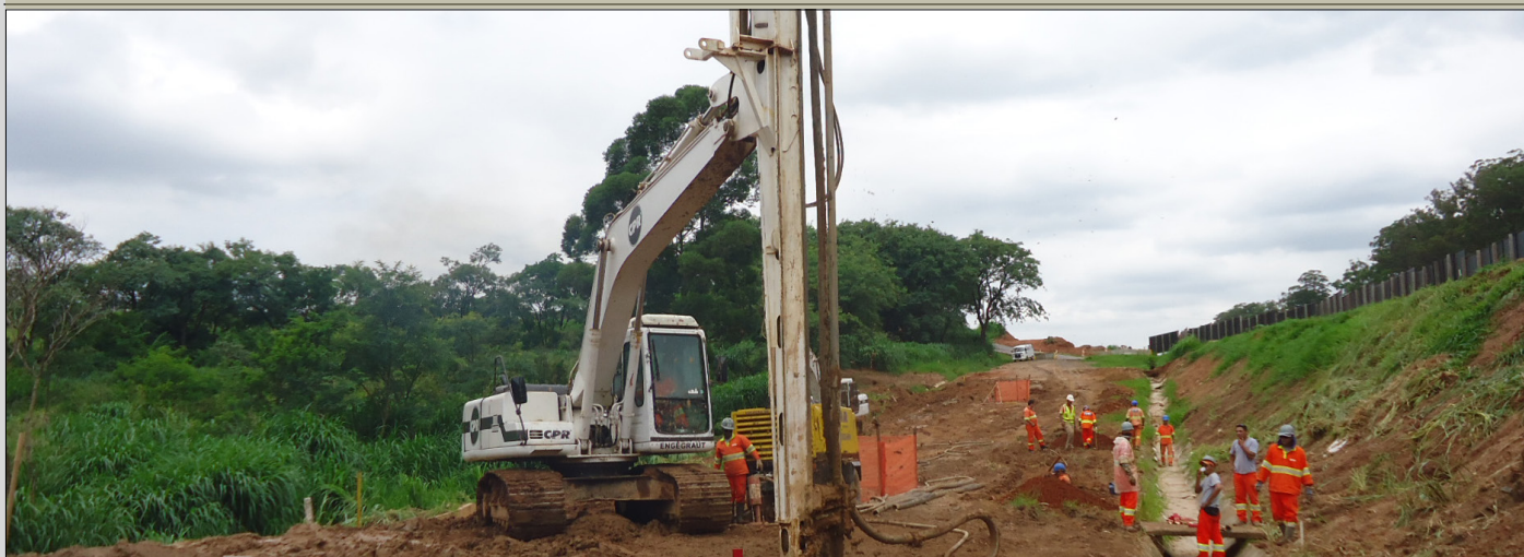
Fig 10 – Melhoria do solo, em outra marginal da saída da Anhanguera, próximo a Jundiá, necessário a receber cerca de 6m de aterro.
