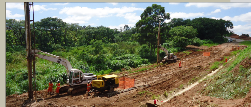
Fig 14 – Execução de outra marginal à Anhanguera, altura de Campinas, SP, sobre profundas camadas de solos moles. Melhoria do solo, com geonrijecimento para evitar problemas.
