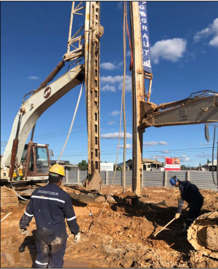
Figura 4 - Melhoramento do solo na duplicação da BR-470, próximo a Gaspar, SC.
