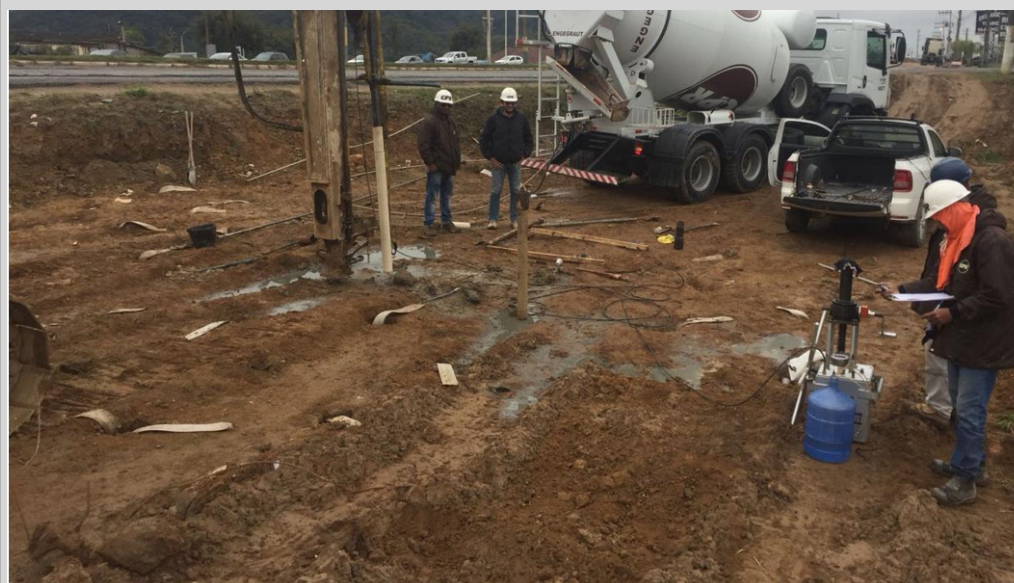
Figura 15 - Análise pressiométrica para aferir o ganho de resistência e rigidez, durante o melhoramento do solo na duplicação da BR - 470, trecho de Itajaí, SC.
