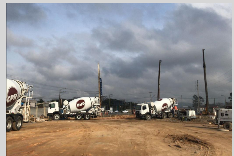
Figura 2 - Melhoramento do solo na duplicação da BR-470, na altura de Navegantes, SC.
