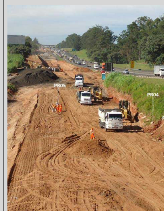
Figura 15 - Construção de marginal à anganguera (SP-330), altura de Jundiá. Necessário o melhoramento do solo devido a prsença de camadas de solo mole.
