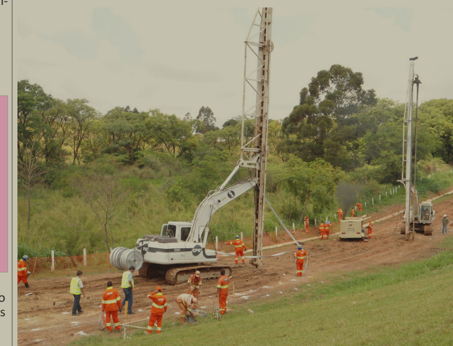
Fig 20 – Cravação prévia de geodrenos, necessário ao melhoramento do solo em uma ampliação estradal na rodovia Anhanguera, próximo a Campinas.
