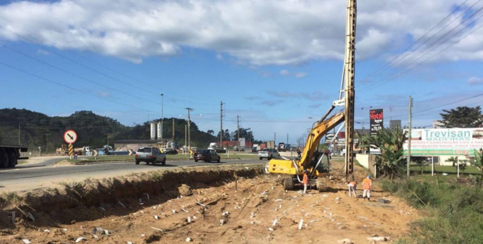
Figura 2 – Duplicação estradal bilateral, com melhoramento do solo de fundação na BR - 470, no Vale do Itajaí, SC.
