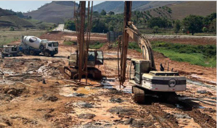
Figura 15 - A opção do melhoramento do solo mole, para duplicação de rodovias é a única opção 100% adequada para eliminar deformações tanto no lado duplicado quanto na junção com o antigo pavimento.
