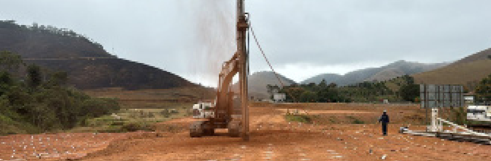
Figura 24 - Obras de aterros de encontro de pontes exigem a readequação de camadas de solos moles para os maiores níveis de rigidez.
