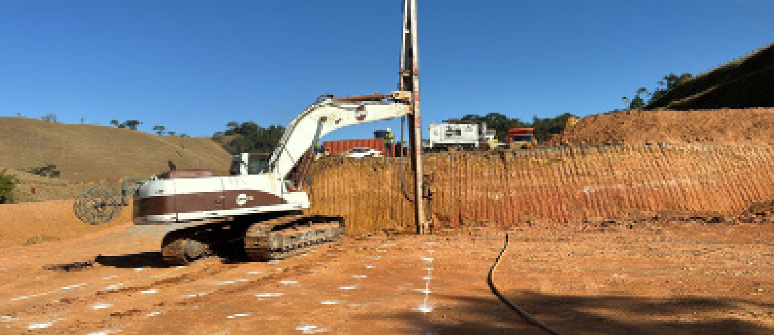
Figura 11 - Marcado no solo o posicionamento da cravação dos geodrenos e a formação dos verticais de formação dos bulbos de compressão radial do solo, durante o melhoramento do solo de fundação, para receber aterros de encontro, de uma nova ponte, na rodovia BR-265, em Muriaé, MG.
