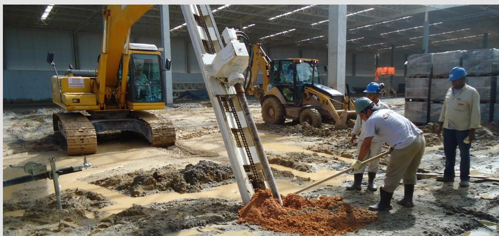
Figura 10 - Melhoramento do solo mole de fundação em todo o piso do empreendimento logístico, devido a presença de solo mole.
