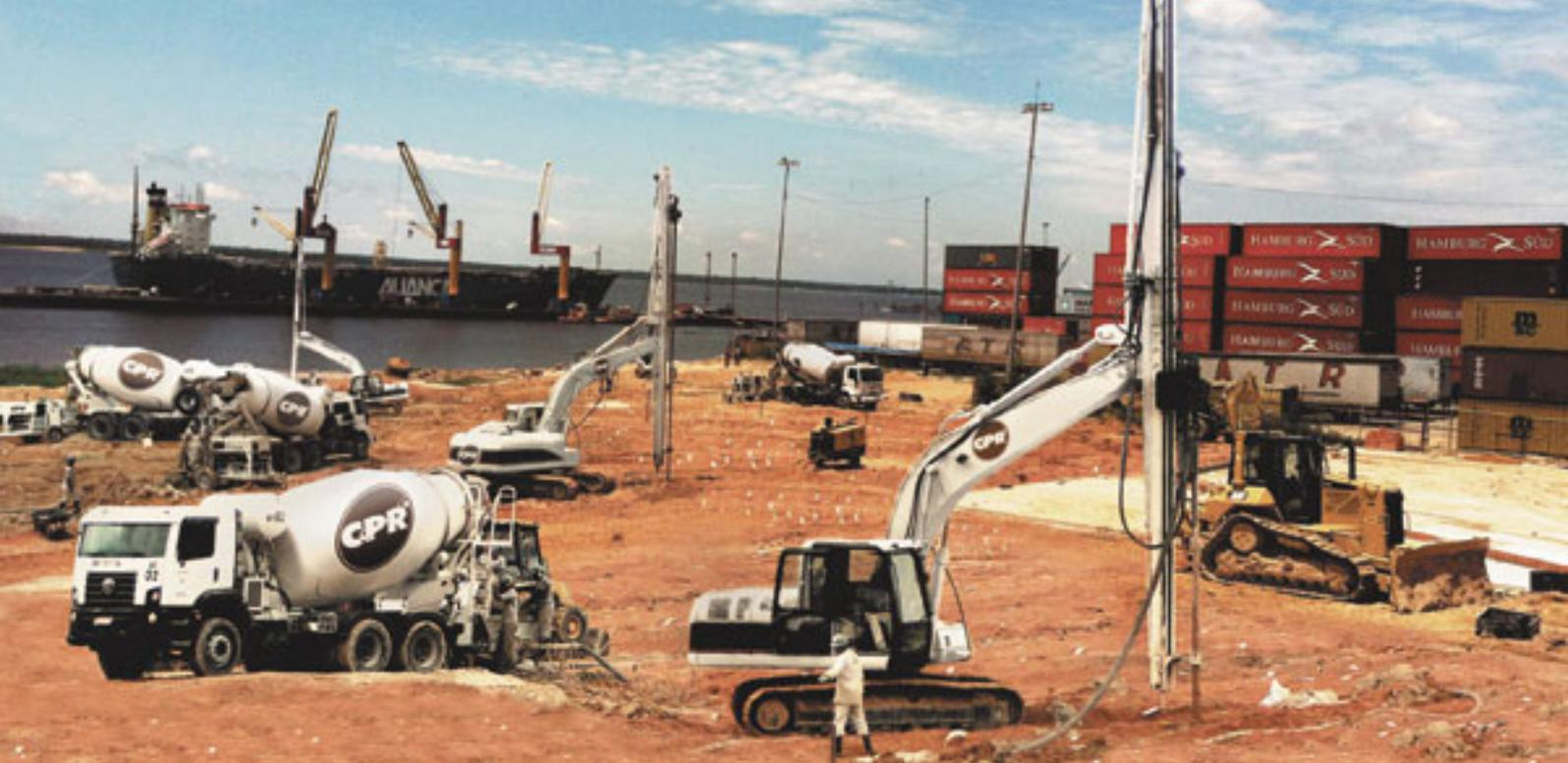
Figura 4 - Melhoramento com homogeneização de solos moles em área portuária fluvial para receber carga de contêineres.
