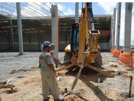
**Figura 6 -** Este empreendimento logístico começou ser executado sobre fundação direta, com presença de solos moles, sem qualquer melhoramento. Os pilares pré-moldados antes da execução da cobertura começava a apresentar desaprumo e recalques. Necessidade de melhoramento do solo sob as sapatas e todo piso.
