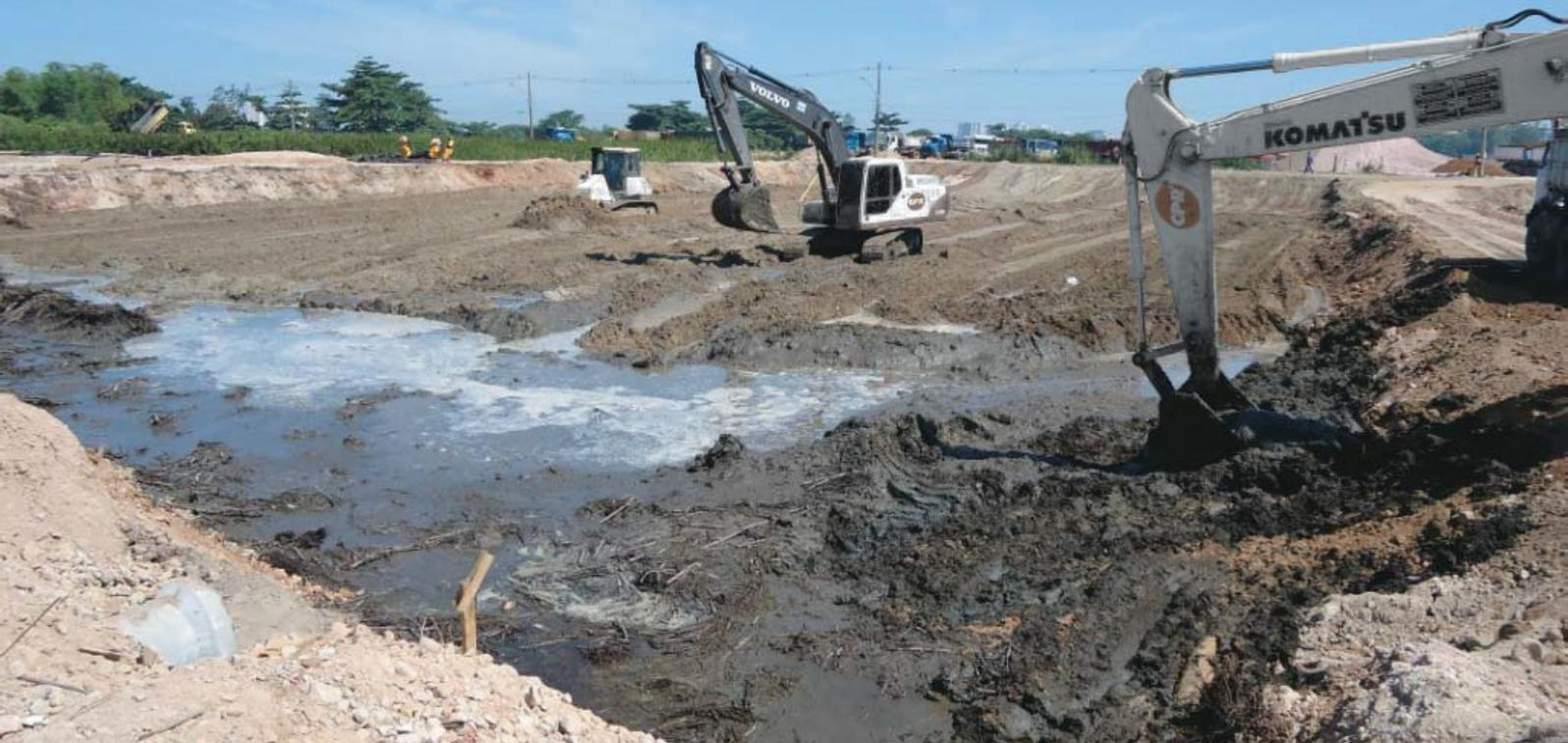
Figura 14 - Neste projeto que envolve o melhoramento do solo na borda da lagoa de Jacarepaguá, para a construção do evento “Rock in rio”, utilizou-se areia dragada da lagoa, como insumo para o melhoramento do solo mole local.
