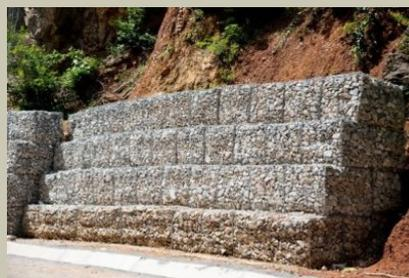
Figura 4 - Melhoramento do solo necessário à construção de contenção em gabião.
