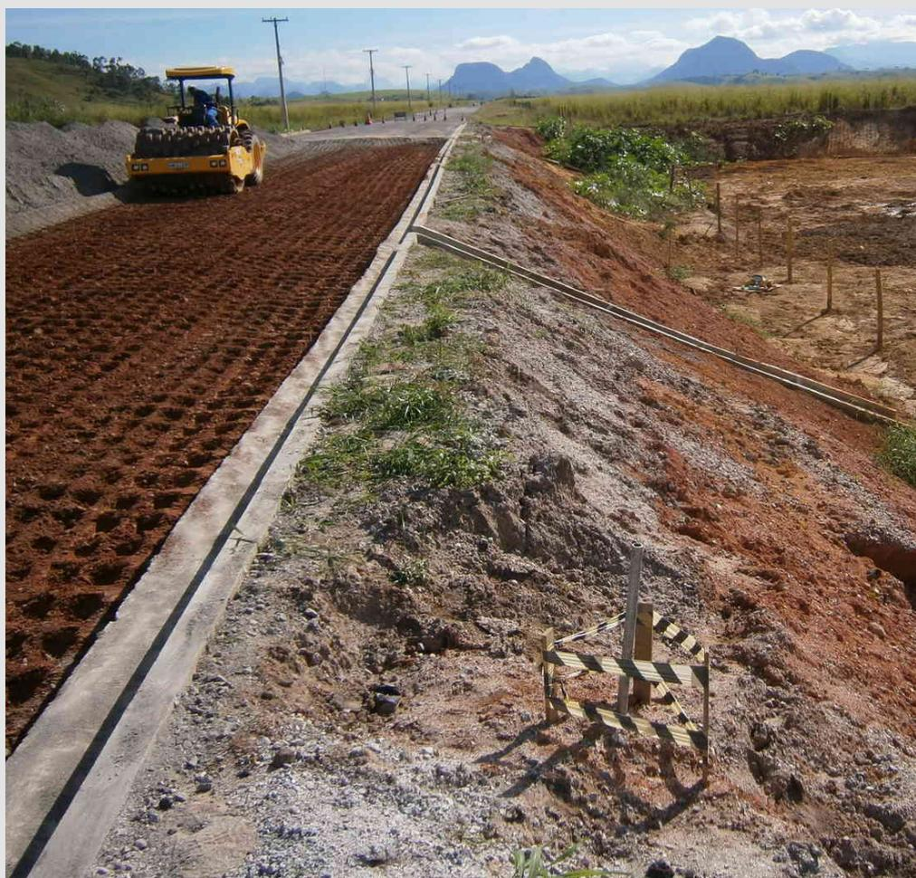
**Figura 16 - Execução da base de uma rodovia estadual no norte do Rio de Janeiro, após o melhoramento do solo e a construção do aterro para obtenção do greide de projeto.**
