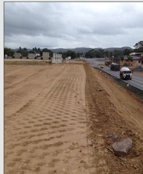
Figura 14 - A elevação do aterro, após o melhoramento do solo, para a construção de viaduto na BR-470, em Itajaí, SC.
