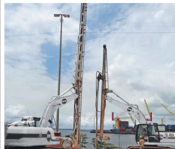
Figura 5 - Melhoramento do solo em área portuária fluvial, necessário à construção logística.
