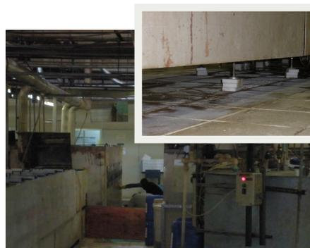
**Figura 7 -** Esta área industrial, com presença de solos moles e de fabricação de cartões de crédito, tinha pilares assentados sobre fundação profunda e piso sobre fundação direta. O piso, com o tempo, começou a ter problemas de recalque diferencial, necessitando de melhoramento do solo, de modo a igualar o nível de rigidez do estaqueamento...
