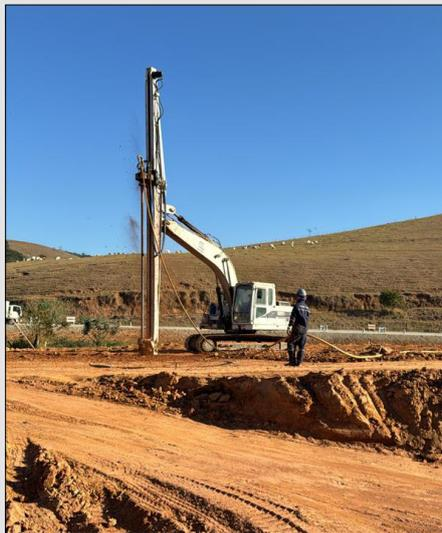
Figura 13 - Melhoramento do solo para execução de aterro de encontro necessário a uma ponte na BR-265 próximo a Ervália, MG.
