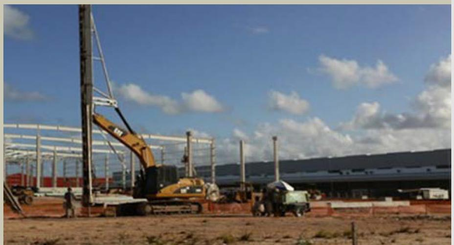
Figura 2 - Utilização de fundação direta, em um grande centro de distribuição, após o melhoramento do solo, na região de Suape, PE.
