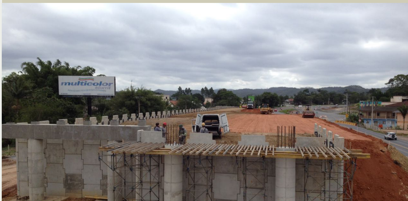
Figura 6 - Elevação de outro aterro de encontro, na BR-470, para um viaduto próximo a Itajaí, SC, após o melhoramento do solo de fundação.
