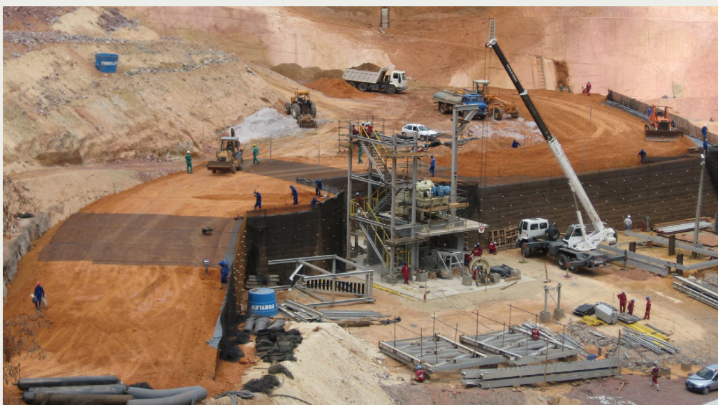
Figura 5 - Elevação de alto aterro, com contenção lateral.
