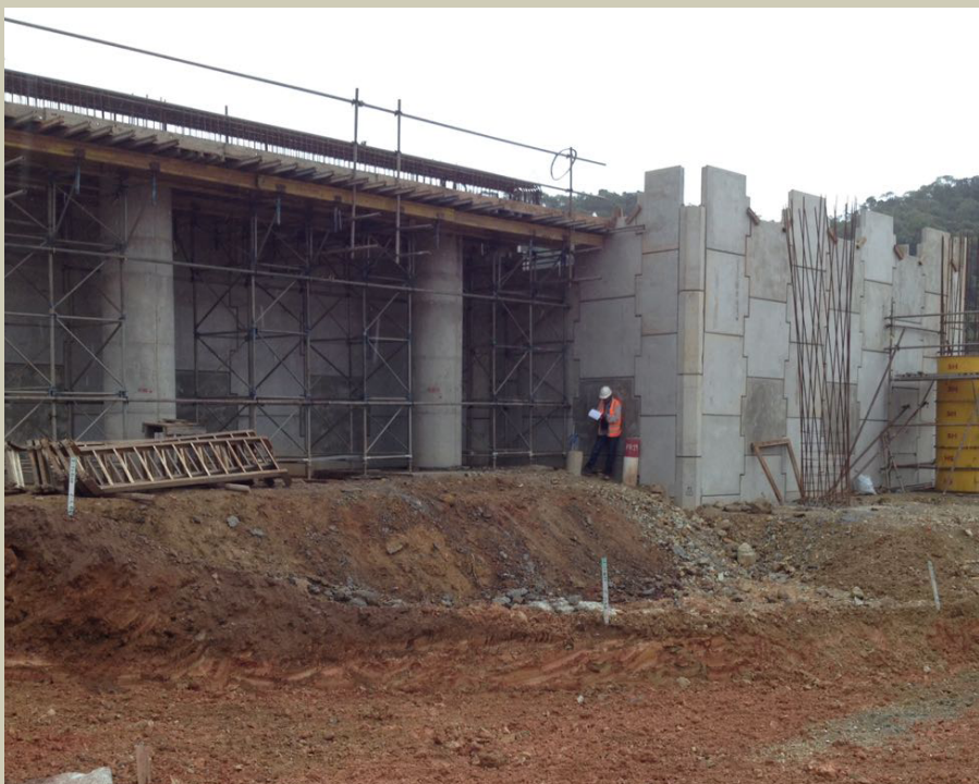
Figura 4 - Elevação de aterro estradal de encontro de um novo viaduto em Gaspar, SC. Foi realizado melhoramento do solo prévio.
