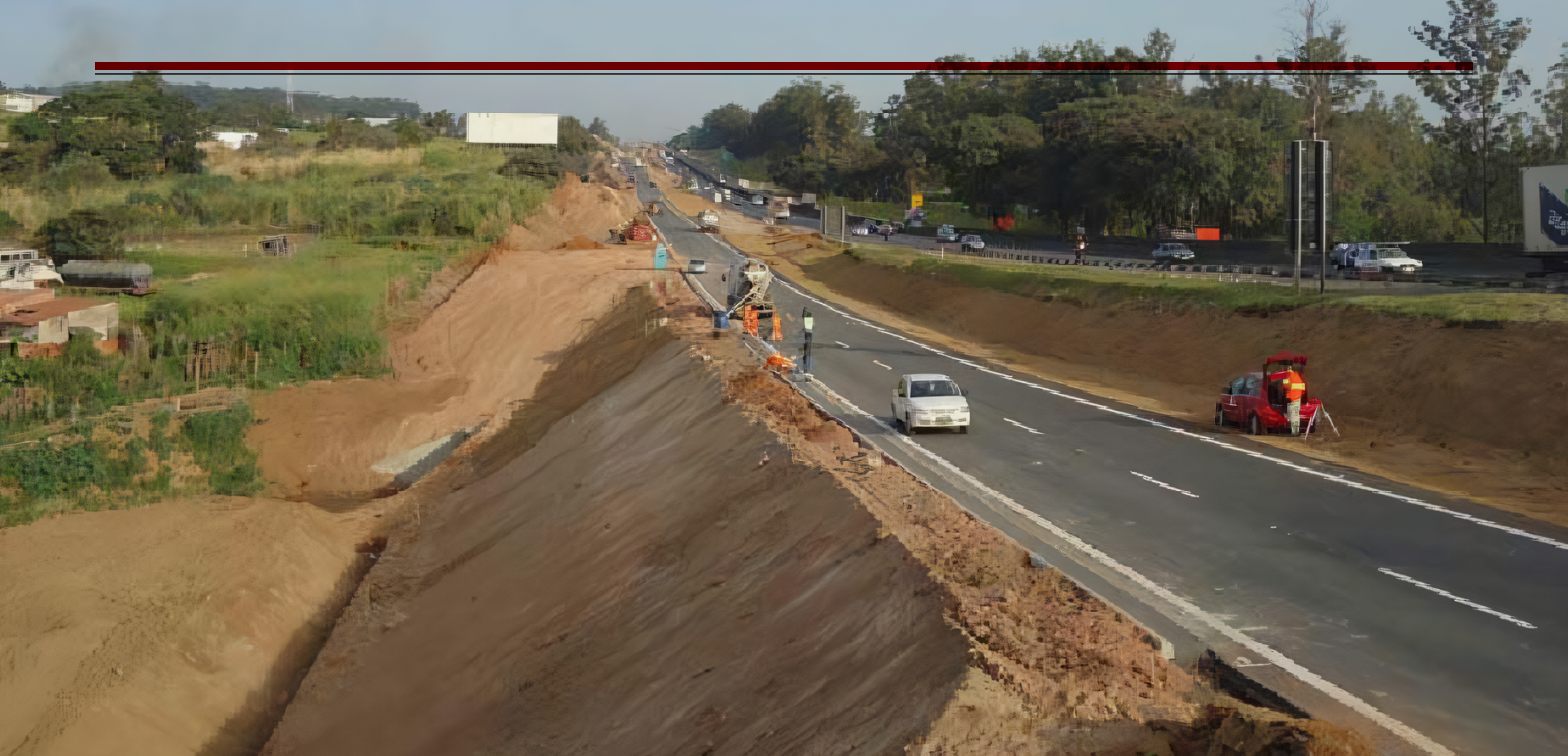
Figura 4 - O aterro com altura de 12mts, realizado para a construção de rodovia marginal à Anhanguera (SP - 330), na altura de Campinas, em São Paulo. Houve necessidade do melhoramento do solo, já que havia presença no local de solo mole e tubulação de gás da comgás de 800mm, exigindo deformabilidade zero.
