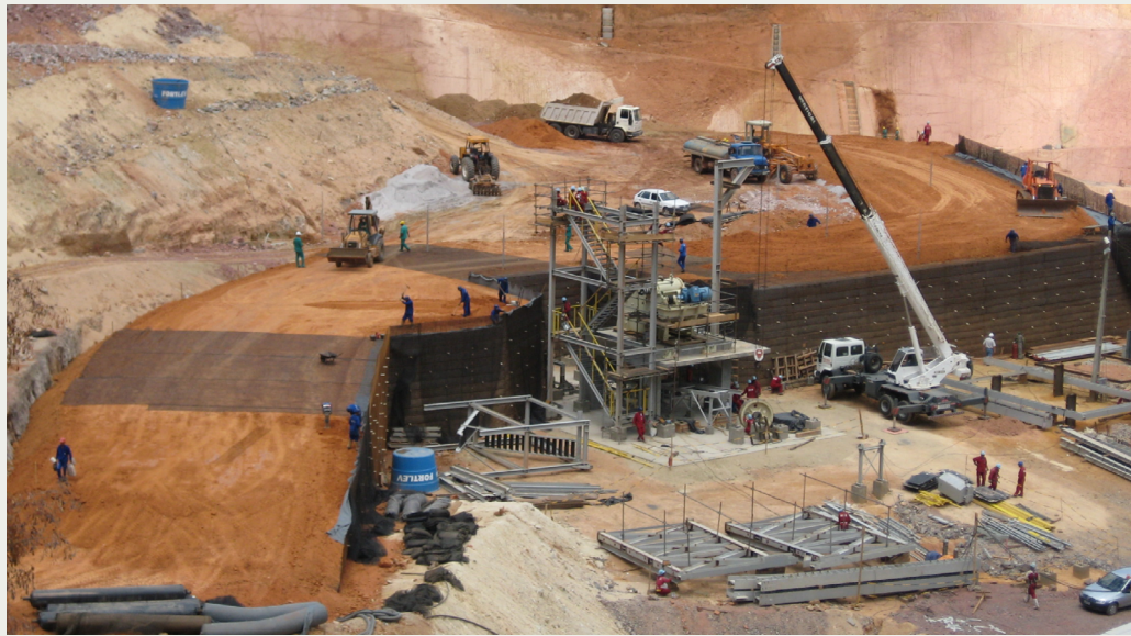
Figura 5 - Elevação de alto aterro, com contenção lateral.
