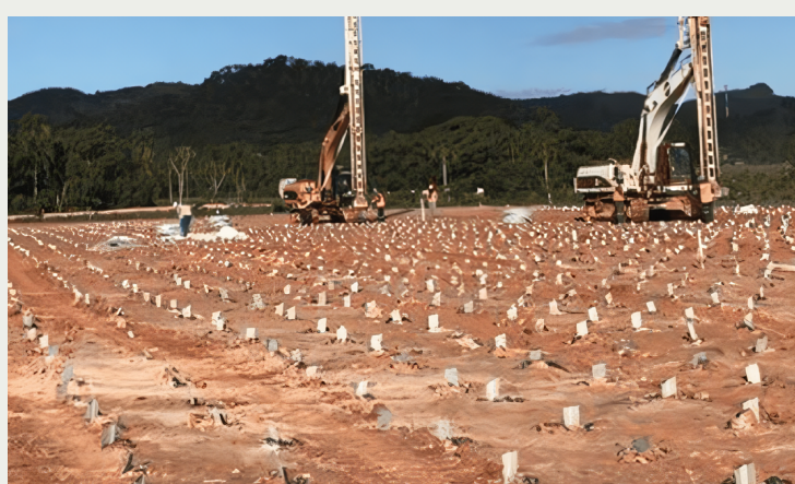
Figura 11 - Cravação de geodrenos em um grande terreno com presença de profundas camadas de solos moles no Sul do País para, a seguir, receber aterro. Trata-se de uma estratégia frágil que, invariavelmente incorre em deformações futuras.
