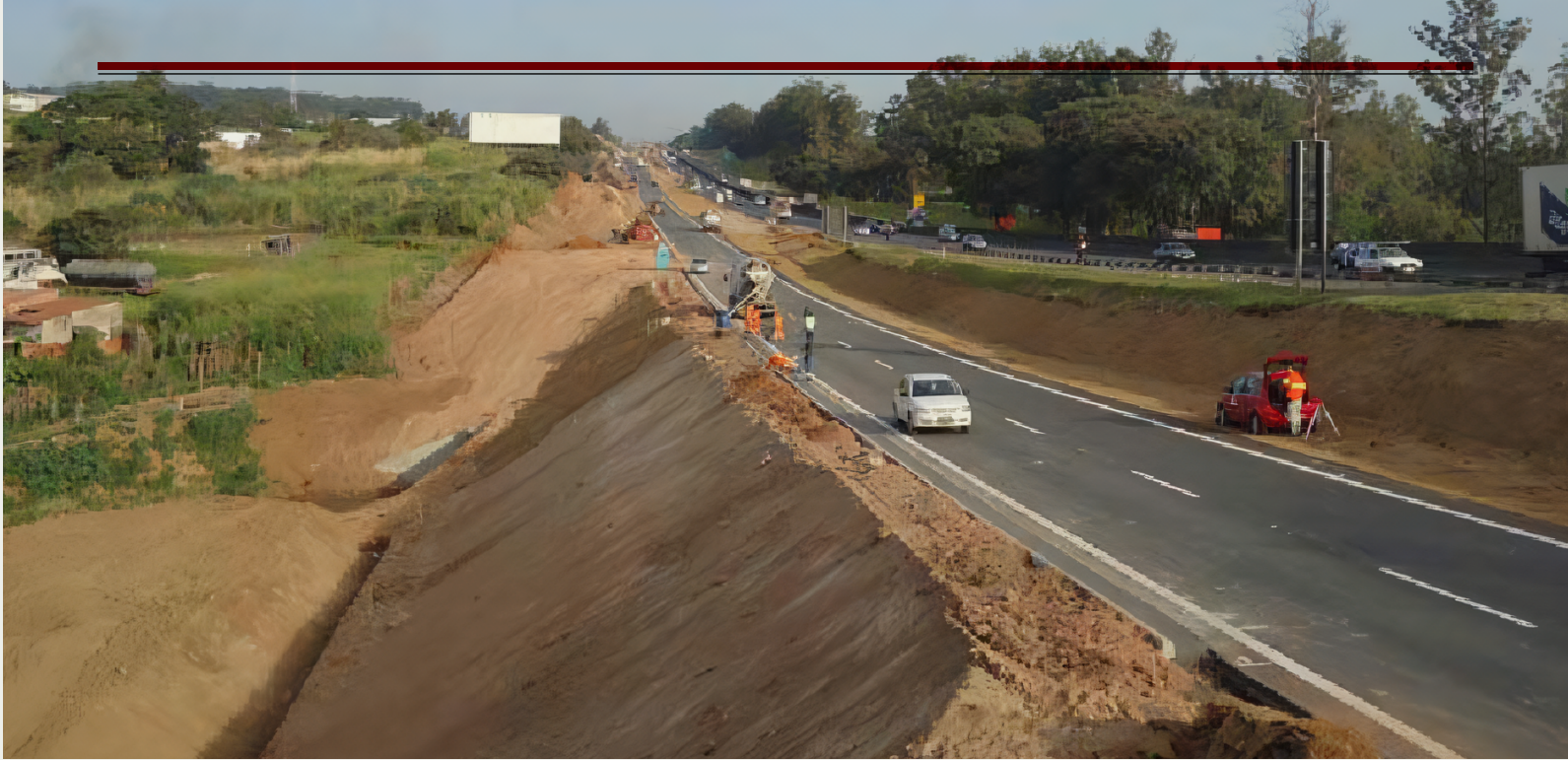
Figura 4 - O aterro com altura de 12mts, realizado para a construção de rodovia marginal à Anhanguera (SP - 330), na altura de Campinas, em São Paulo. Houve necessidade do melhoramento do solo, já que havia presença no local de solo mole e tubulação de gás da comgás de 800mm, exigindo deformabilidade zero.
