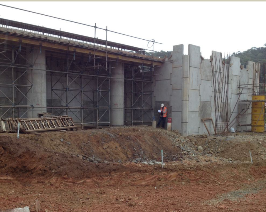
Figura 4 - Elevação de aterro estradal de encontro de um novo viaduto em Gaspar, SC. Foi realizado melhoramento do solo prévio.
