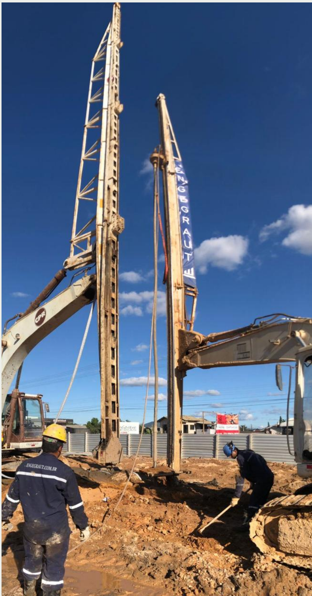
Figura 7 – Melhoramento do solo, com CPR Grouting, em ampliação rodoviária, na BR 470, no Sul do país.
