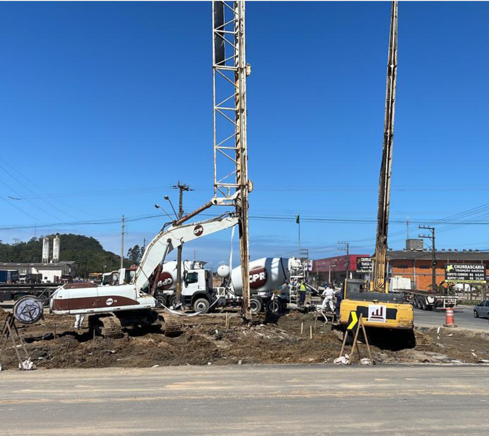
Figura 2 – Profundos depósitos de solos argilosos moles, tornaram obrigatório o melhoramento efetivo do solo, com geoenrijecimento, nesta obra de ampliação da BR - 470, trecho de Gaspar, SC.
