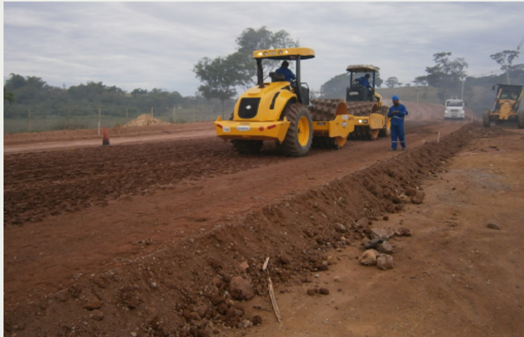
Figura 3 - Os trabalhos de lançamento e compactação do aterro, em obras de ampliação de rodovia.
