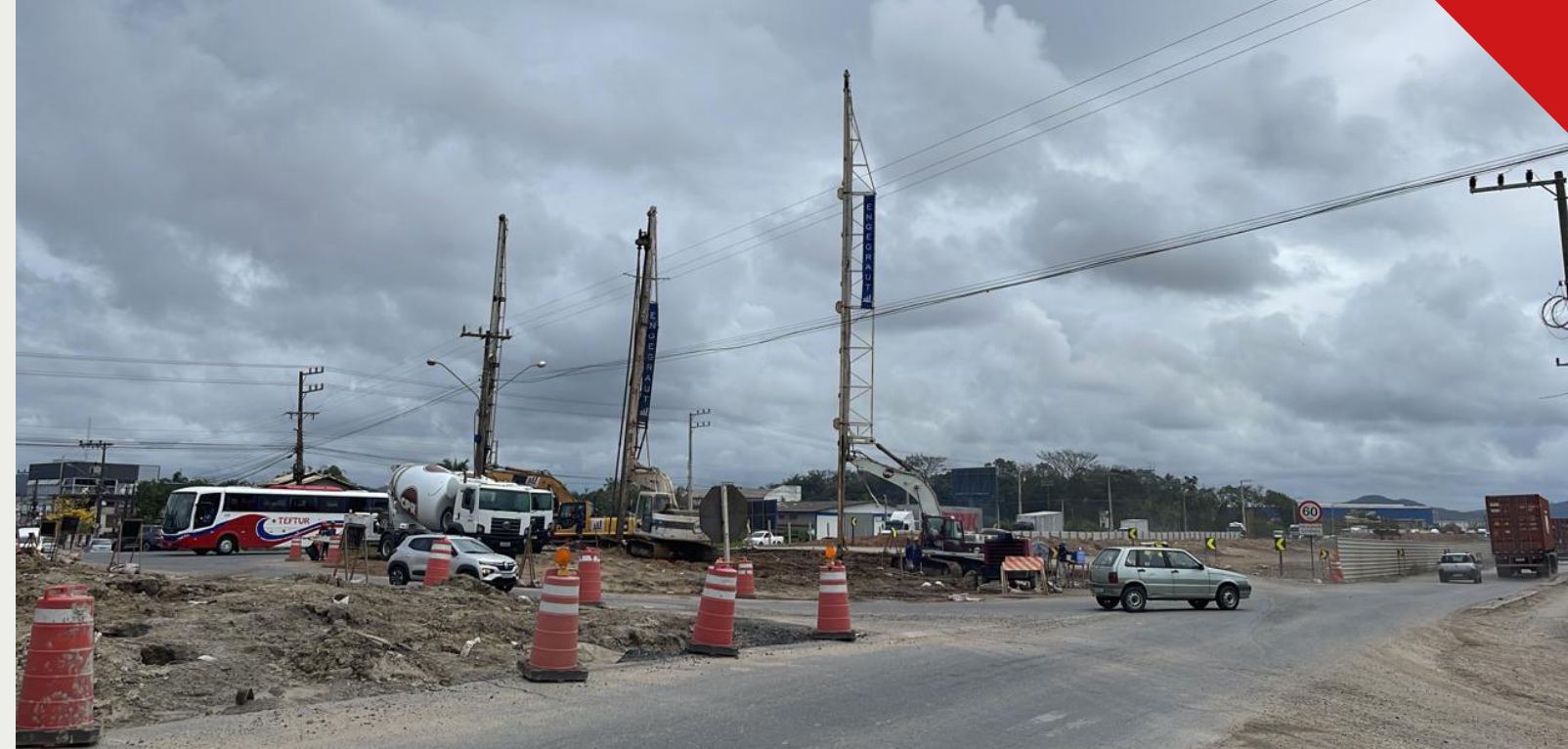
Figura 4 – Obras de melhoramento de solo de fundação na ampliação da BR 470, trecho de Navegantes, SC.
