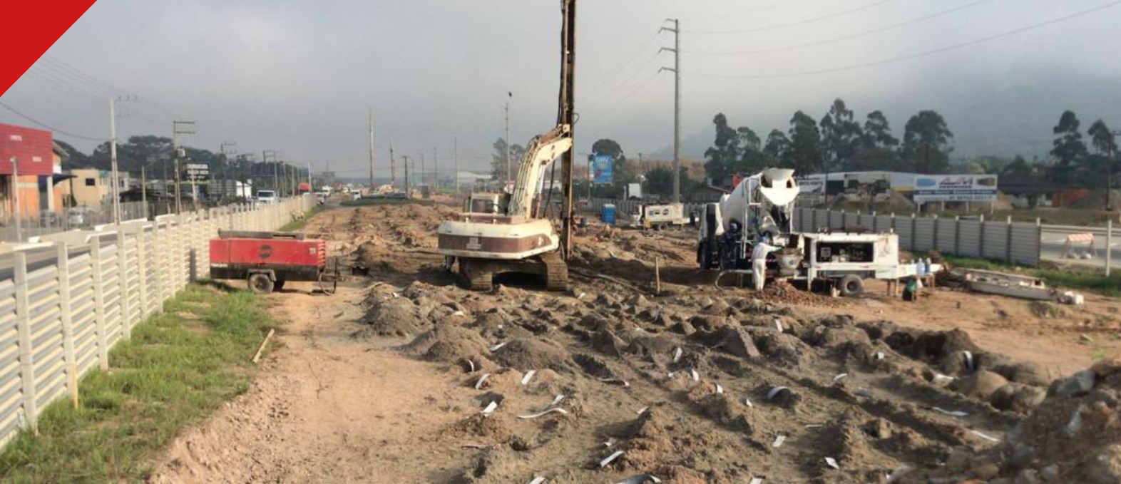
Figura 5 - Ampliação rodoviária sendo executada, iniciando-se pelo melhoramento do solo de fundação, em uma estrada federal (BR-470), no sul do país.
