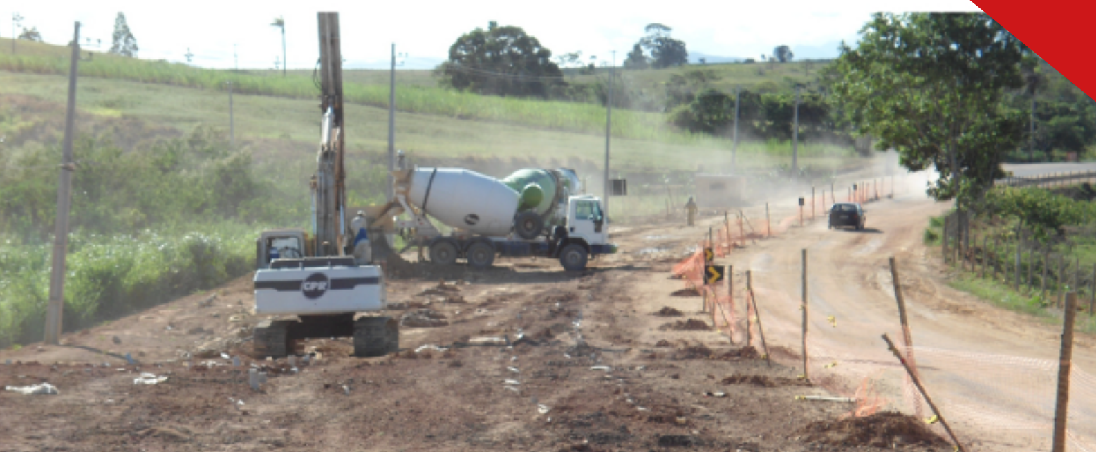
Figura 8 – Melhoramento do solo de fundação para ampliação de rodovia estadual, no interior do Rio de Janeiro.
