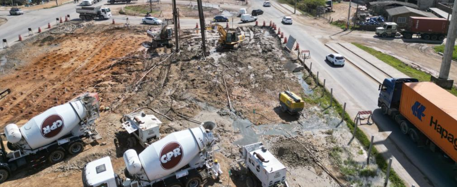
Figura 5 – A região do Vale do Itajaí é caracterizada por profundos depósitos de solos argilosos moles e, na ampliação da BR 470, foi necessário o melhoramento do solo com geoenrijecimento.
