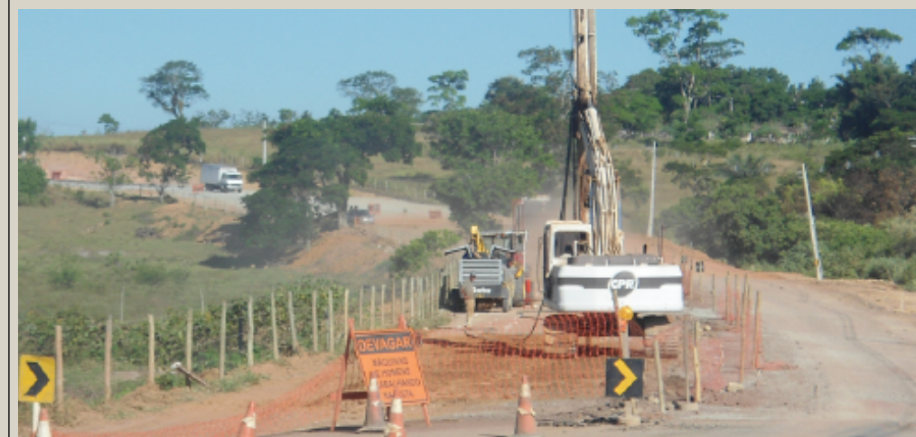
Figura 2 - Melhoramento do solo de fundação em ampliação de rodovia estadual no interior de Pernambuco, PE.
