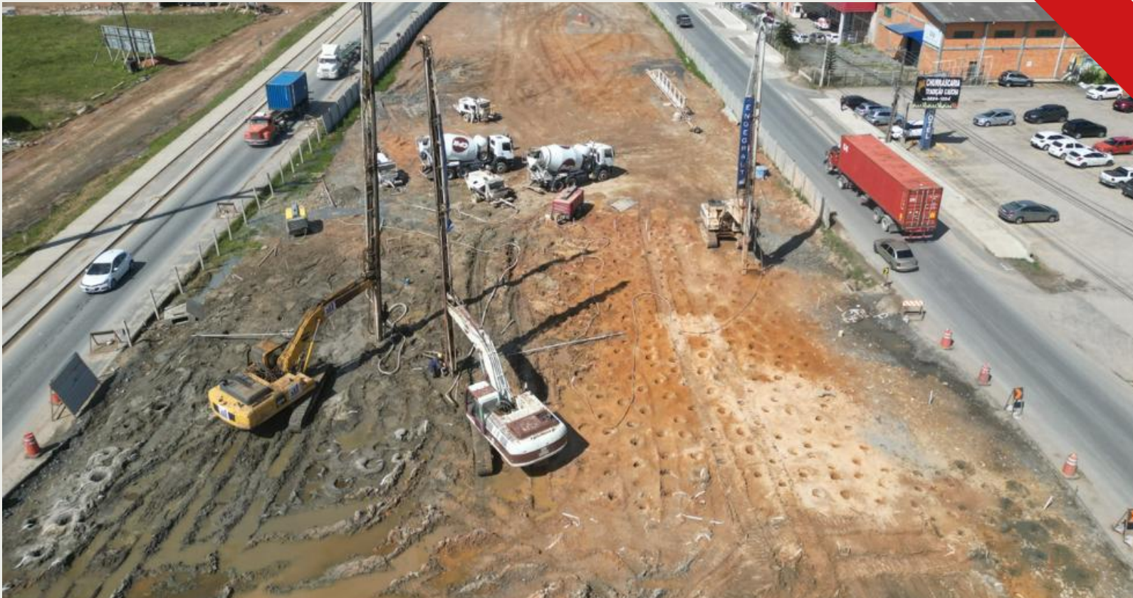
Figura 4 - Melhoramento do solo de fundação na duplicação do BR-470, trecho de Navegantes, SC. Profundos depósitos de solos moles, até 30m, e aterros com até 10m de altura para a construção de viadutos.
