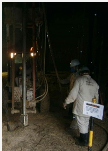
Figura 15 - Interior de um tanque industrial. Fundações em tanques industriais geram recalques diferenciais, pelo desconhecimento da interação solo-estrutura. O melhoramento do solo, homogeneizando-o para as tensões desejadas costuma ser a melhor solução.
