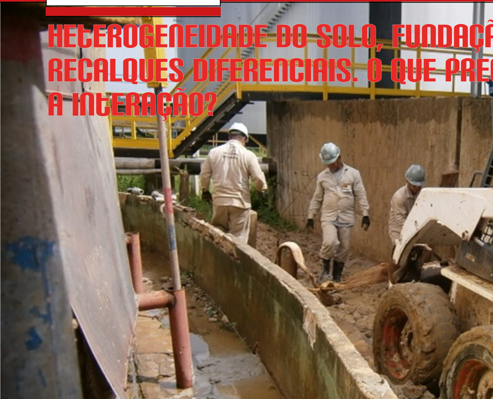
Figura 1 - Processo de correção do recalque diferencial em tanques industriais, fazendo melhoramento do solo com geoenrijecimento, readequando-o ao sistema de fundação existente.
