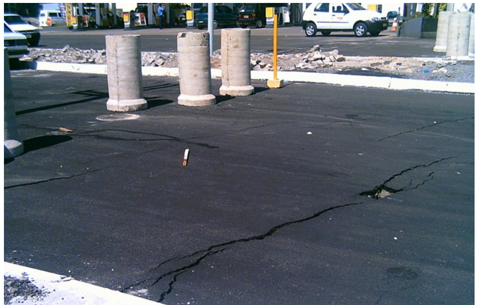
Figura 5 – A presença de argilas moles, no solo de fundação de estradas, necessita de um estudo prévio de interação solo-aterro. O melhoramento do solo, com geonrijecimento, costuma ser a melhor solução.
