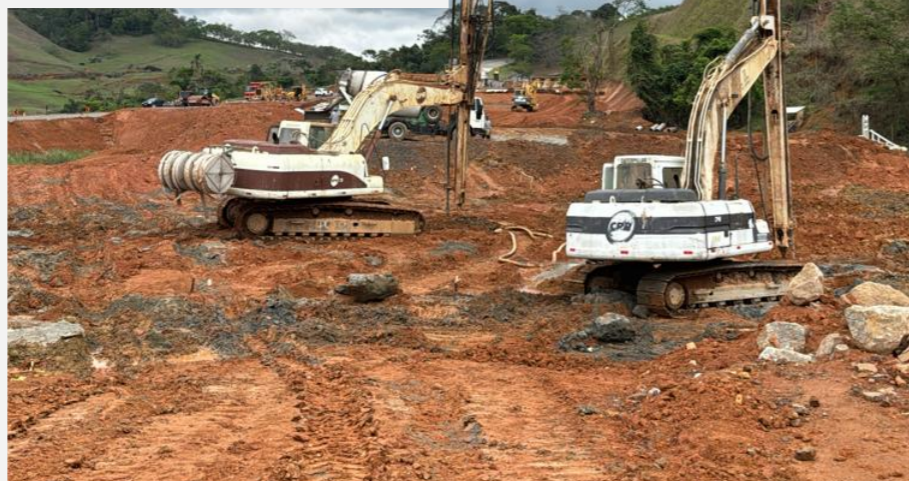
Fig 4 - Melhoramento de solo para construção de estrada em Minas Gerais.
