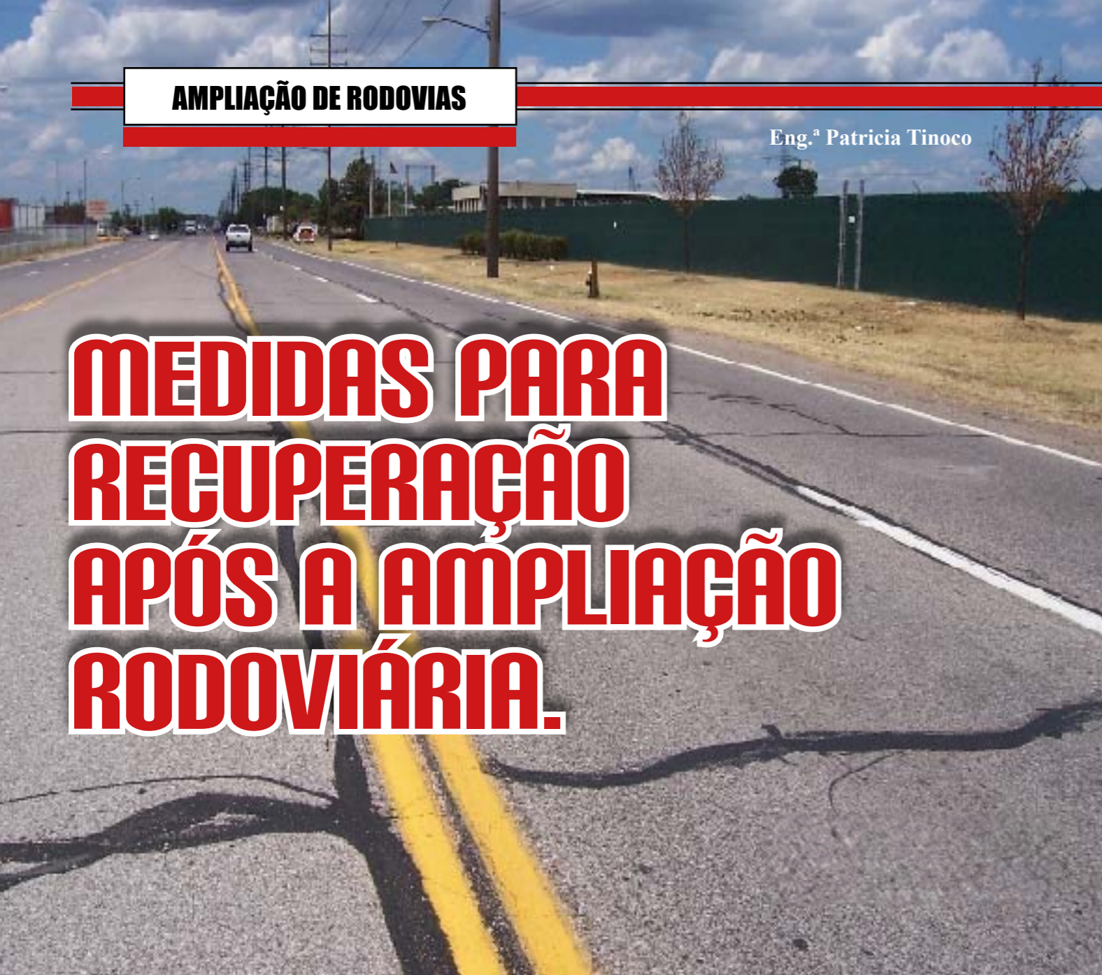
Fig 1 - Trincas longitudinais e transversais que comprometeram o pavimento rodoviário. Necessidade de recuperação após duplicação.
