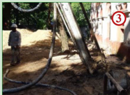
Figura 5 – Prédio histórico em Porto Alegre, RS, com mais de 100 anos, tendo quatro andares, que apresentava recalque desde o tempo da construção, devido a presença de camada de solo argiloso mole. A pouca rigidez da estrutura permitiu o desenvolvimento de grandes deformações que, de certa forma, fez sobreviver a construção. Recentemente, todo o solo de fundação foi motivo de melhoramento do solo, readequando-o a rigidez da antiga estrutura, paralisando processo de recalque. Na sequência: 1) O extenso prédio antigo com 4 andares e grossas paredes. 2) O sistema de fundação. 3) O melhoramento do solo, readequando o solo já que a fundação e o prédio foram tombados pelo Patrimônio Histórico.
