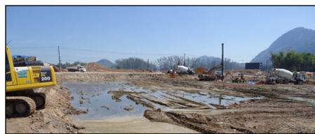
Figura 6 – Em áreas com grande deposição de solos argilosos moles, como a baixada de Jacarepaguá, no Rio de Janeiro, o aumento da rigidez destes solos só é possível com geoenrijecimento, na medida em que promove sua compressão/ drenagem, confinamento e consolidação.
