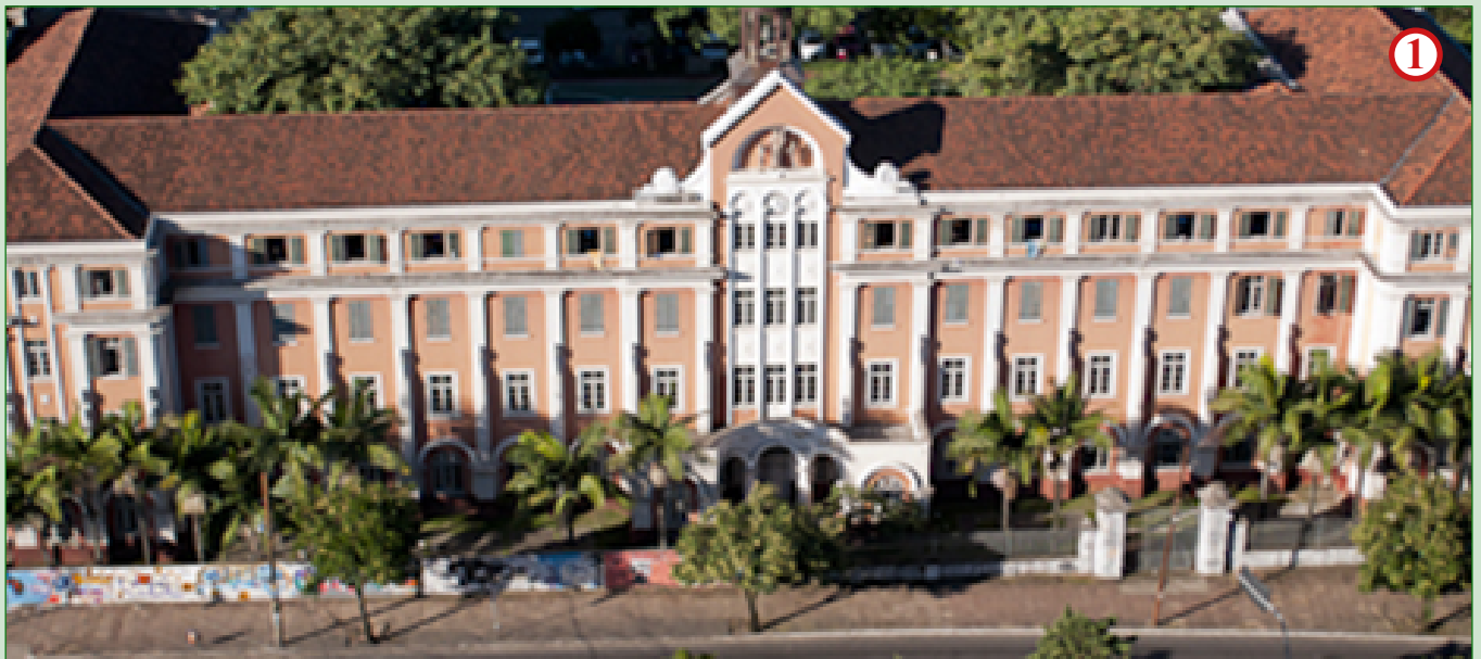
Figura 5 – Prédio histórico em Porto Alegre, RS, com mais de 100 anos, tendo quatro andares, que apresentava recalque desde o tempo da construção, devido a presença de camada de solo argiloso mole. A pouca rigidez da estrutura permitiu o desenvolvimento de grandes deformações que, de certa forma, fez sobreviver a construção. Recentemente, todo o solo de fundação foi motivo de melhoramento do solo, readequando-o a rigidez da antiga estrutura, paralisando processo de recalque. Na sequência: 1) O extenso prédio antigo com 4 andares e grossas paredes. 2) O sistema de fundação. 3) O melhoramento do solo, readequando o solo já que a fundação e o prédio foram tombados pelo Patrimônio Histórico.
