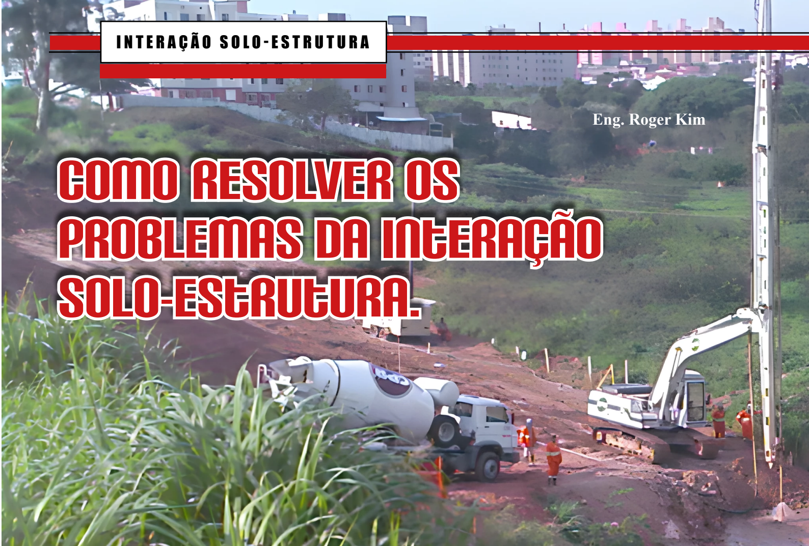
Figura 1 – Melhoria da rigidez e resistência do solo para receber a estrutura de um aterro de 12m de altura, necessário a execução de uma rodovia marginal à via Anhanguera (SP - 330). Nas fotos menores o melhoramento do solo e a elevação do aterro com a marginal executada.
