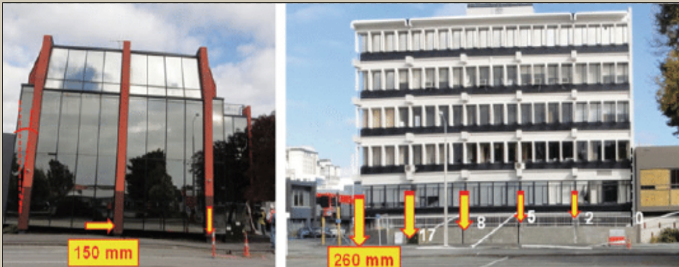
Figura 3 – Recalque diferencial em edificações.
