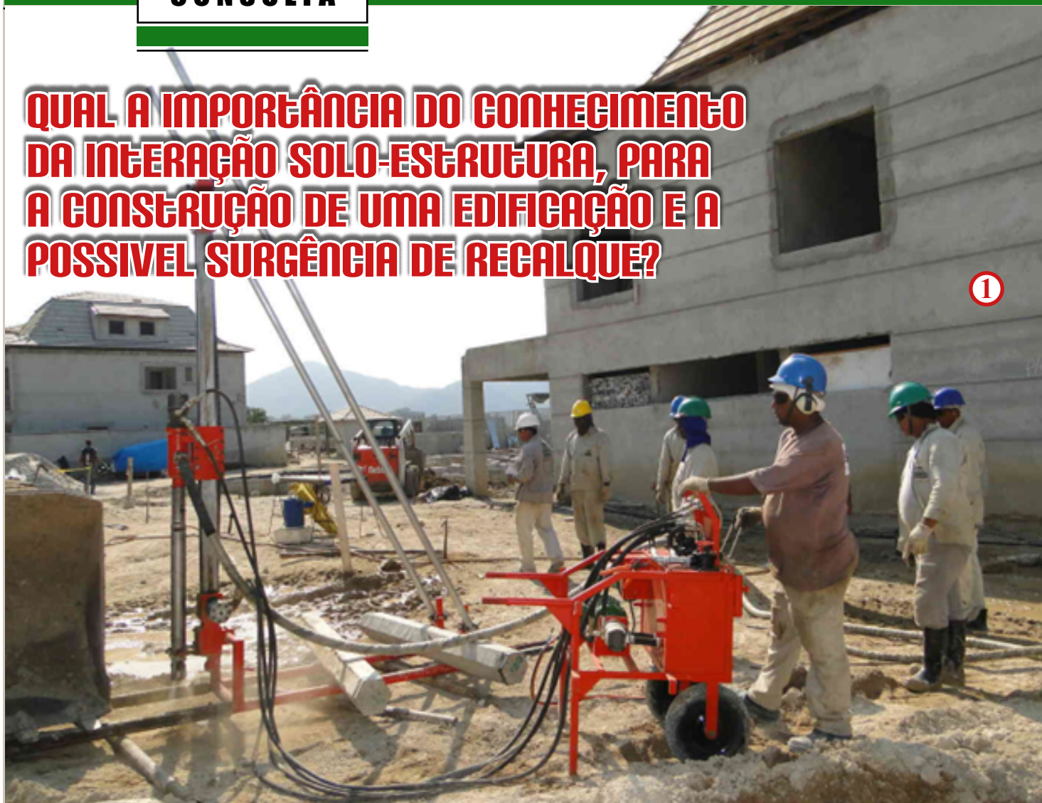
Figura 1 – Neste condomínio de casas de luxo, estaqueou-se apenas as construções e atterrando-se o resto. A presença de solo mole provocou o efeito Tschebotarioff nas estacas. Ausência da interação solo-estrutura. O melhoramento do solo corrigiu o problema. Na foto maior o melhoramento do solo sendo executado. Na fotos 2 e 3, o efeito Tschebotarioff nas estacas e a região com o solo todo melhorado.
