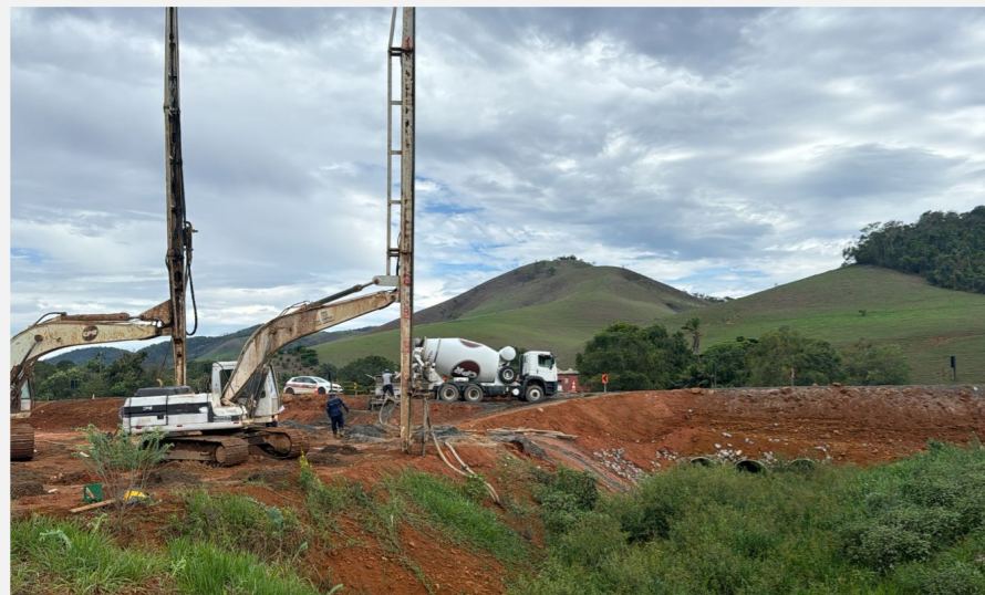
Fig 3 - Melhoramento de solo para construção de estrada em Minas Gerais.
