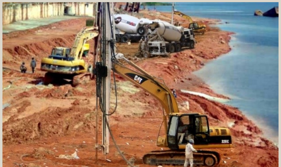
Fig 2- Após a trágica ruptura, em praticamente toda a extensão portuária de Manaus, AM, rapidamente iniciou-se o melhoramento do solo, com geoenrijecimento. Ao fundo à direita, parte do Porto, que escorregou, encontrando-se adernado.
