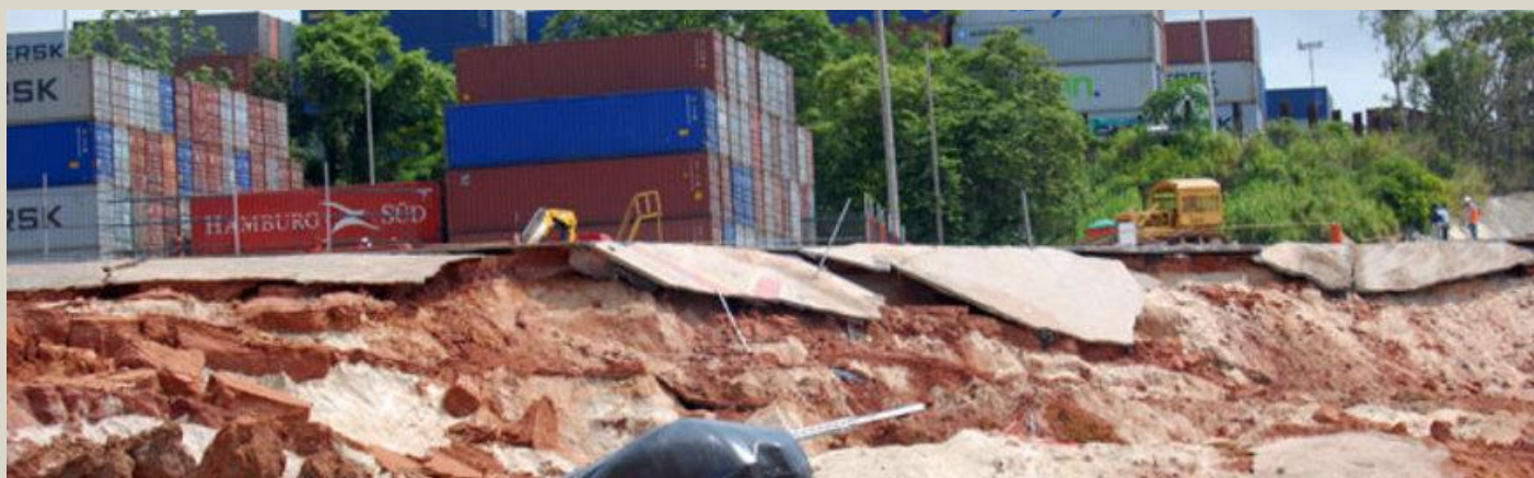
Fig 3- A massa de solo rompida apresenta diversas formas
