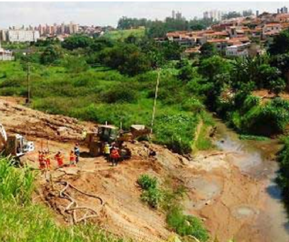
Fig 11- Estabilização de talude para ampliação da rodovia Anhanguera, na altura de Campinas, utilizando-se geoenrijecimento.
