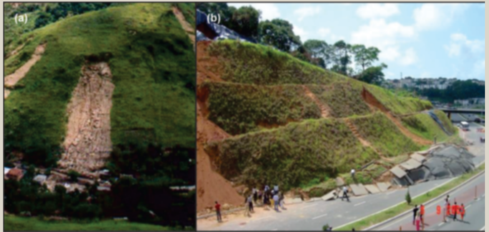
Figura 5 – Exemplos de superfícies de ruptura: (a) Escorregamento translacional em solo residual – Foto do acervo da GeoRio; (b) escorregamento rotacional (Salvador, 2005)
