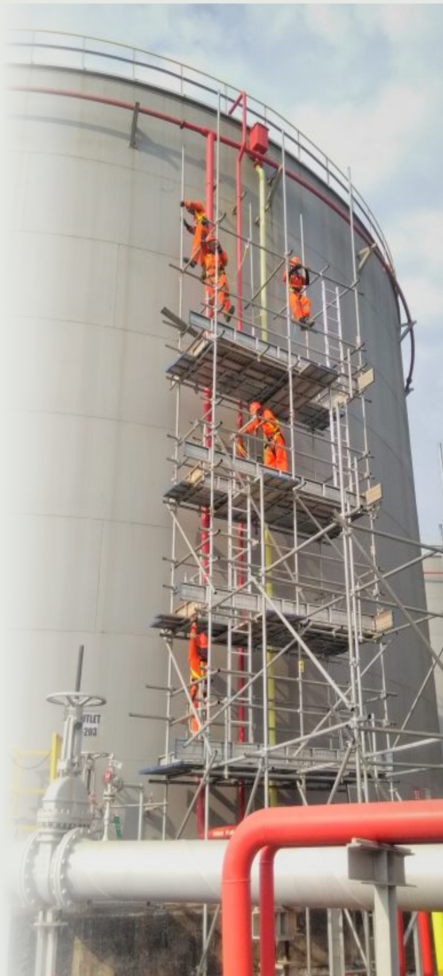
Fig. 14 - Serviços obrigatórios de inspeção no costado de tanque de armazenamento.
