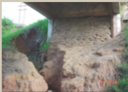
Figura 7 A) Erosão fluvial na base do encontro, com exposição das estacas. B) Erosão acentuada do talude, com proteção emergencial com solo-cimento ensacado
