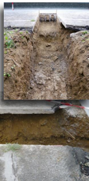
Figura 2 - "Janela" aberta no pavimento. A fissura coincide com a transição entre solo compactado e o erodido
