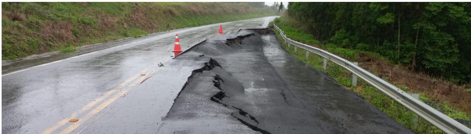
Figura 11 - Início de rutura com fissuração em arco.
