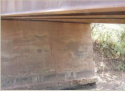
Figura 6 - Fraturamento devido a recalque
