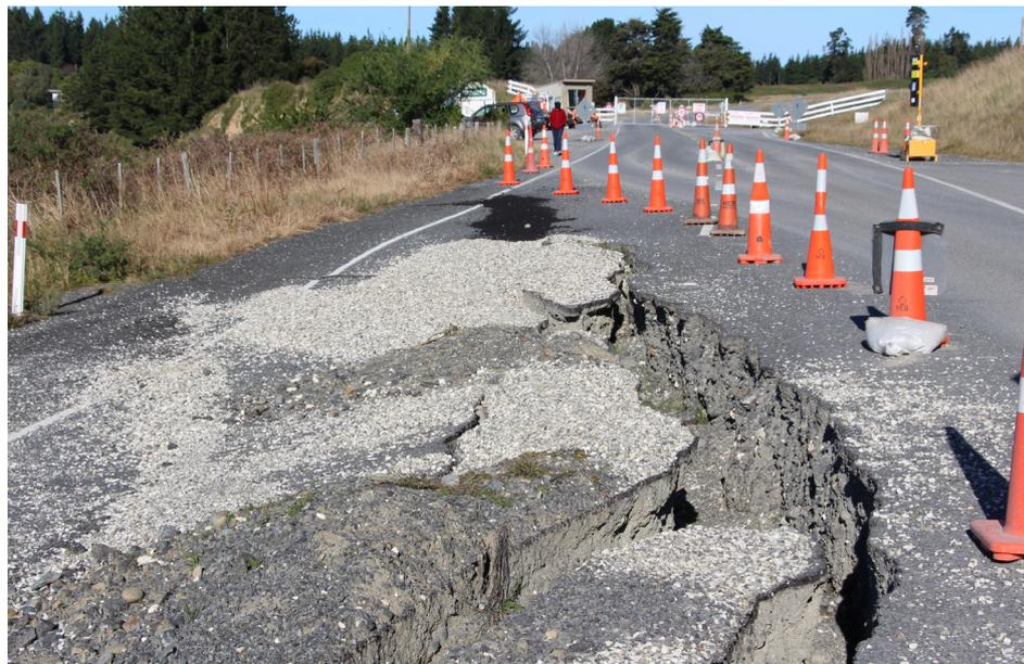
Figura 5 - Início de rutura em trecho estradal, com desenvolvimento de fissuramento em arco.
