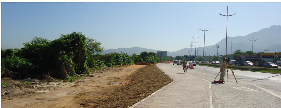
Figura 6 - Nesta rodovia, na Barra da Tijuca, Rio de Janeiro, houve necessidade de ampliar o aterro, devido a problemas de fissuração longitudinal, devido a presença de solo mole. Para tanto, foi feito melhoramento do solo com geoenrijecimento.
