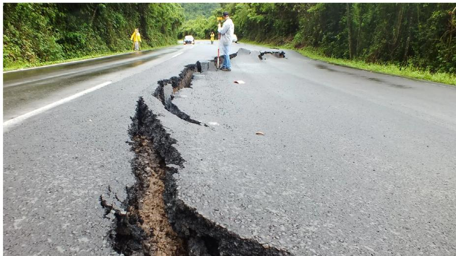
Figura 10 - Início de rutura com fissuração em arco.
