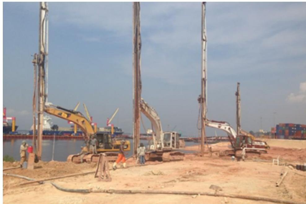
Figura 8 - Aterros em áreas portuárias fluviais. A presença de trincas, próximo as bordas dos aterros, exige serviço de melhoramento imediato, considerando que o esvaziamento dos rios provoca consequentes deslizamentos
