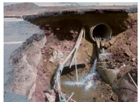
Figura 4 - Colápsio de um aterro estradal, na sequência de um processo erosivo, anexo a uma rede hidráulica após chuva intensa.
