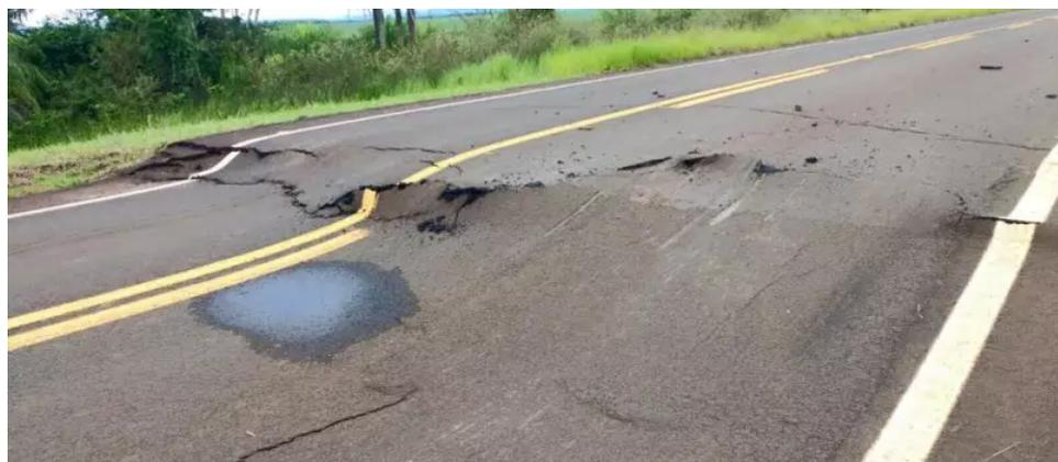
Figura 3 - Depressão na rodovia, devido a diferentes características de solos (zona de corte/ aterro), o que exige melhoramento do solo para homogeneizar ambos os lados.
