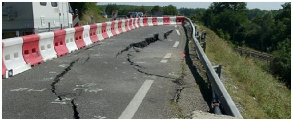
*Figura 2 - Início da rutura em um aterro estradal com fissuramento em arco.*
