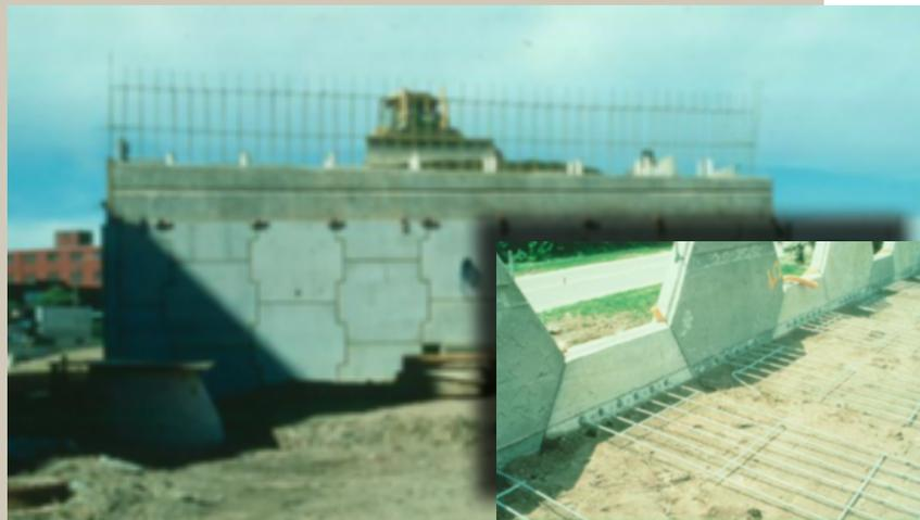
Figura 2 – Exemplos de encontros de solo mecanicamente estabilizado (MSE): (a) Encontro com painéis pré-moldados; (b) Muro de MSE sob construção
