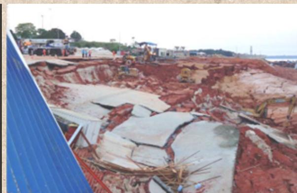
Figura 2 -Rutura de aterro, ao longo do rio negro, em Manaus, AM, construído sobre solo argiloso/ siltoso mole. A utilização de colunas, como jet grouting, não suporta o enorme empuxo horizontal, causado pela poropressão quando da vazante do rio. A solução é a consolidação efetiva do solo de fundação.
