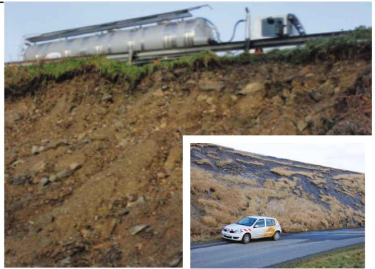
Figura 5 - Processo de erosão no talude do aterro.
