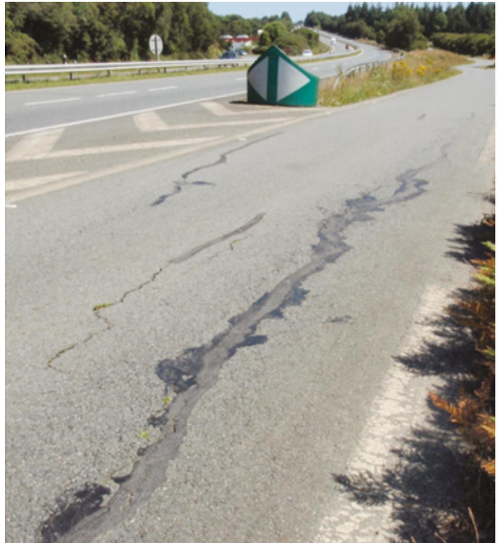
Figura 7 - Fissuras típicas de início de deslizamento: O preenchimento das fissuras reduz o agravamento do fenômeno
