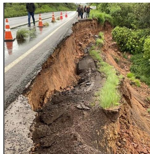
Figura 4 - Instabilidade no talude gerou rutura com parede quase vertical. A origem foram fissuras longitudinais ao longo do acostamento.
