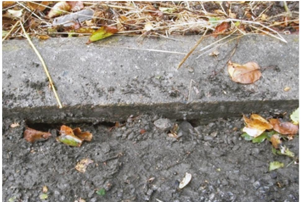
Figura 6 - Defeito de estanqueidade entre a borda do concreto e a camada do pavimento, o que gera inevitáveis problemas
