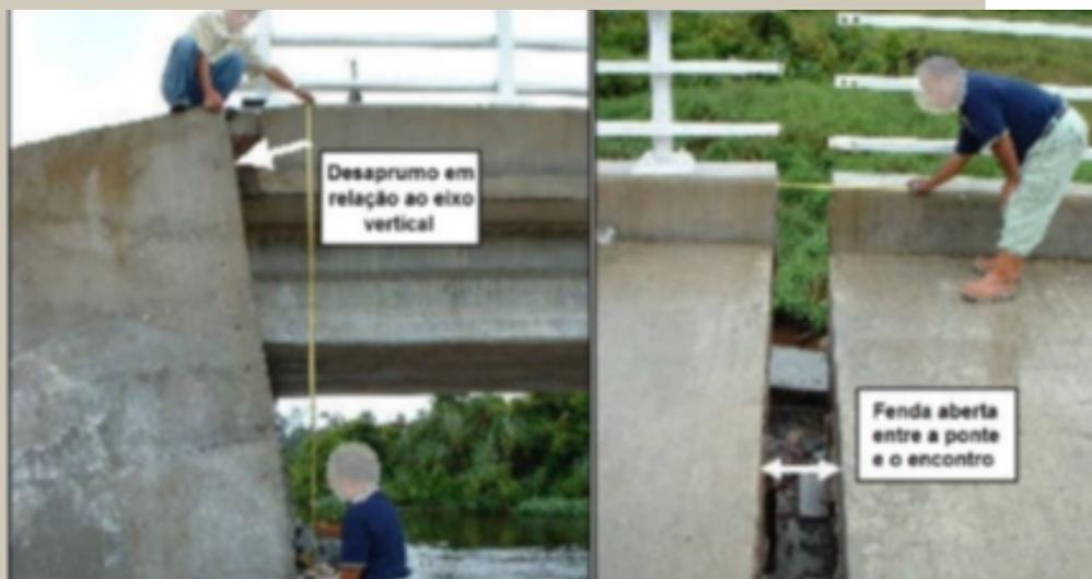
Figura 1 – Ocorrência de trinca vertical ou diagonal devido ao recalque diferencial da fundação: (a) Esquema ilustrativo; (b) Exemplo de trinca devido ao recalque
