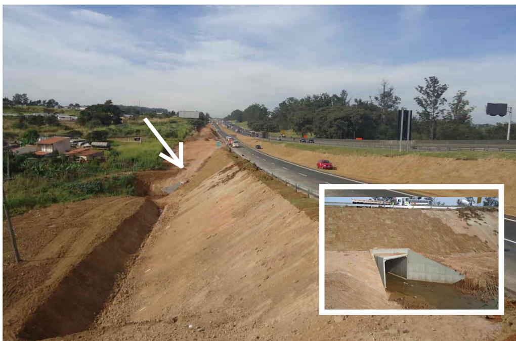
Figura 9 - Ampliação estradal na rodovia Anhanguera (SP-330), com criação de uma via marginal. Houve necessidade de melhoramento do solo devido a presença de solo mole e a altura do aterro com 12m. A particularidade importante foi a tubução de gás da Congás, com 800mm que ficou anexo ao aterro. Observar a nova galeria para o riacho existente.
