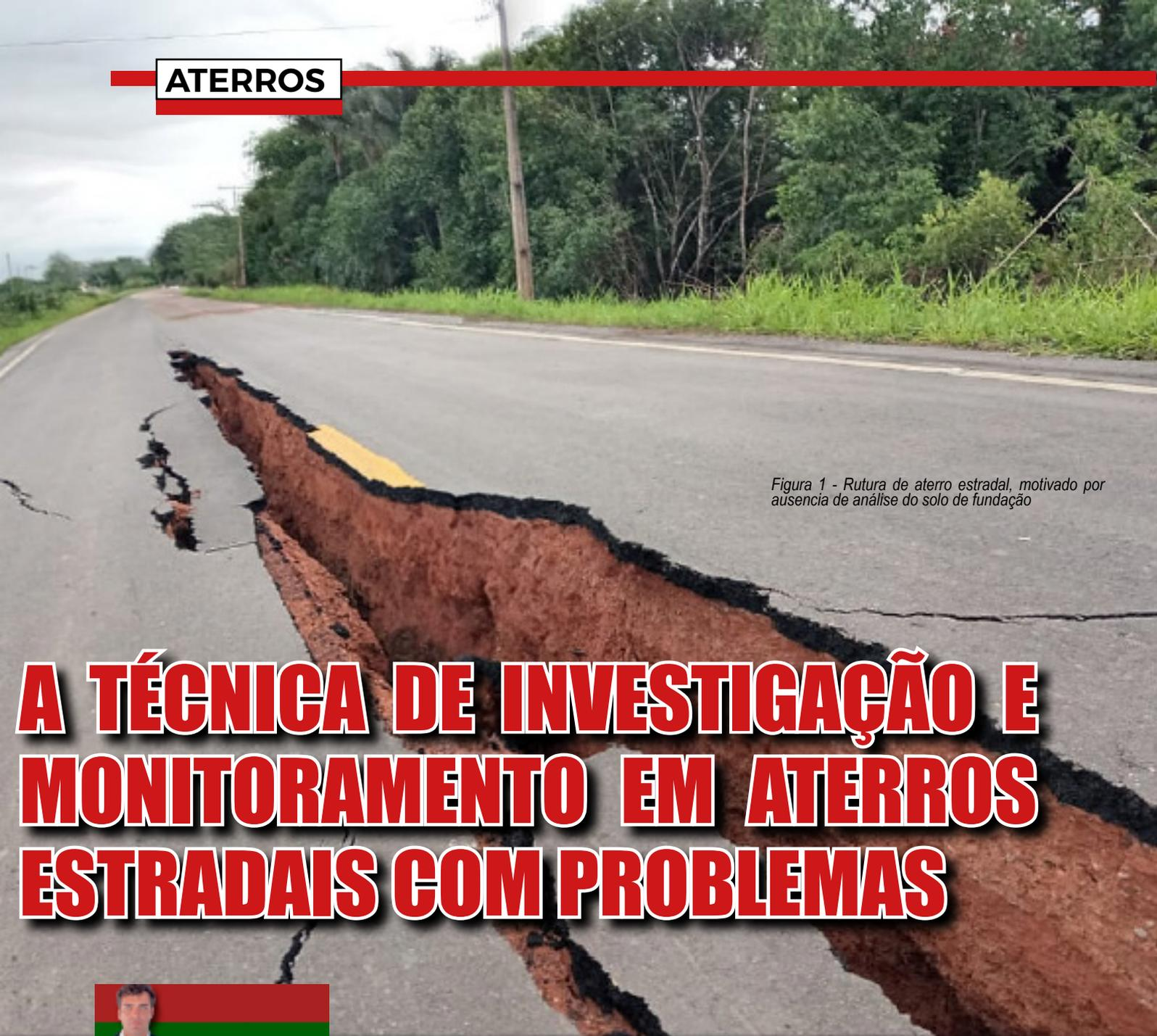
Figura 1 - Rutura de aterro estradal, motivado por ausência de análise do solo de fundação
