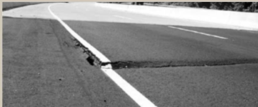
Figura 9 - Formação de desnível no pavimento sobre devido ao recalque no solo de fundação.
