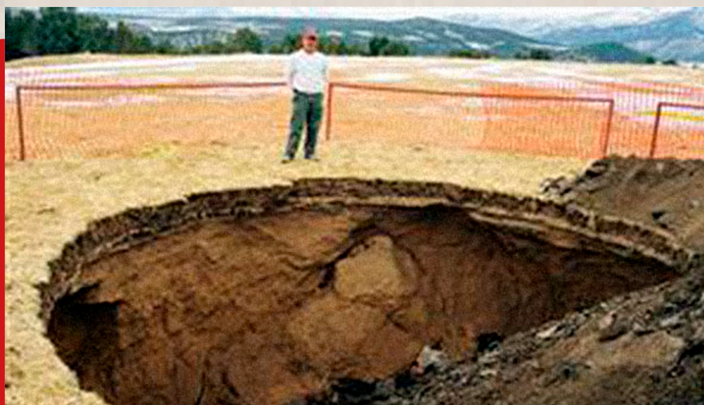
Figura 5 - Processo de ruptura rápida devido ao colapso do solo.
