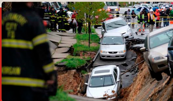
Figura 8 - Colapso do solo após intensas chuvas.
