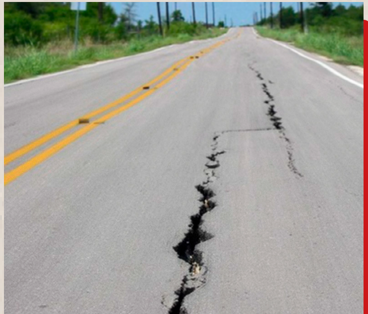
Figura 2 - Exemplo de uma rodovia danificada com subleito apresentando argila expansível danificada não identificada e sem qualquer melhoramento.
