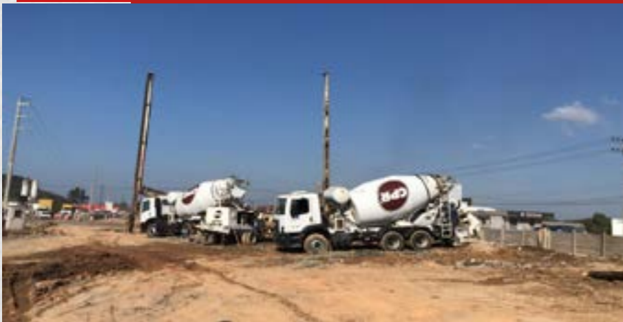
Ampliação estradal sendo executada na BR- 470, perto de Navegantes, SC.
