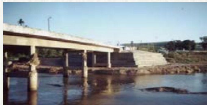
Figura 3 - Reconstrução de aterro de acesso com proteção em gabiões.
