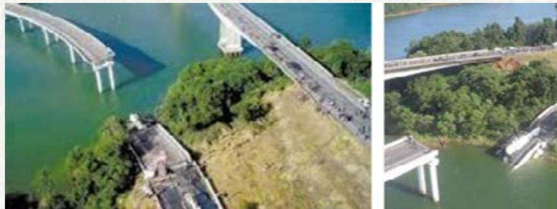
Figura 8 - Aspectos do desabamento da ponte sobre a represa do Rio Capivari na BR 116/PR.
