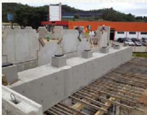
Figura 9: Componentes de um encontro de um viaduto, viga travessa, base dos apoios das longarinas, com os neoprenes e, atrás, a parede de contenção do encontro.
