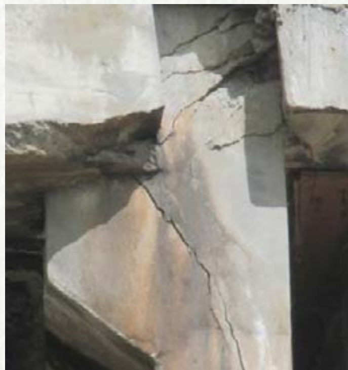
Figura 10 - Graves danos, caracterizados pelas trincas e fraturas, causados na cortina e no console pela rotação da laje de transição.
