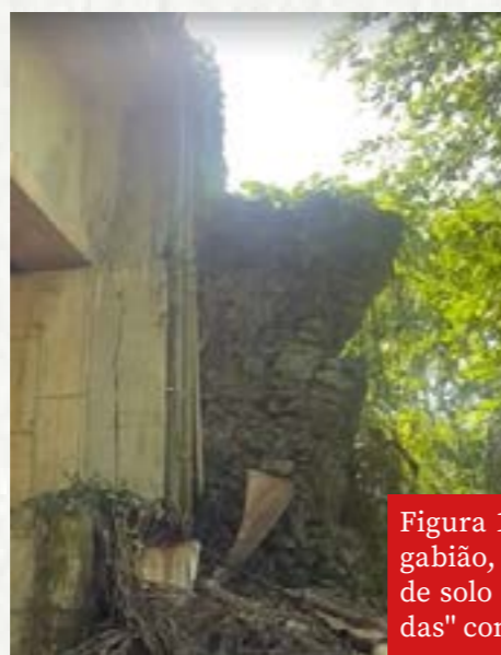
Figura 10 - Graves danos, caracterizados pelas trincas e fraturas, causados na cortina e no console pela rotação da laje de transição.
