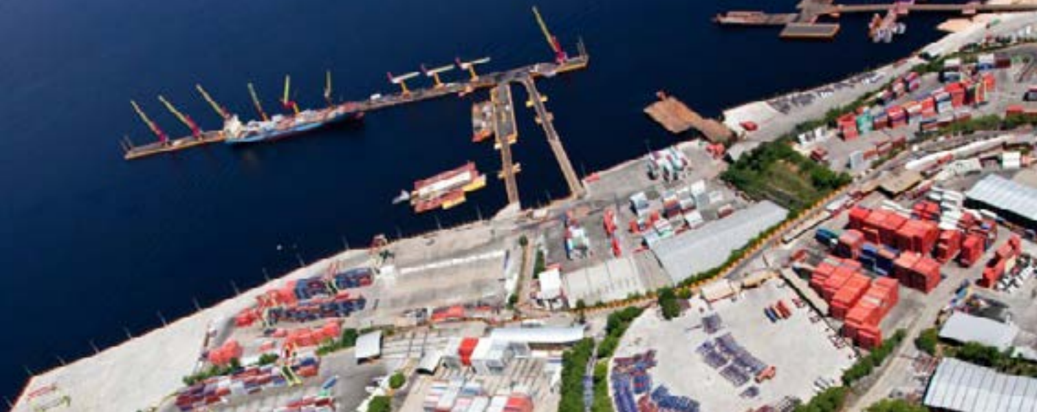
Área portuária de Manaus, após os serviços concluídos de melhoramento de solos. A área do cais foi toda retificada e ampliada.
