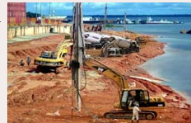
Com a margem portuária preparada, o serviço de melhoramento de solo foi iniciado.
