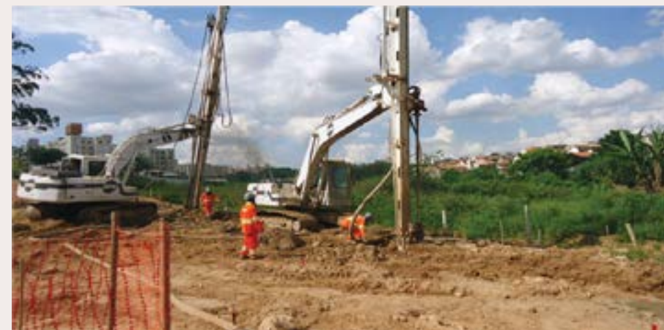
Formação das verticais do geoenrijecimento do solo mole, via expansão dos bulbos, que geram compressão radial, em toda a área de solo mole – muito mole, atrás de malha adequada.
