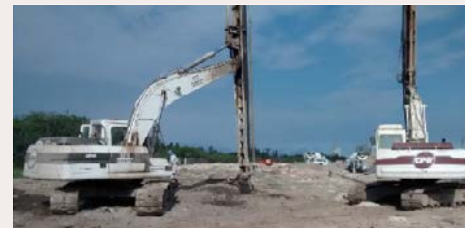
Melhoramento do solo sendo executado.
