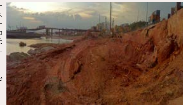
O fenômeno da liquefação de grandes extensões, na zona portuária de Manaus, em 2010, que impactou a vida em todo o estado.
