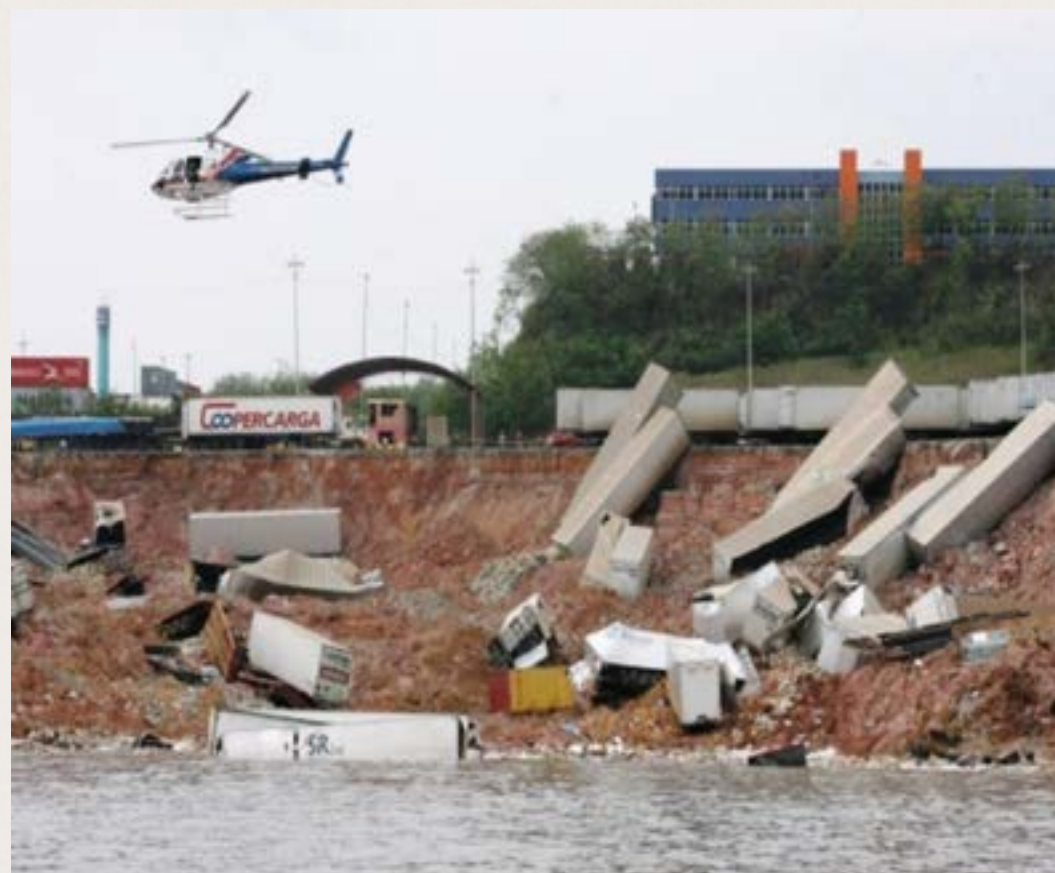
Cerca de 50 mts de largura da margem portuária de Manaus, na vazante do Rio Negro veio a baixo, via liquefação, em uma extensão superior a 1,500 mts, estabelecendo uma altura do talude (na vazante) de quase 20 mts.
