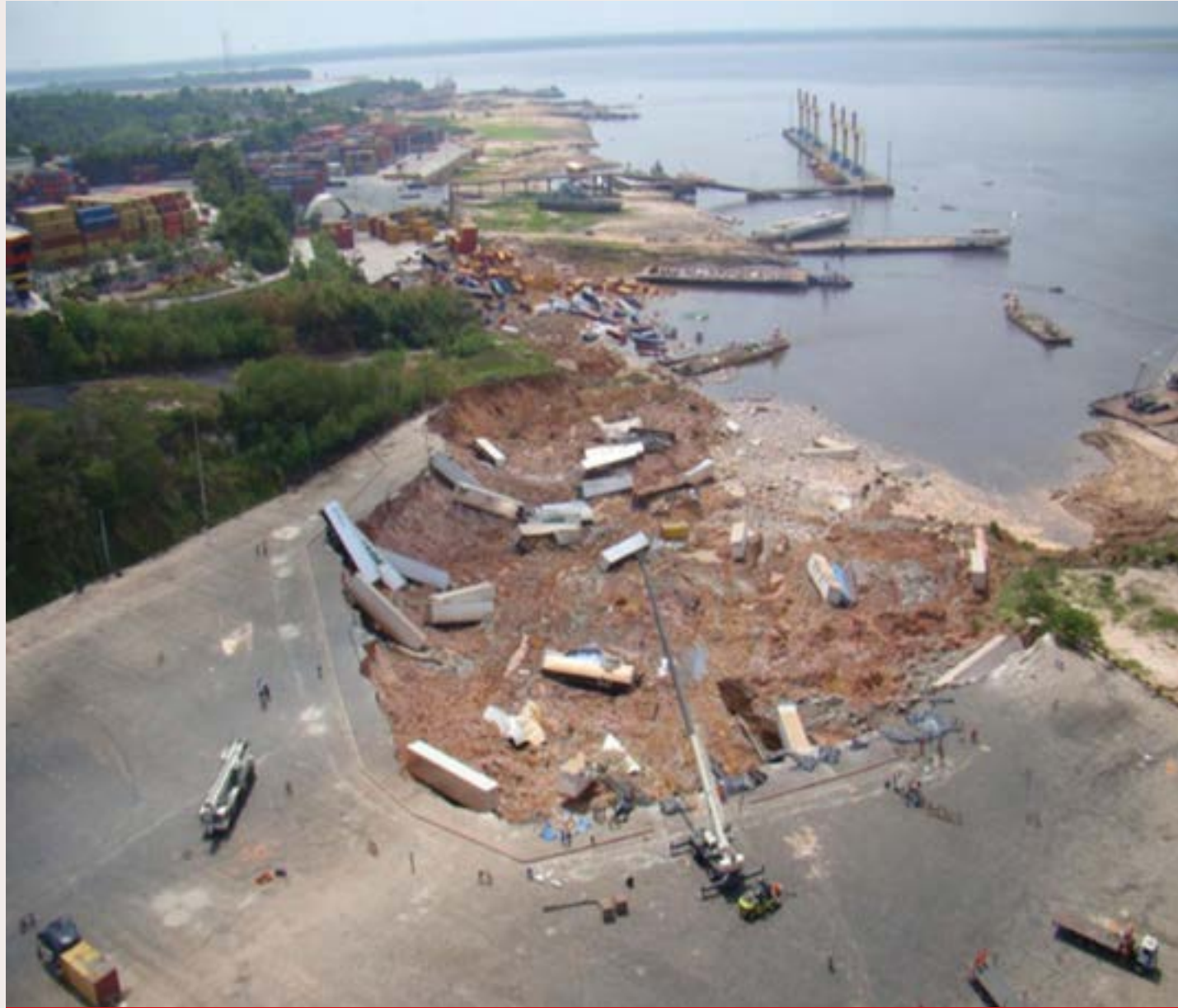
Uma das áreas, da zona portuária de Manaus, acometida por liquefação em 2010, com fluxo limitado a espalhamento lateral.
