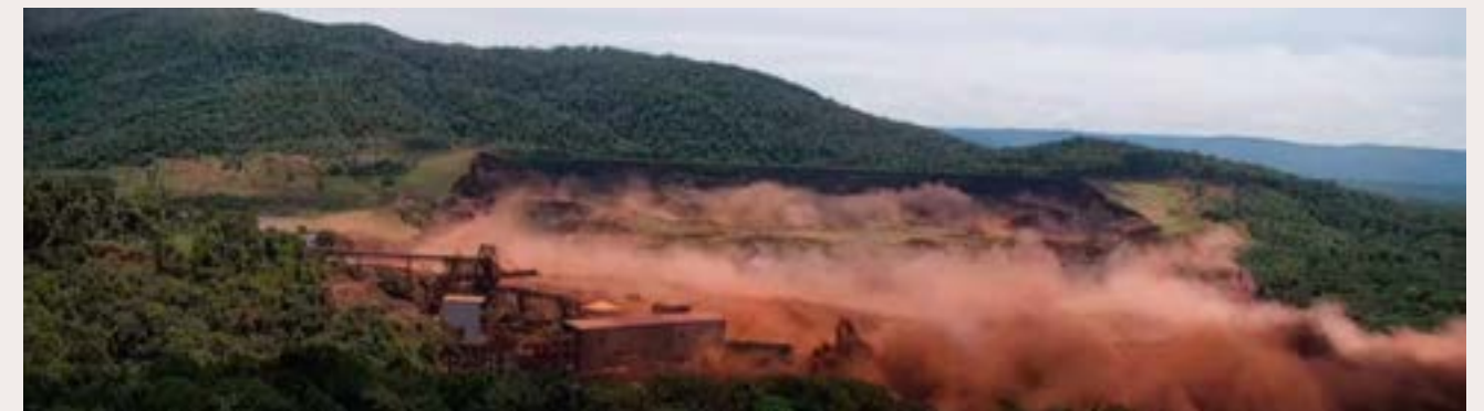
Alguns segundos após o início da rutura por liquefação da barragem de Brumadinho, em Minas Gerais com fluxo ilimitado.
