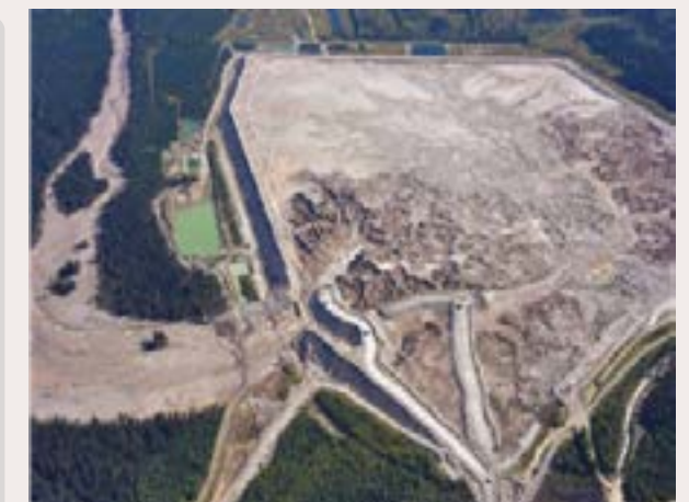
Nesta barragem de rejeitos, também com rutura por liquefação com fluxo ilimitado.
