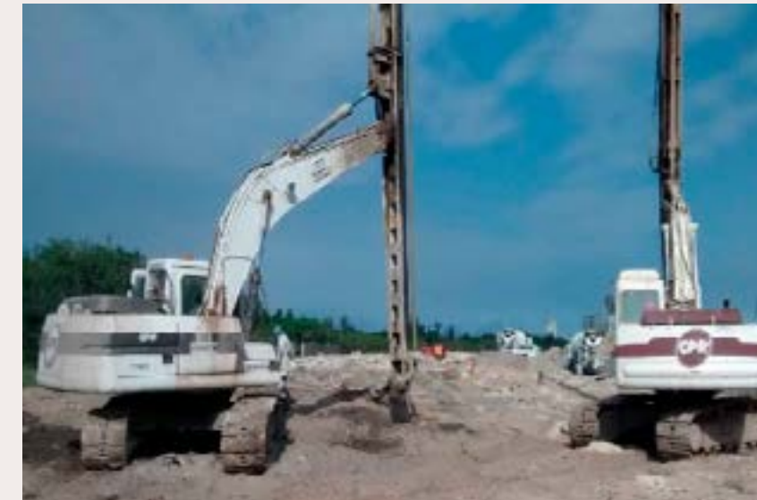
Cravação de geodrenos e a formação de bulbos de compressão do solo. Trata-se do melhoramento do solo com geoenrijecimento.
