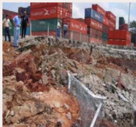
Uma enorme extensão da margem portuária veio abaixo por liquefação.
