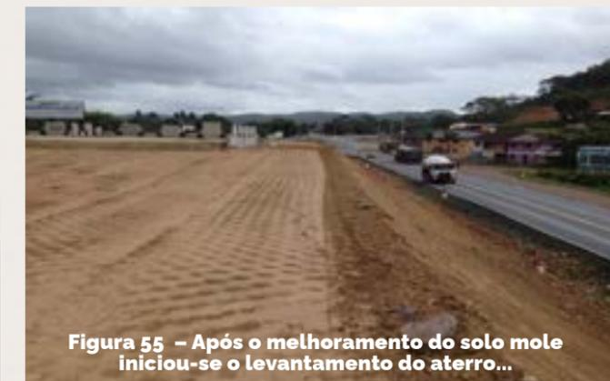
Figura 55 – Após o melhoramento do solo mole iniciou-se o levantamento do aterro...
