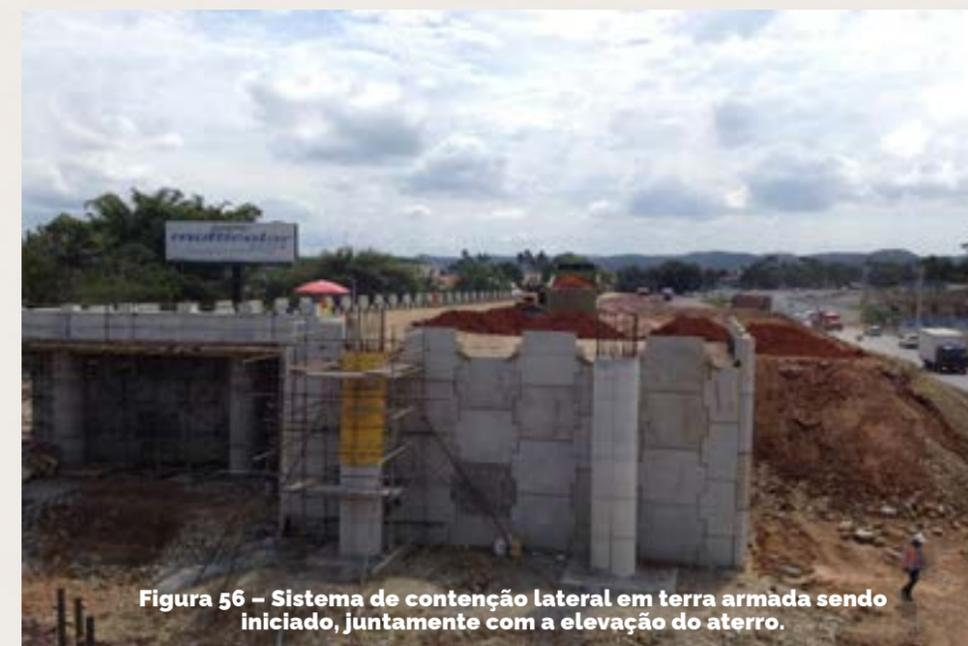
Figura 56 – Sistema de contenção lateral em terra armada sendo iniciado, juntamente com a elevação do aterro.
