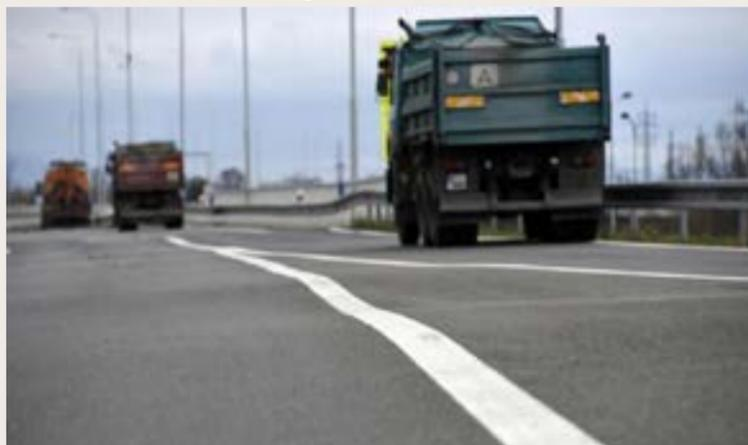
Figura 18 - Ausência de melhoramento efetivo no solo mole. Deformações incessantes depreciam e tornam a rodovia perigosa.
