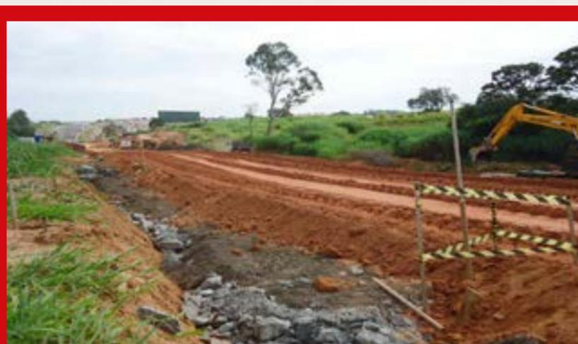
Figura 24 - Elevação de aterro estradal, após melhoramento de solos moles.
