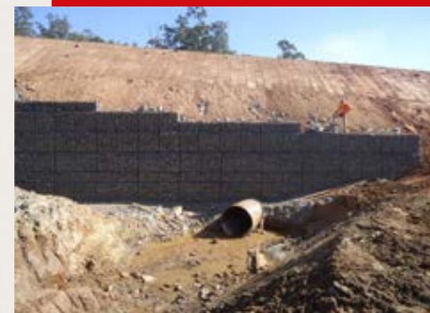
Figuras 7 e 8: Após o melhoramento do solo, a preparação para elevar o aterro para a construção de outra marginal na via Anhanguera.
