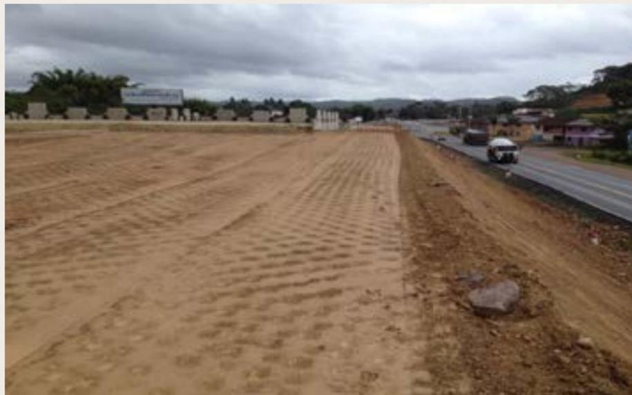
Figura 25 - Elevação de aterro, em encontro de viaduto, após o melhoramento do solo mole.
