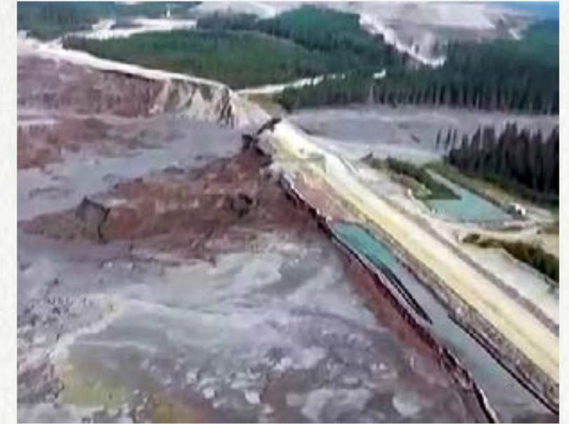
Figura 4: A ruptura deste reservatório de rejeitos liberou cinco milhões de metros cúbicos de rejeitos de mineração em cursos d'água locais.
