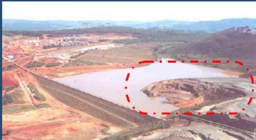
Figura 8: Barragem de rejeitos, com material depositado com classificação de argila siltosa, de consistência mole, cor marrom escuro avermelhado.
