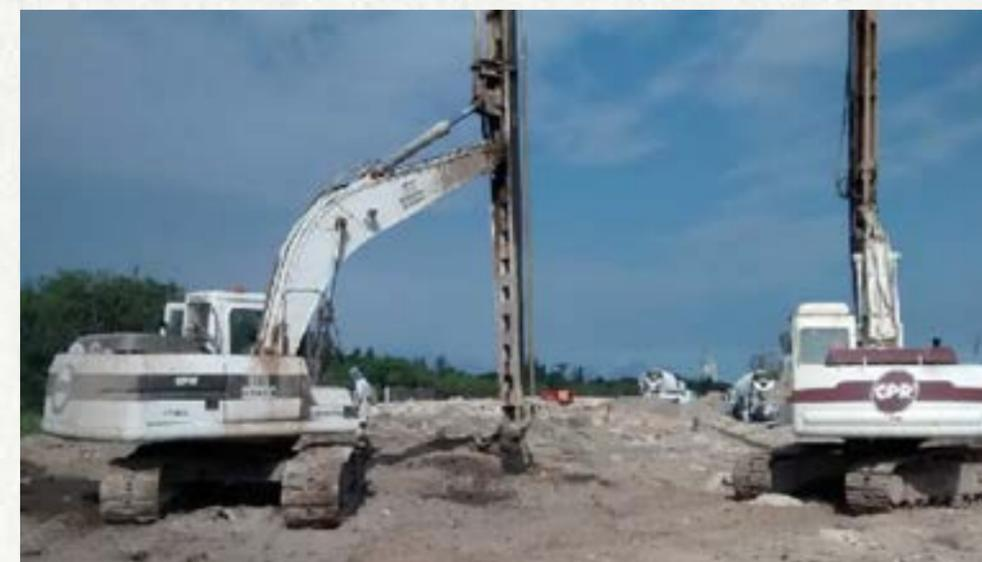
Figura 13: Cravação de geodrenos e a formação de bulbos de compressão do solo. Trata-se do melhoramento do solo com geoenrijecimento.
