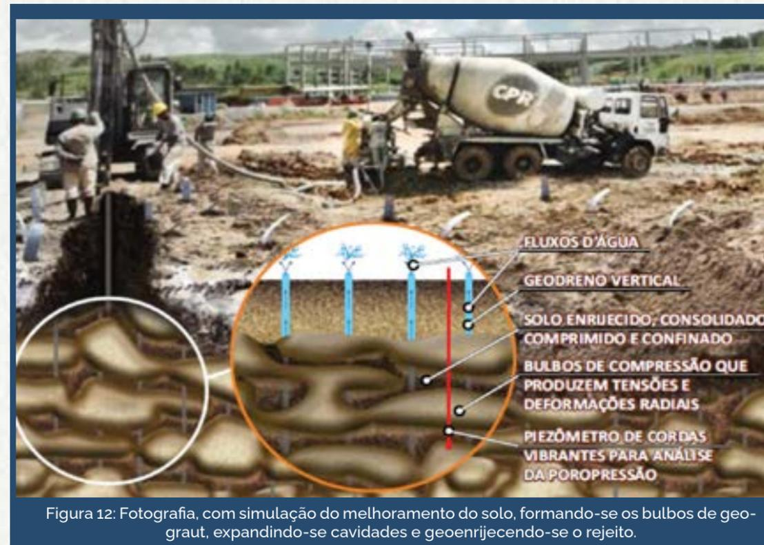
da resistência e da rigidez do solo, conforme previamente dimensionado.
