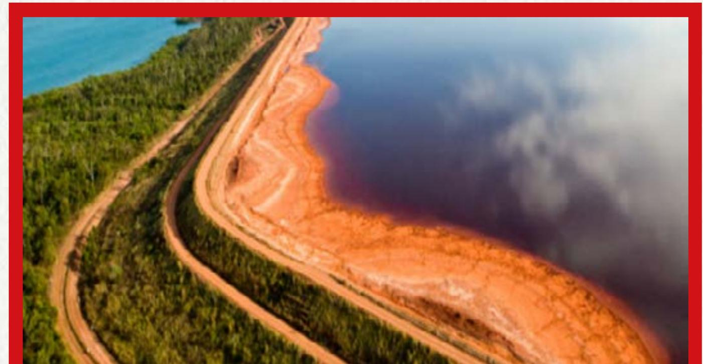
Figura 4: Típica barragem de rejeitos observando-se a formação das praias.
