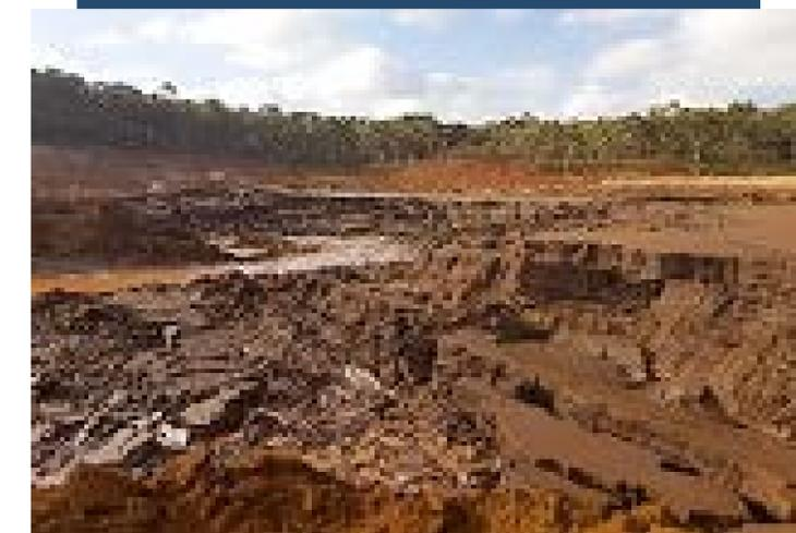
(b) ruptura por excesso de umidade em frente da escavação.
