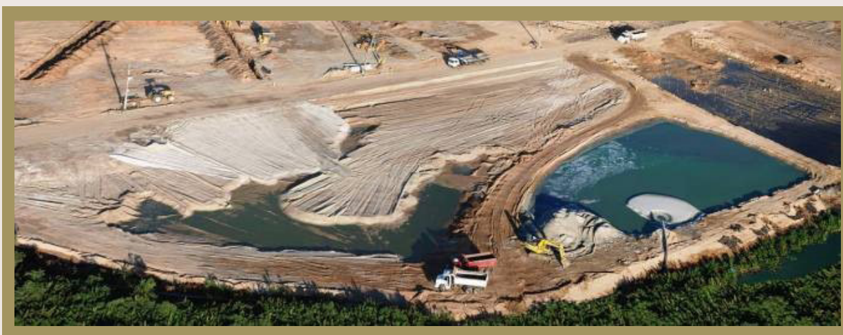
O material do desassoreamento, com dragagem, é lançado no canto direito inferior da foto, utilizado em toda a obra, como insumo e aterro.
