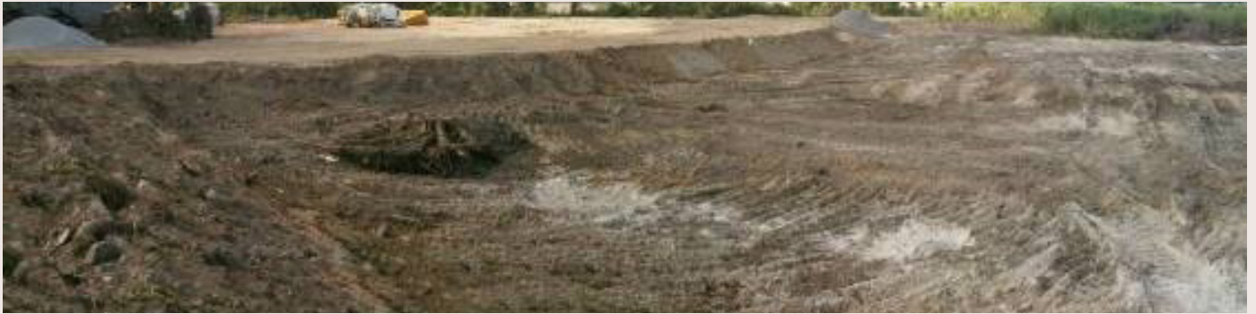
Situação do Dique 1 após a instalação do aterro de conquista.
