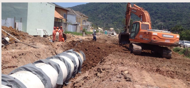
Após o melhoramento do solo, inicia-se a construção da infraestrutura do bairro
