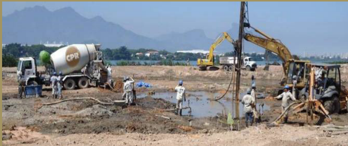
Formação das verticais de adensamento, com lança longa. Repare a presença do caminhão betoneira no meio da área melhorada do Dique 1: excelente prova de carga.
