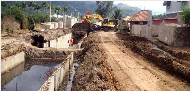
Construção de canais, só viabilizado com o melhoramento do solo mole
