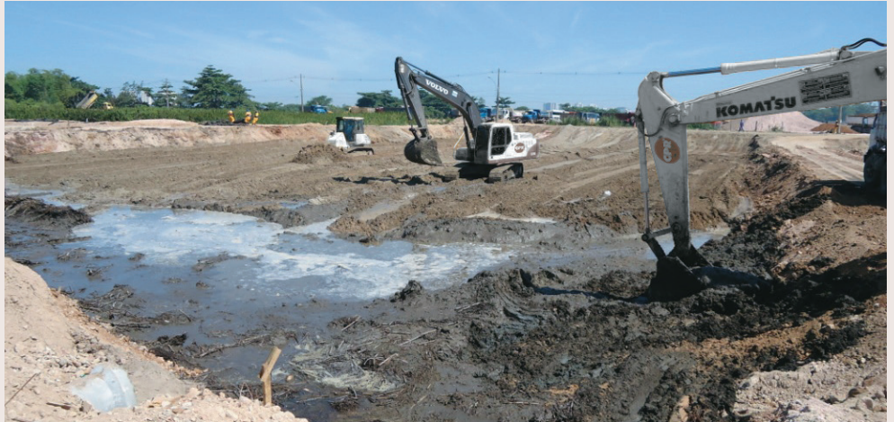
Colocando o aterro de conquista sobre o solo muito mole
