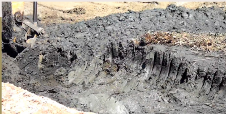
Remoção de camada superficial de solo muito mole para execução do aterro de conquista
