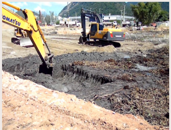
A remoção da vegetação e da lama superficial, seguindo-se a instalação do aterro de conquista.
