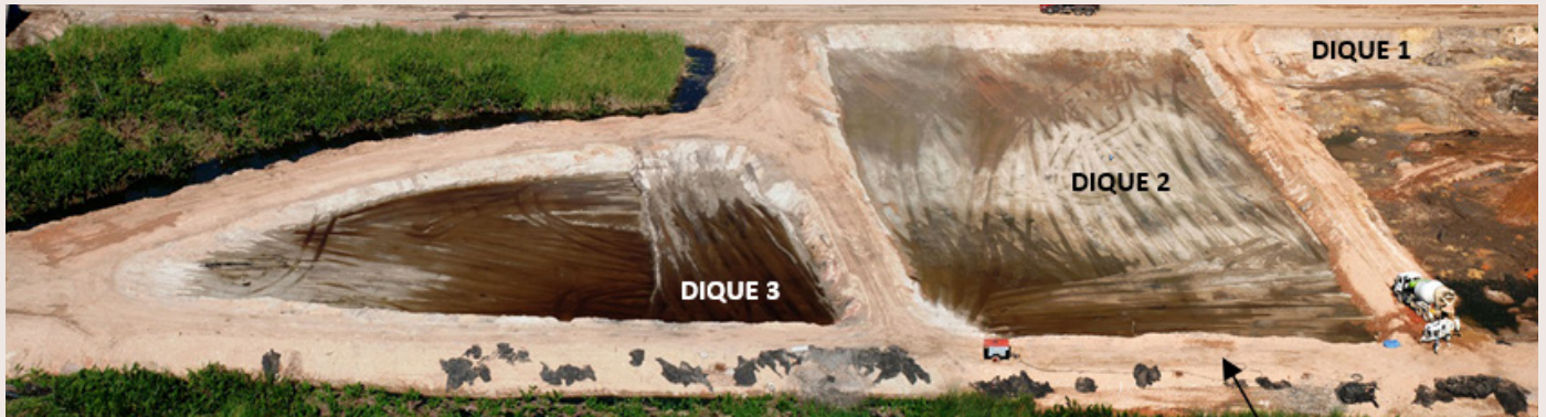
Situação da obra com a definição pavimento ensecadeira e os Diques 1, 2 e 3.
