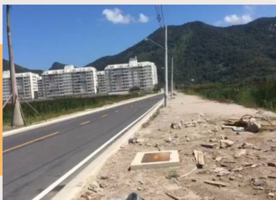
Situação após a execução dos serviços de geoenrijecimento, nos depósitos de solo mole, necessário para permitir a construção das instalações de água, esgoto e eletricidade, além do sistema de drenagem e vias de acesso.
