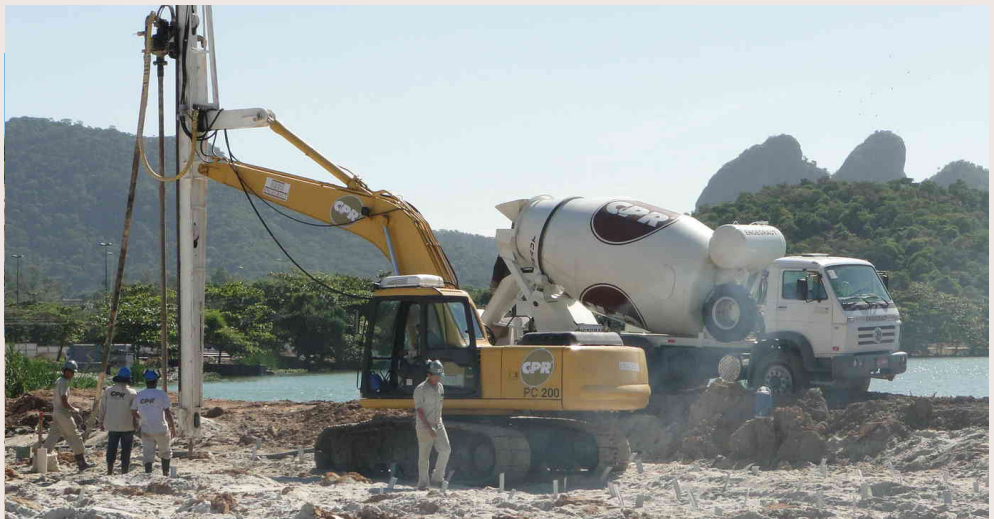
O geoenrijecimento, com a formação de bulbos, que comprimem radialmente o solo, adensando-o
