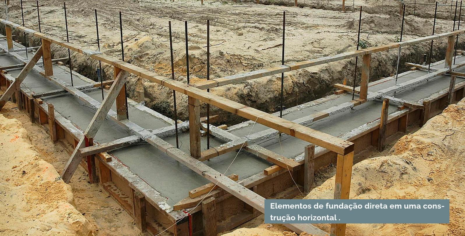
Elementos de fundação direta em uma construção horizontal .
