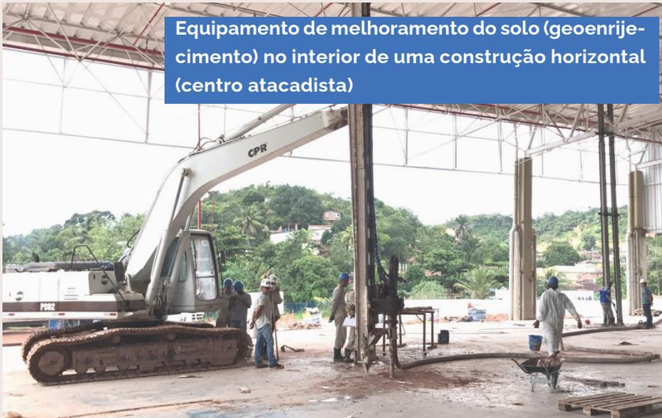
Equipamento formador da técnica de coluna de brita
