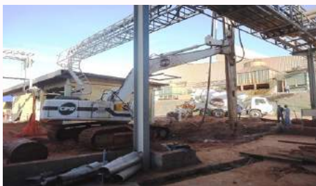
Figura 5: Serviços de geoenrijecimento do solo de fundação com geoenrijecimento para interromper intenso processo de recalque.
