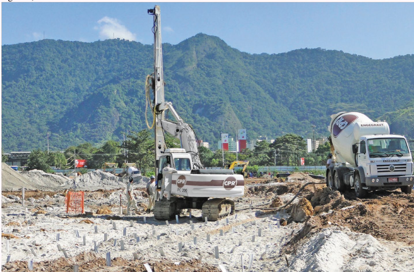
Figura 3: Aplicação do geoenrijecimento para aumento da rigidez e resistência do solo mole na zona Oeste do Rio de Janeiro. O intenso efeito radial compressivo, efetuado em cada metro cúbico da massa de solo mole, em meio drenante artificial, com bulbos de geograut, impõe os níveis de rigidez e de resistência desejados.
