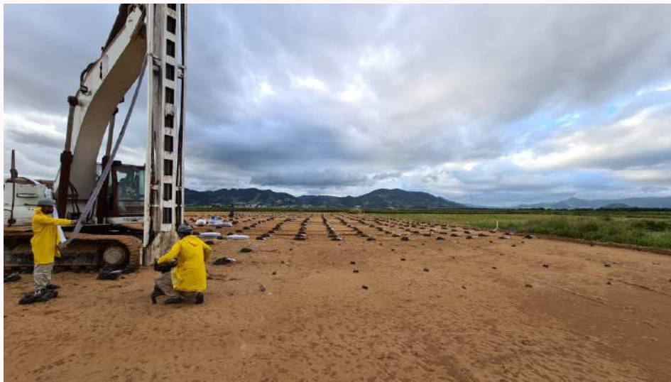
Figura 7 : Aplicação de geodrenos, para geoenrijecimento do solo.
