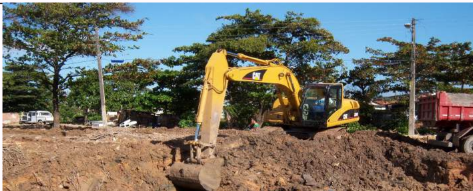
Figura 6: Após o melhoramento do solo de fundação, remove-se o aterro com presença de lixo, substituindo-o por material compactável, que servirá de base à fundação direta
