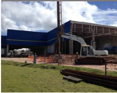
Figura 4: Intervenção, com geoenrijecimento do solo, para parar o processo de recalque diferencial e movimentação lateral, motivado pelo lançamento de aterro sobre solo mole, em um grande empreendimento logístico
