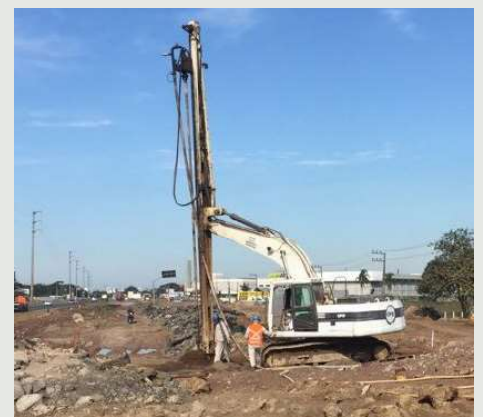
Figura 8: Melhoramento do solo mole com geoenriquecimento
