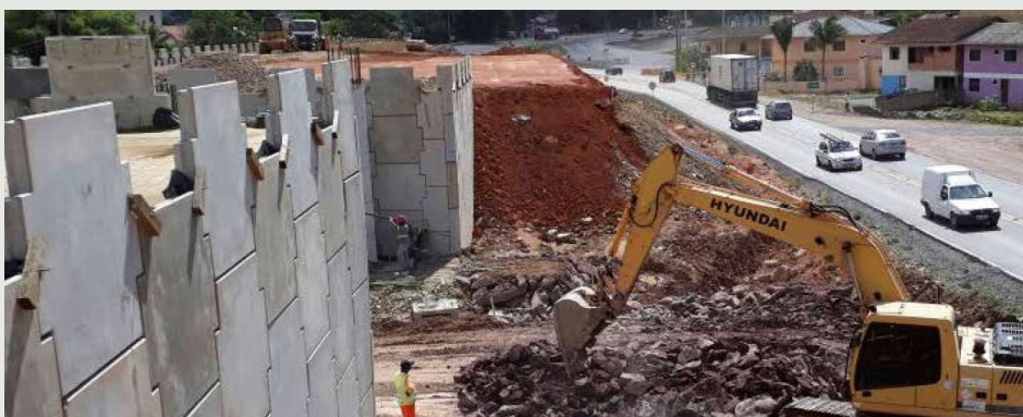
Figura 10: Elevação do aterro em terra armada, após o melhoramento do solo com geonrijecimento
