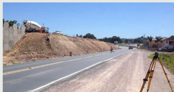
Figura 9: Elevação do aterro de encontro do viaduto
