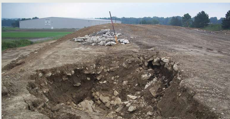
Figura 3: Início da rutura, onde metade do aterro inicia um giro para a esquerda
