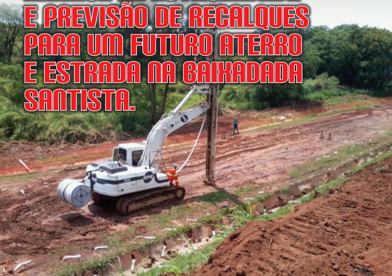
Figura 1 - A cravação de geodrenos, iniciando-se o melhoramento do solo mole de fundação.
