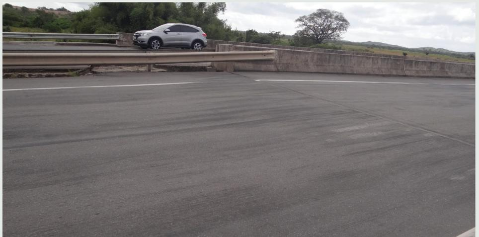
Figura 2 - Este tipo de recalque só é evitado, melhorando-se o solo adequadamente, obtendo-se níveis de rigidez compatíveis com o carregamento imposto.
