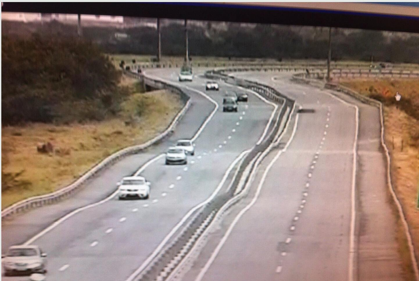
Figura 09 - O grande problema do método de melhoramento de solos moles com pré-carregamento: recalques diferenciais ao longo das estradas. Ou seja, depósitos de solos moles mais profundos que 5m, este método não é eficaz.
