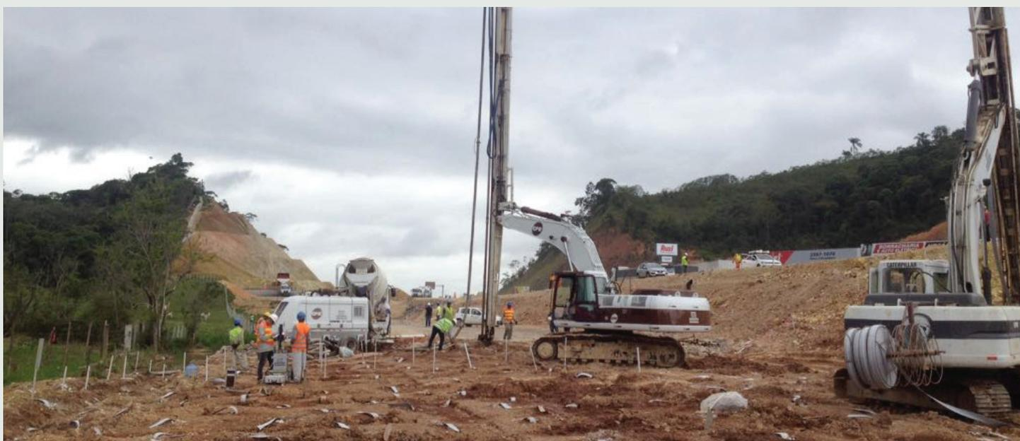
Figura 3 - Melhoramento de solos moles, em uma duplicação rodoviária no sul do país, iniciando-se com a cravação de geodrenos, seguido da formação dos bulbos de compressão radial do solo ao longo de toda a profundidade de solo mole.
