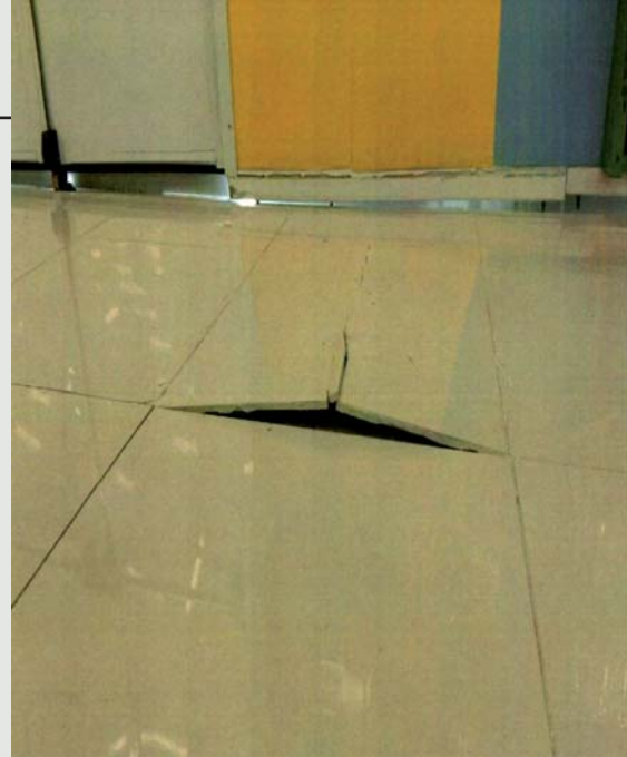
Figura 6 - Nesta loja de departamentos, onde havia presença de profundos depósitos de solos moles, o projetista dimensionou um aterro de 3m, mais o pavimento. As paredes periféricas e seus pilares apoiados em estacas. O pavimento sofreu deformações, na forma de ondas, com concavidade da ordem de 30cm...
