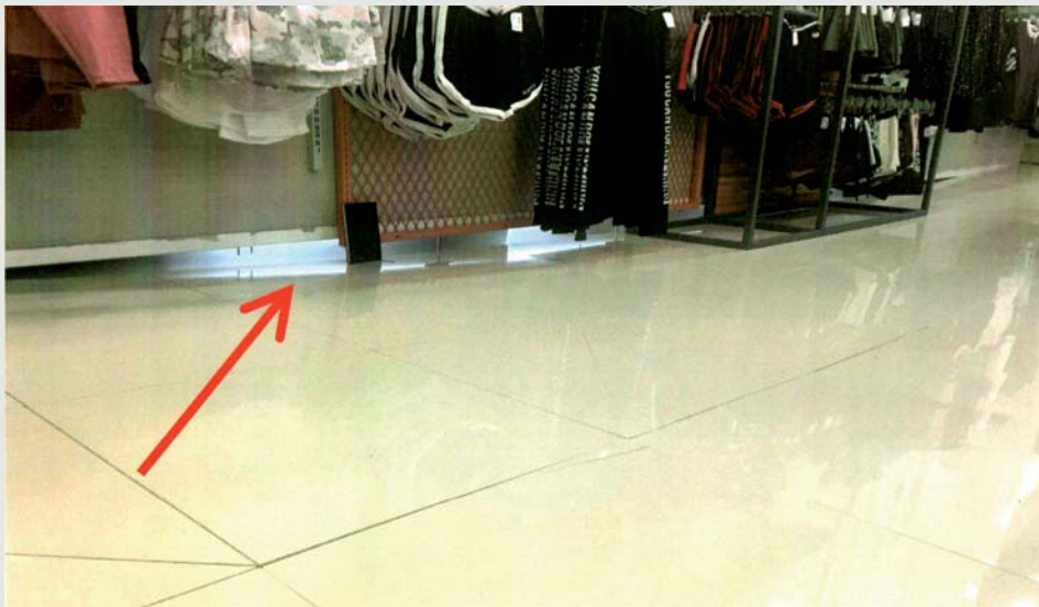
Figura 6 - Nesta loja de departamentos, onde havia presença de profundos depósitos de solos moles, o projetista dimensionou um aterro de 3m, mais o pavimento. As paredes periféricas e seus pilares apoiados em estacas. O pavimento sofreu deformações, na forma de ondas, com concavidade da ordem de 30cm...
