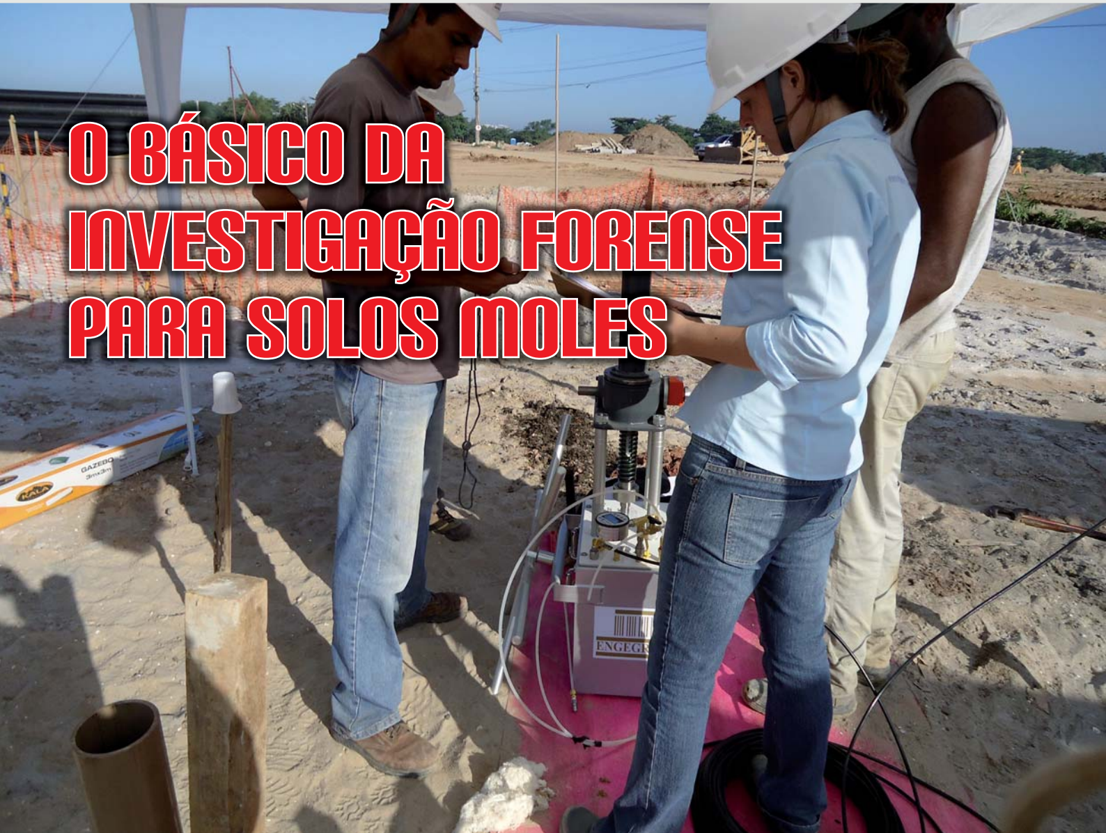
Figura 1 - Análises pressiométricas são necessárias para certificar o melhoramento do solo mole, obtendo-se a relação tensão-deformação ou o módulo pressiométrico, necessário para entender sua compressibilidade antes e pós melhoramento do solo. Da mesma maneira a análise tomográfica por imagem.
