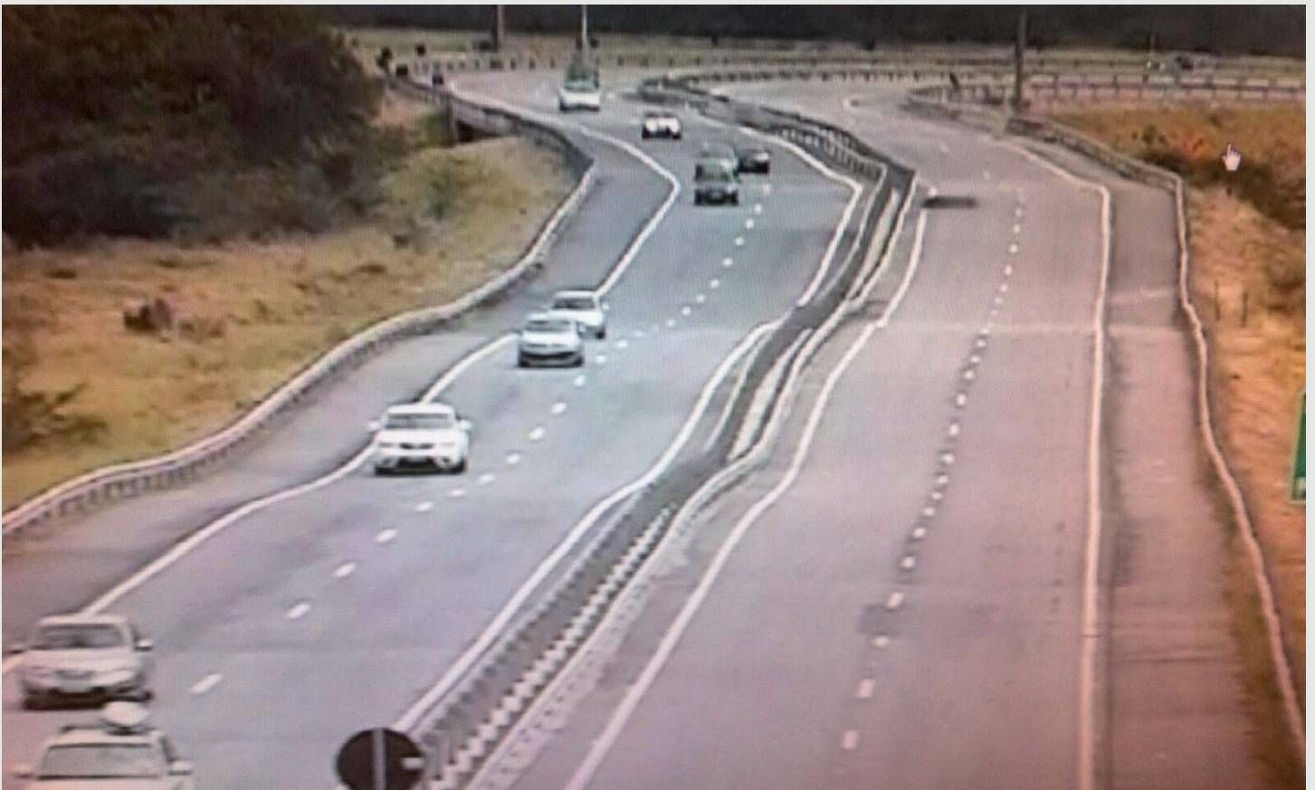
Figura 3 - Esta é a condição de muitas estradas e rodovias. Soluções ingênuas com precarregamento, quando da existência de profundos depósitos de solos moles, não trazem os benefícios desejados, implicando em grandes recalques.
