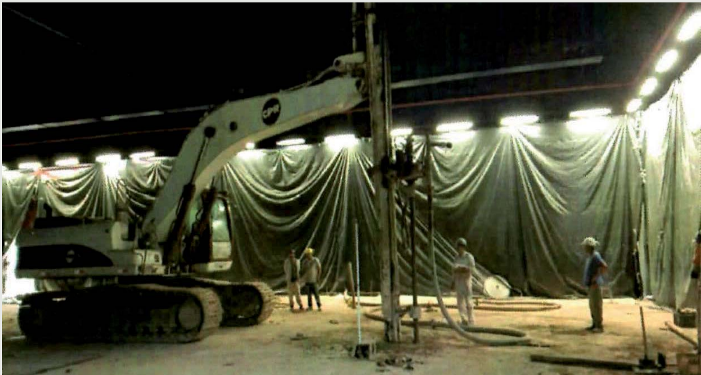
Figura 7 - ... A solução foi idealizada com melhoramento de solos, utilizando-se Geoenrijecimento.
