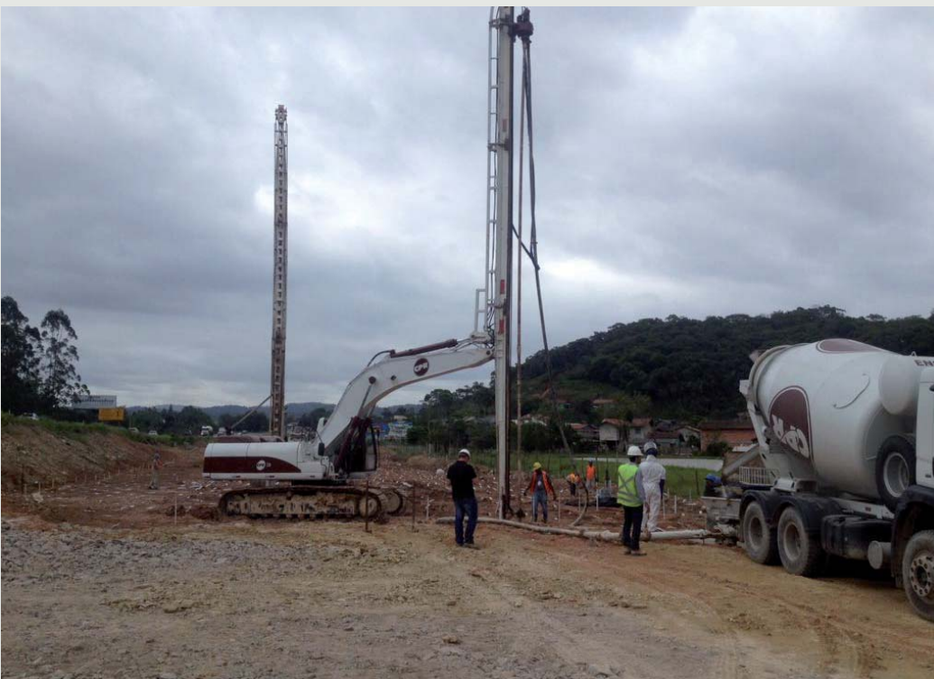
Figura 3 - Formação de verticais do Geoenrijecimento em uma ampliação rodoviária no Sul do país.
