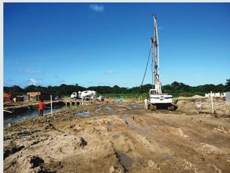
Figura 8 - Geoenrijecimento de terreno em solo mole para empreendimento no nordeste.
