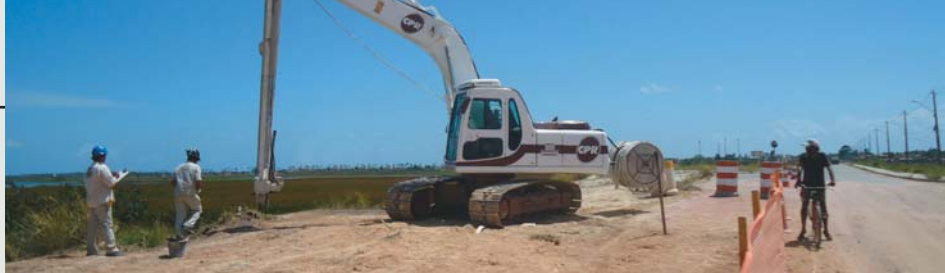
Figura 8 - A etapa de cravação dos geodrenos, no Geoenrijecimento, em uma ampliação no Recife, PE.
