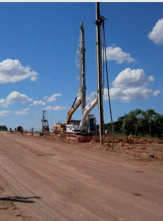
Figura 7 - Cravação de Geodrenos concomitante com a formação das verticais do Geoenrijecimento., em ampliação de estrada no Rio de Janeiro.
