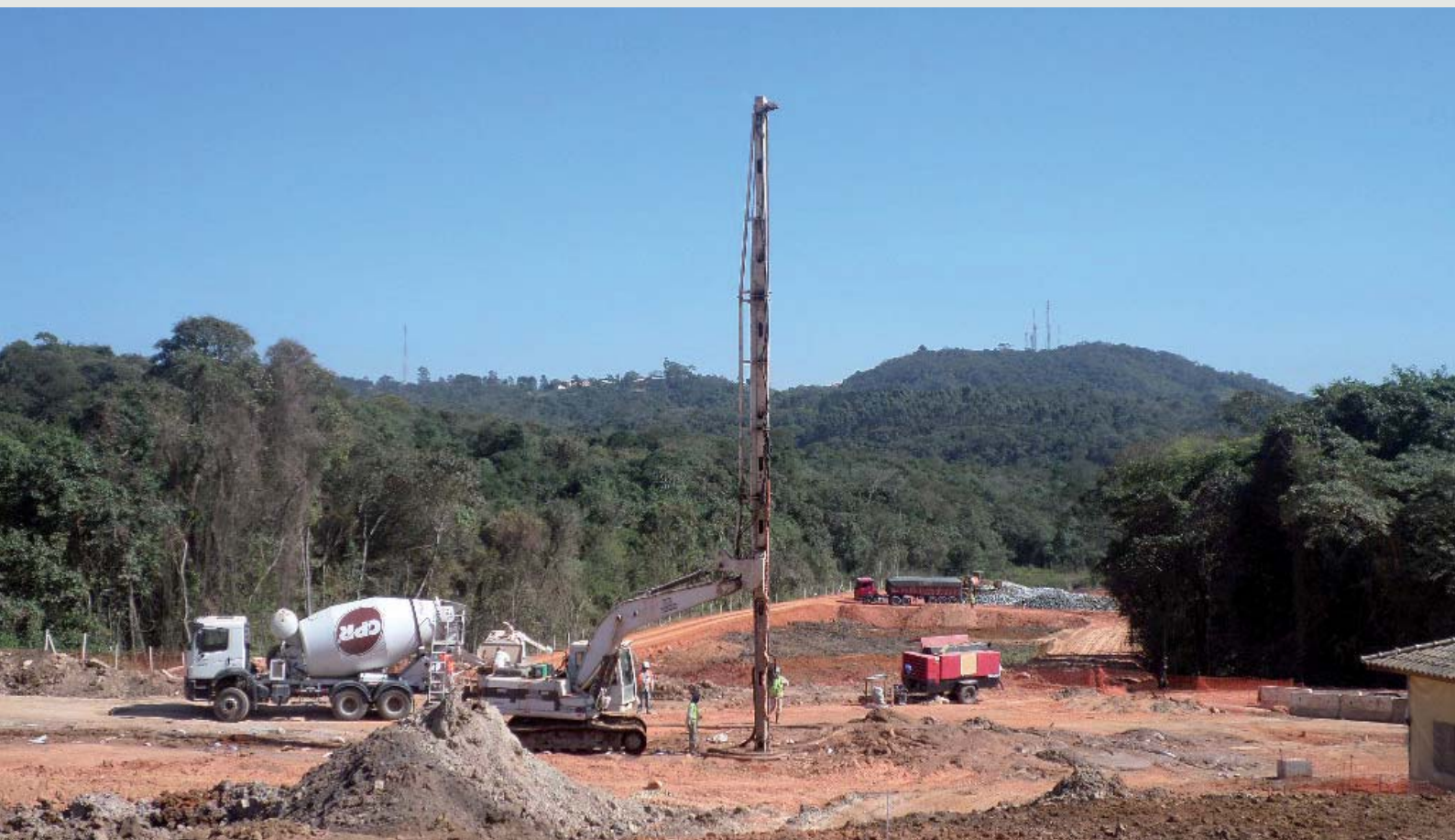
Figura 5 - Melhoramento do solo de fundação com Geoenrijecimento para empreendimento no sul do Brasil.
