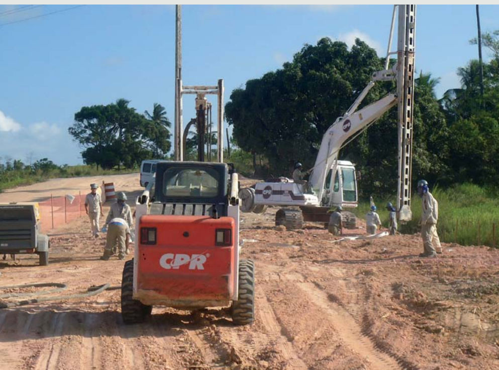
Figura 6 - Melhoramento do solo para a ampliação rodoviária na região de Recife, PE.
