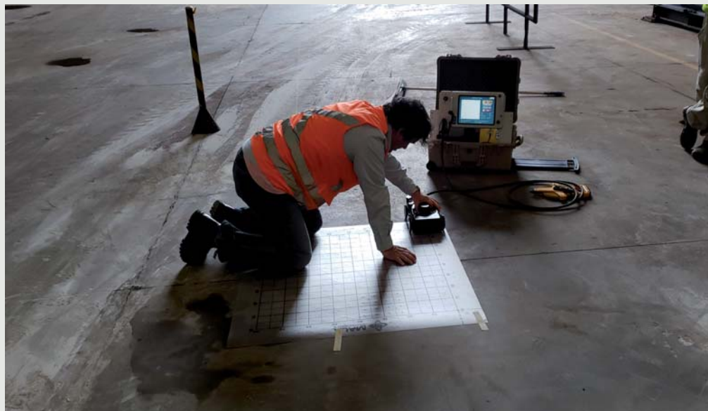
Figura 2 - Nesta mesma unidade industrial (acima) foram feitas sondagens GPR para verificar onde o aterro descolou da laje.
