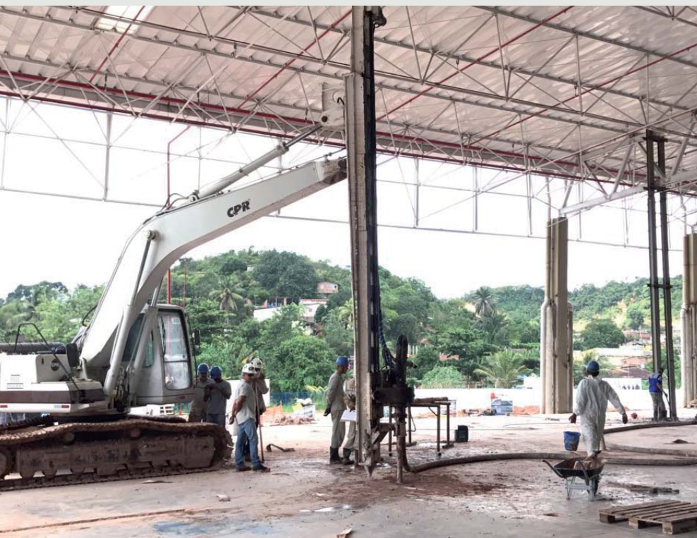
Figura 7 - Grande loja de supermercados em terreno com solo mole e talude submerso. O projetista elaborou seu projeto com fundação direta e profunda: grandes deformações tanto vertical quanto horizontal. O melhoramento do solo com Geoenrijecimento interrompeu o processo deformativo.
