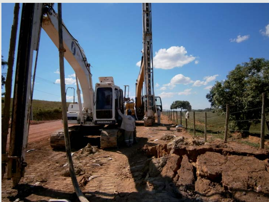
Figura 9 - Cravação de Geodrenos concomitante com a formação das verticais do Geoenrijecimento, em ampliação no Rio de Janeiro.
