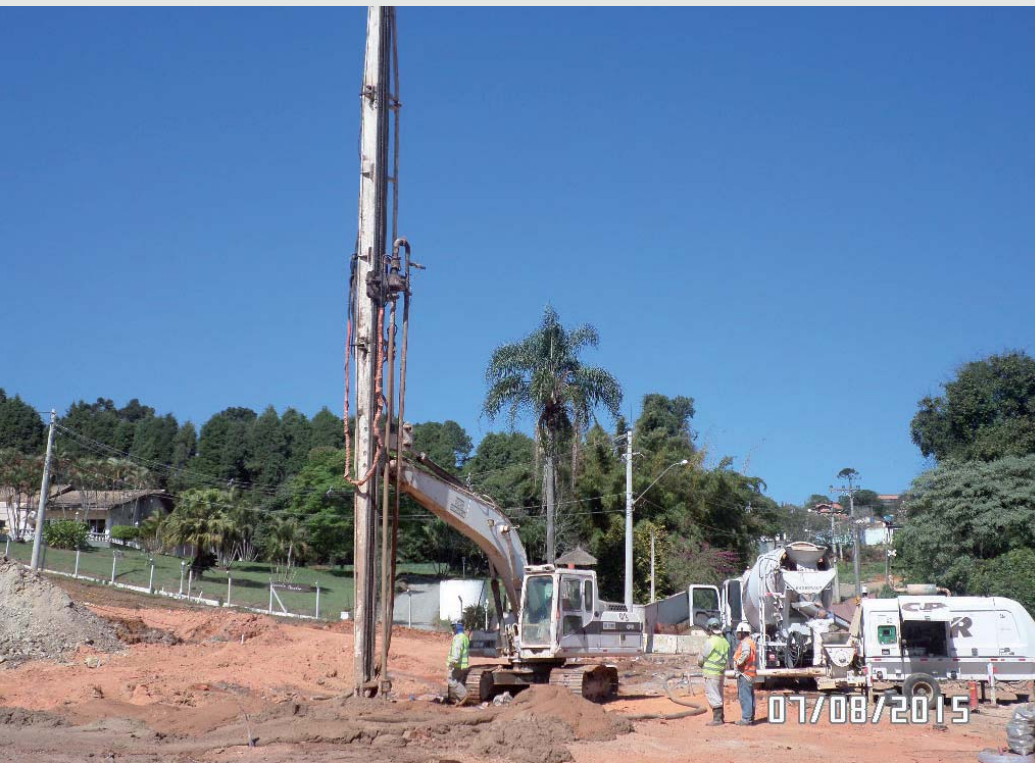
Figura 6 - Melhoramento do solo de fundação com Geoenrijecimento.
