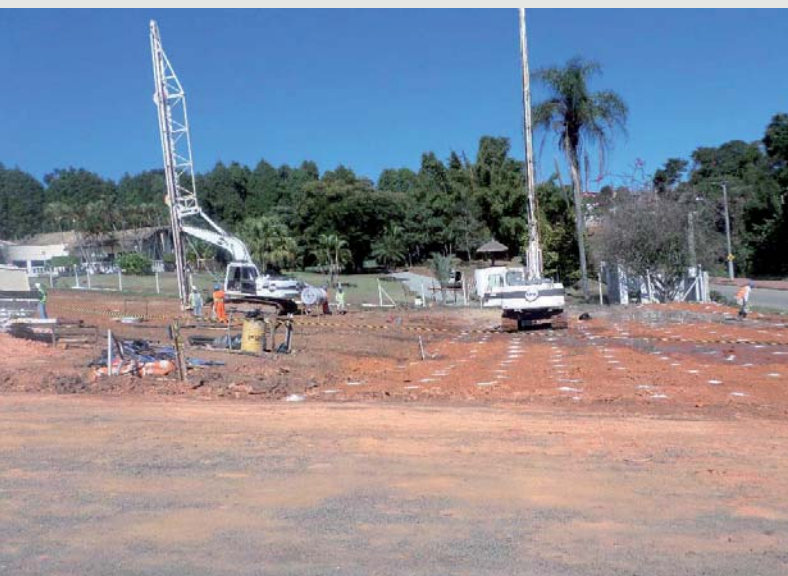
Figura 7 - Geoenrijecimento do solo de fundação para empreendimento no nordeste.
