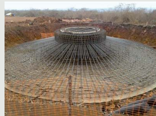
Figura 7 - Após a adequação do solo é feita a base circular de ancoragem armada, pronta para concretagem. As bases podem ser retangulares, trapezoidais mas, a mais comum é a circular.
