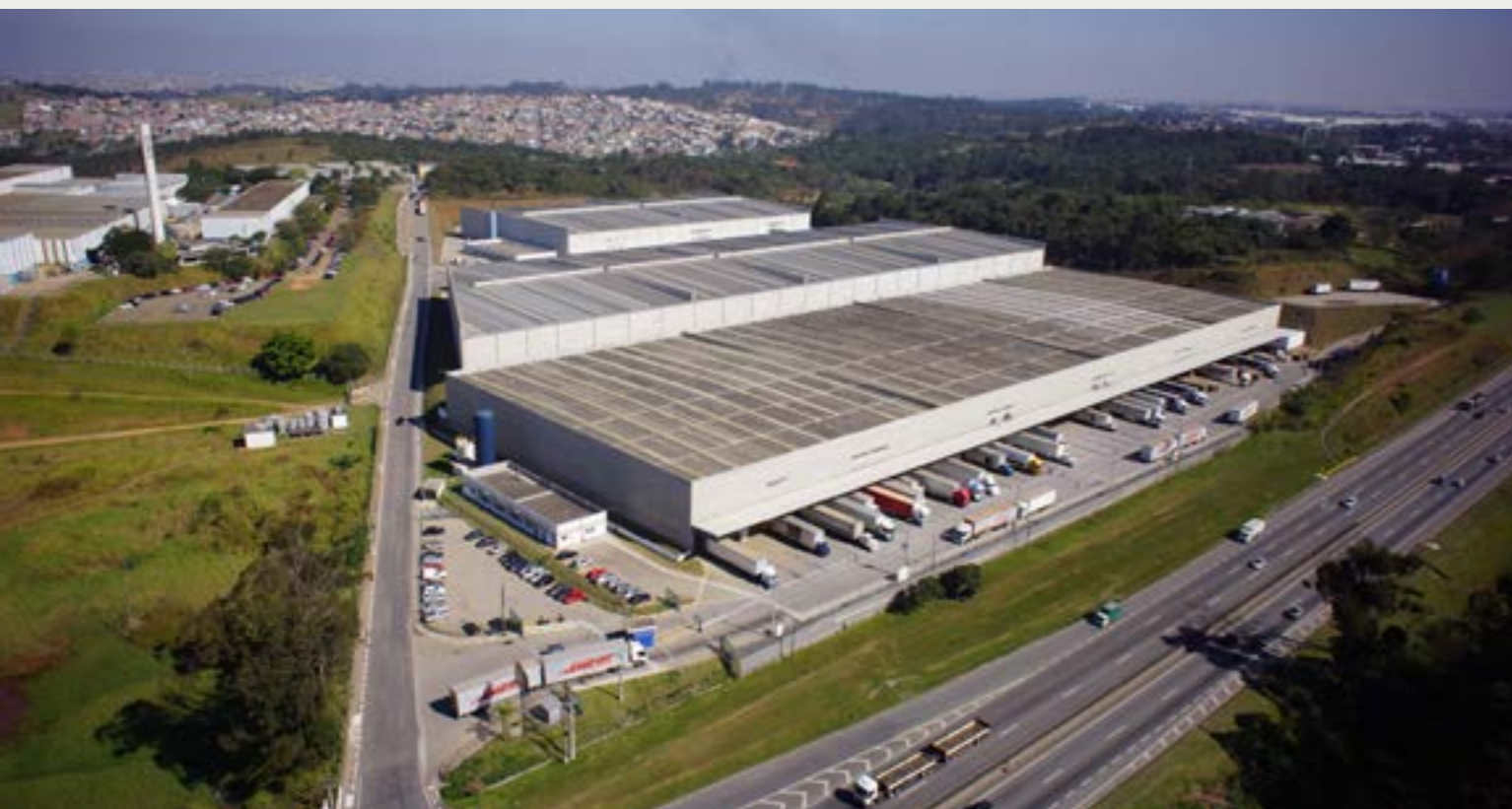
Figura 1 - Empreendimentos logísticos, típico como este, impõe diminutas tensões no solo da ordem de 5ton/m 2 , que com o melhoramento do solo encontra o melhor custo benefício. O estaqueamento pode até ser um pouco mais econômico, no entanto a ordem de problemas potenciais quando houver solo mole. A solução natural é o Geoenrijecimento.
