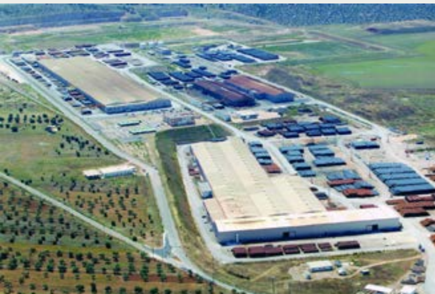
Figura 8 - Construção logística. O uso de fundação profunda impõe toda sorte de recalques diferenciais.
