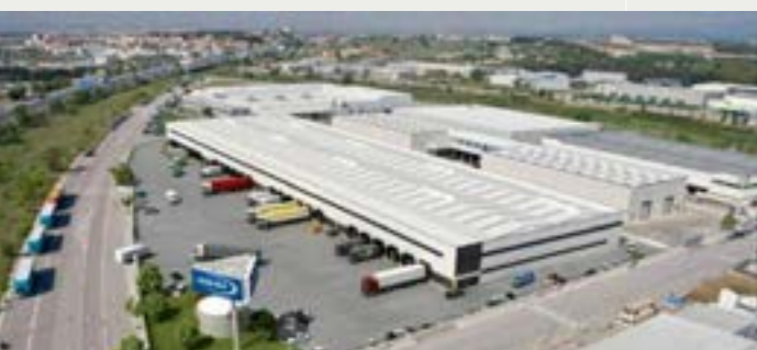
Figura 2 - Construção logística. Extensão horizontal e cargas leves..
