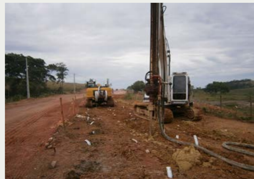
Figura 6 - Melhoramento do solo com vistas a uma ampliação rodoviária.
