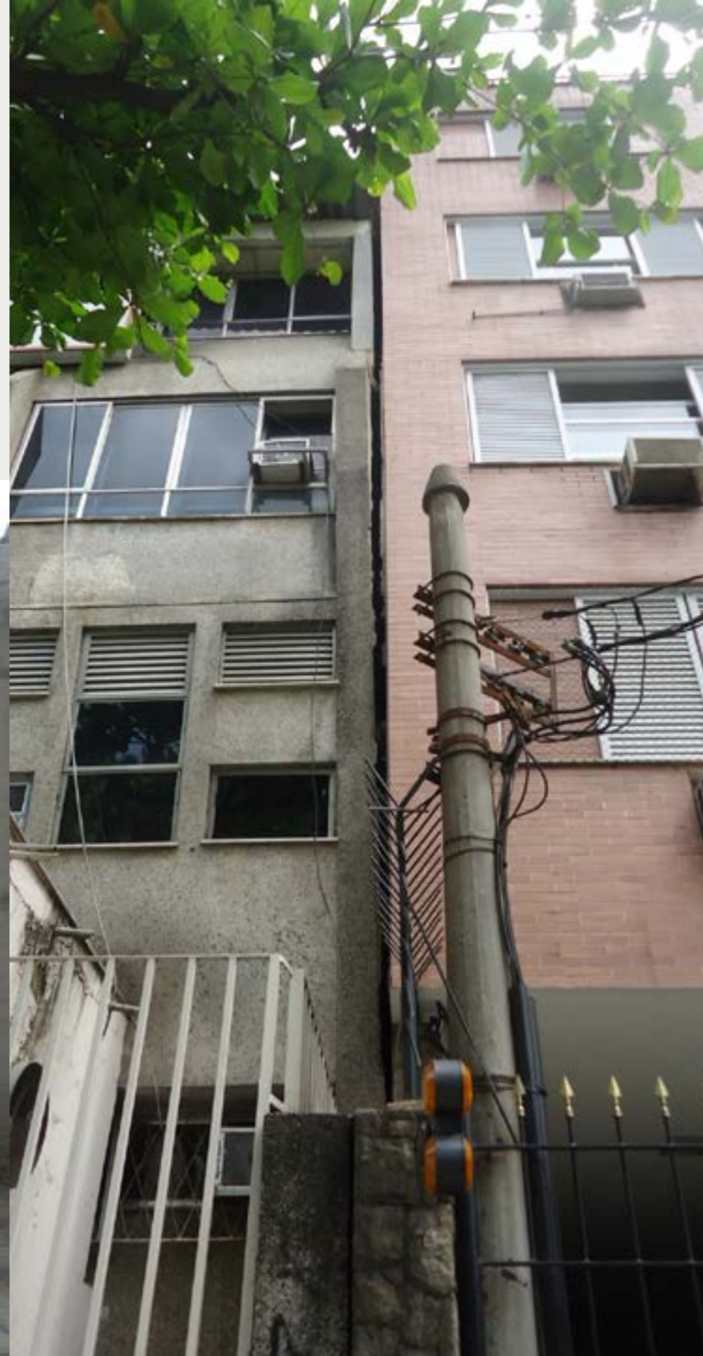
Figura 9 - Recalque diferencial, entre dois prédios, promovido pela diferença no sistema de fundação de ambos os prédios.
