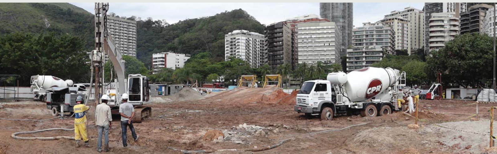
Figura 5 - Grandes áreas, com solos ultra moles, entorno da Lagoa Rodrigo de Freitas sendo geoenrijecidas.
