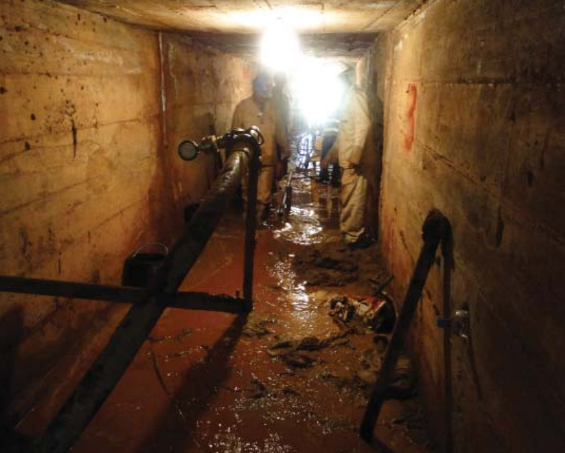
Figura 5 - Equipamentos portáteis permitiram furar a galeria e o solo, tanto pelos lados quanto em seu piso, adentrando-se no solo o suficiente para eliminar a compressibilidade atuante.
