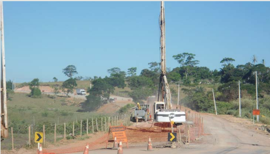
Figura 19 - Rupturas ao longo de um trecho de duplicação rodoviária recebem o geoenrijecimento do solo.
