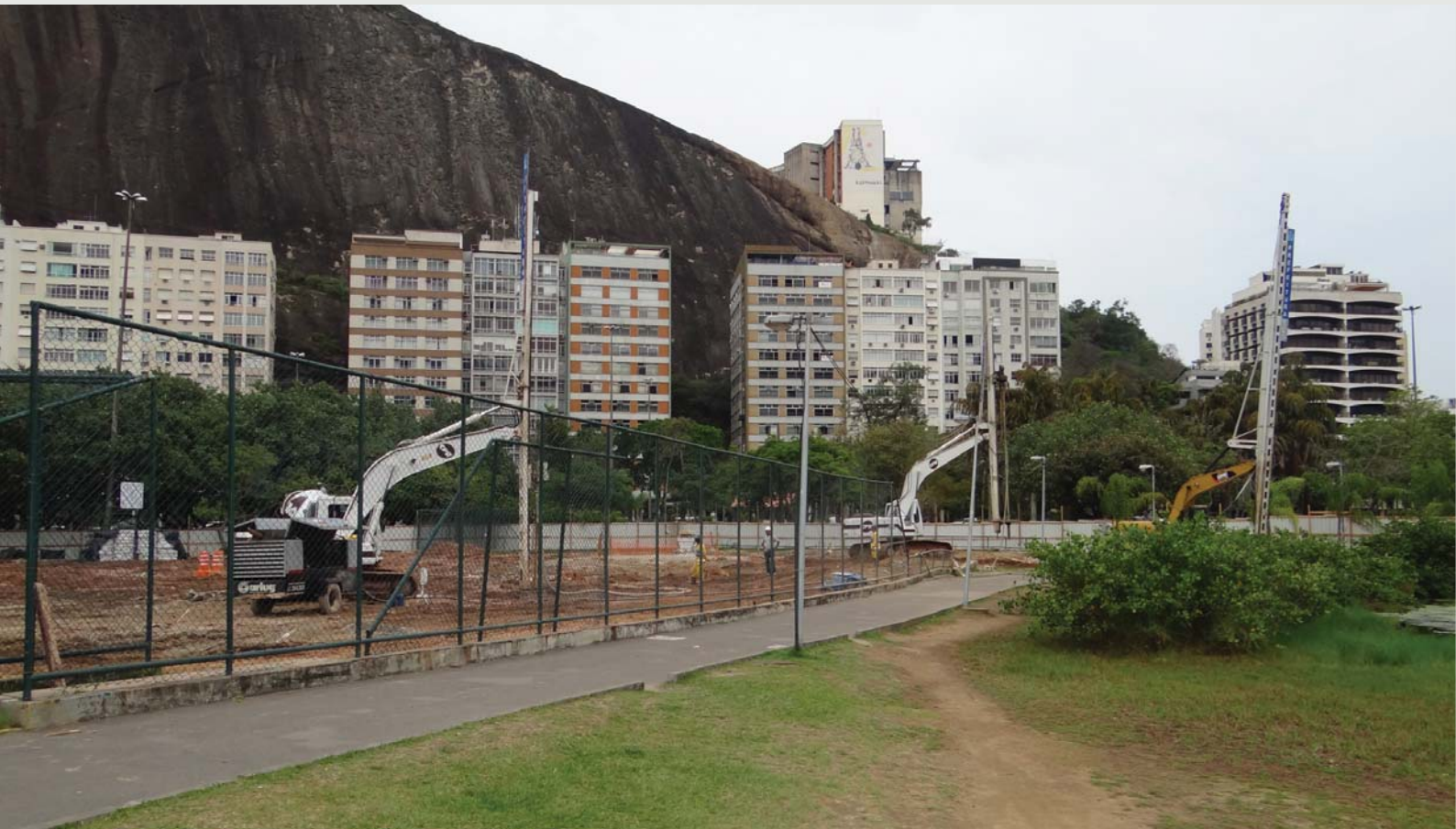
Figura 9 - Área entorno da Lagoa Rodrigo de Freitas, RJ, com presença de solos orgânicos ultra moles com 30m de profundidade sendo geoenrijecidos.
