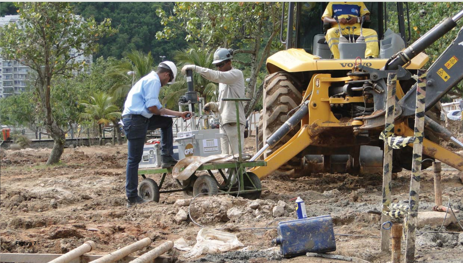
Figura 7 - Ensaios pressiométricos certificam o geoenrijecimento do solo mole na orla da Lagoa Rodrigo de Freitas.
