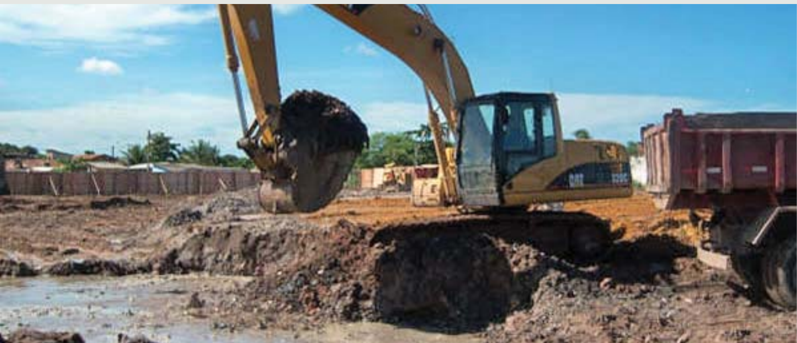
Figura 14 - Após o melhoramento do solo, está se removendo parte do aterro (resto da construção), para substituição por material compactável, de modo a receber elementos de fundação direta.
