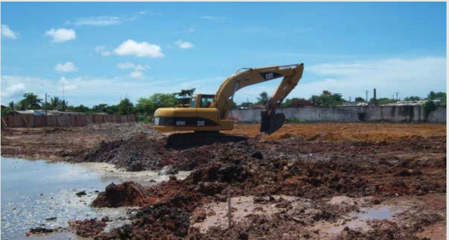
Figura 4 - Nesta região, em Recife, prepara-se o aterro de conquista para início do geoenrijecimento de solos moles orgânicos para posterior construção de casas populares com dois andares.
