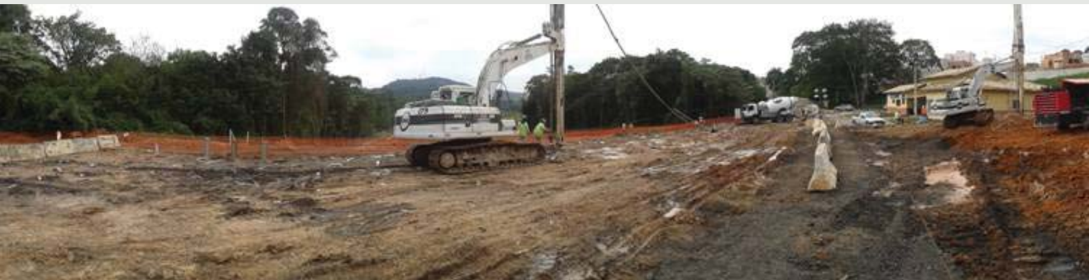
Figura 6 - O geoenrijecimento prévio de depósitos de solos moles permite posterior escavação do terreno...
