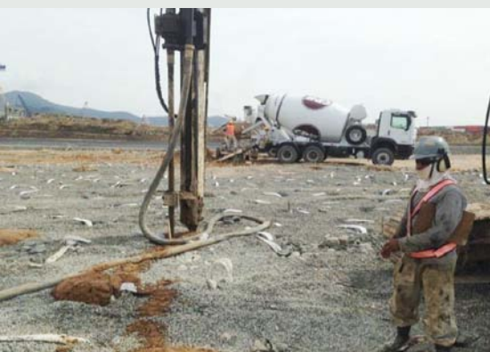
Figura 14- Após a cravação dos geodrenos, a execução das verticais com bulbos de compressão radial do solo.
