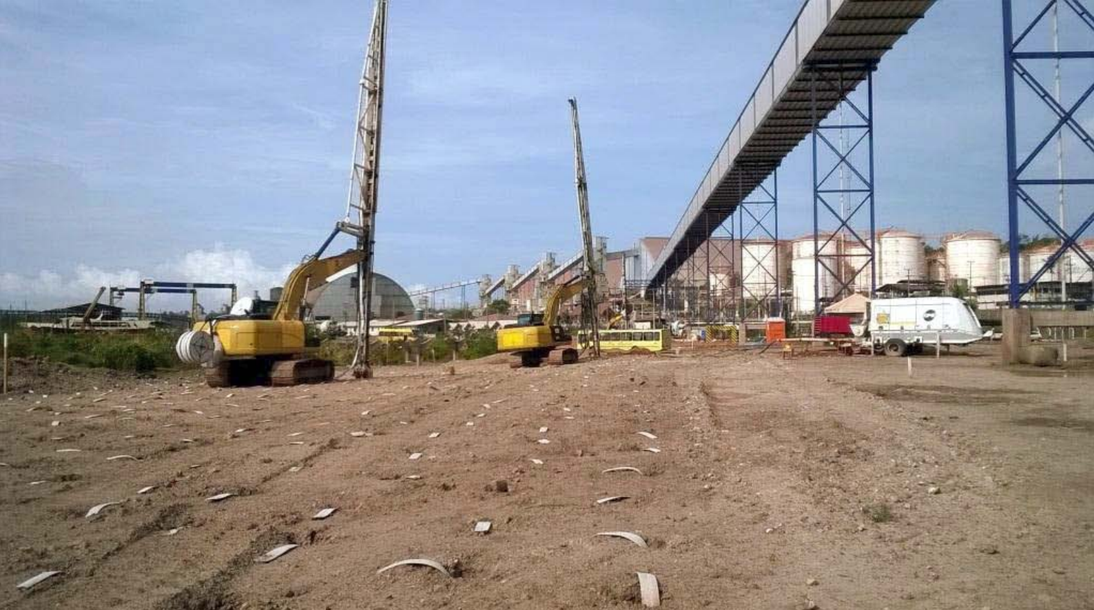
Figura 7 - Cravação de geodrenos. Obras de geoenrijecimento de depósitos de solo argiloso mole, sob aterro, recém lançado, de modo a viabilizar a construção de ferrovia no Porto do Itaqui, Maranhão. Cinco metros de aterro cobrem depósitos de solo mole.
