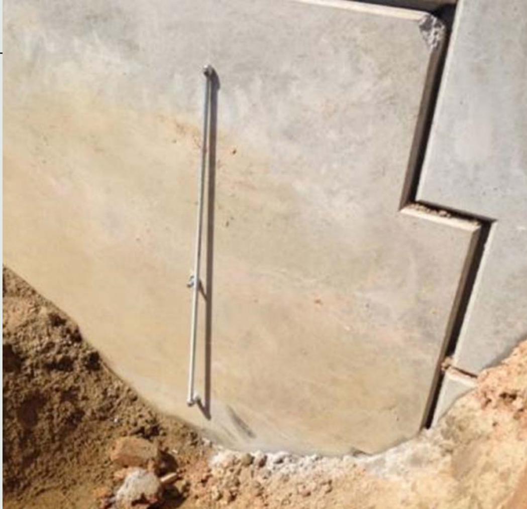
Figura 6 - Instalação do parabolts-18 A. Na superfície do elemento pré-moldado.
