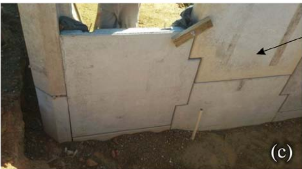
Figura 5 - Instalação das placas de recalque. (a) Posicionamento da placa na cava, abaixo da sapatinha corrida. (b) Reaterro da cava de instalação. (c) Emenda da haste interna e tubo de proteção ao lado da parede.
