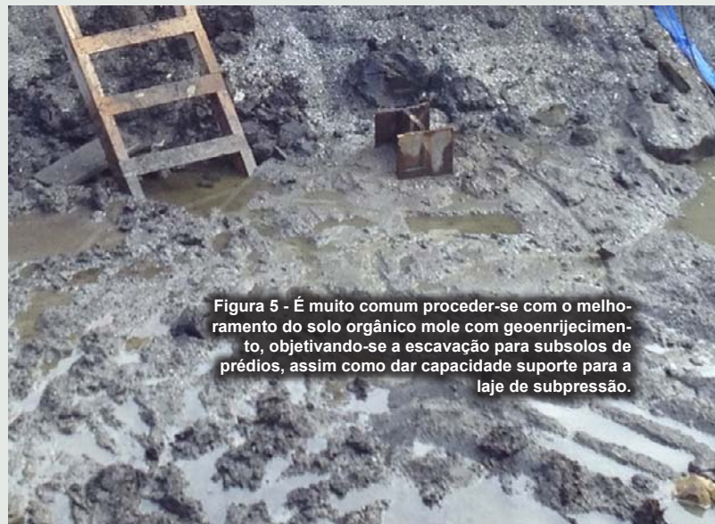
Figura 4 - Torna-se importante analisar a presença de turfas nas sondagens, pois exigem cuidados especiais durante o melhoramento do solo.
