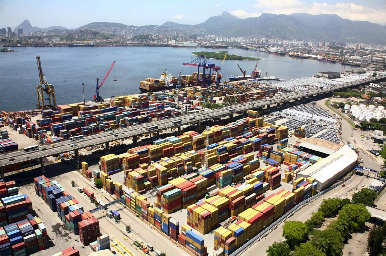
Figura 9 - Porto do Rio de Janeiro com infraestrutura do tipo sólida. Geoenrijecimento de solo na retroárea.
