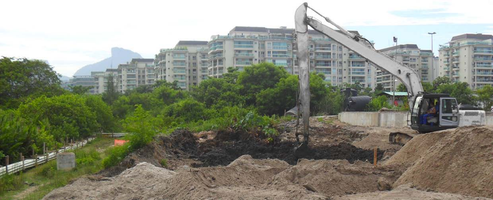
Figura 9 - Presença de solo turfoso em terreno onde, mais tarde, seria construído um grande empreendimento residencial. Foi feito a remoção da vegetação e a colocação de aterro de conquista para iniciar-se o geoenrijecimento do solo, objetivando-se a escavação a -3m e capacidade suporte para toda a infraestrutura de aterro circundante.
